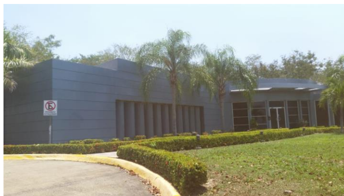
Ilustración 8. Inmueble del Edificio Administrativo
