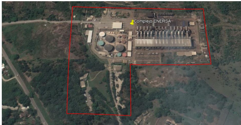
Ilustración 7. Ubicación de Instalación Fotovoltaica
