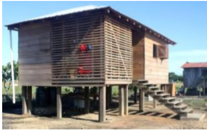
Ilustración 29: Vivienda de madera, La Mosquita
