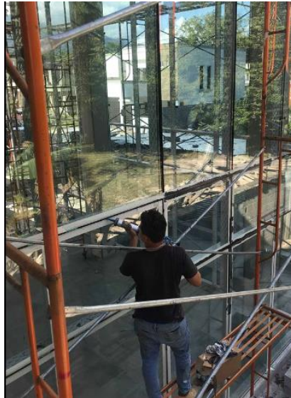
Ilustración 52: Aplicación de sellador en juntas
