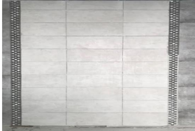
Ilustración 113: Detalle listelos en baño principal
