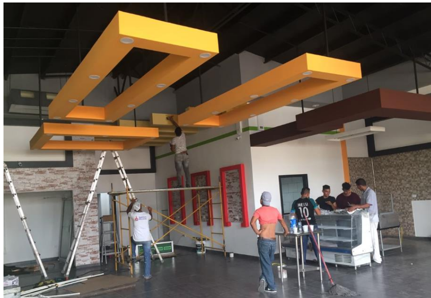
Ilustración 119: Trabajo en pintura de elementos colgantes
