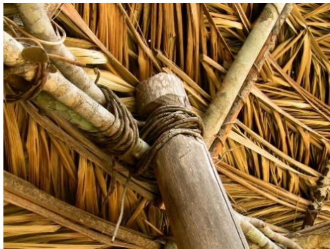
Ilustración 6: Detalle de intersección de viga y horcón
