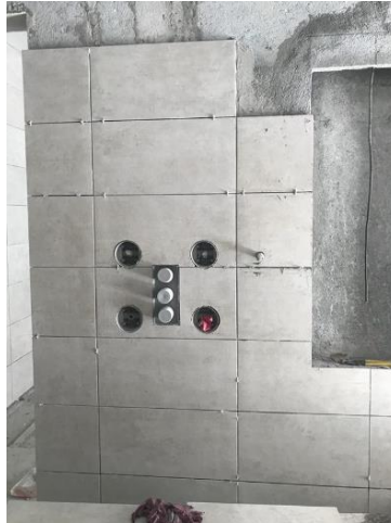
Ilustración 76: Instalación de cerámica área de ducha.
