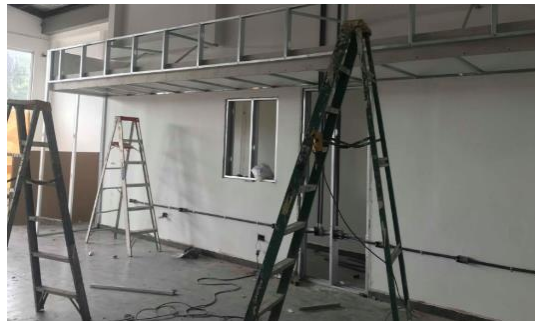
Ilustración 85: Instalación de estructura metálica para tabla yeso en fascias.
