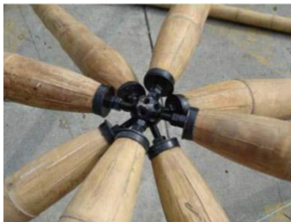
Ilustración 18: Unión cónica con esfera
