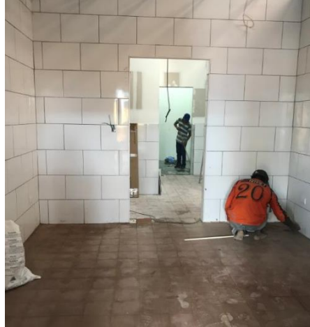
Ilustración 111: Instalación de baldosas en área de cocina
