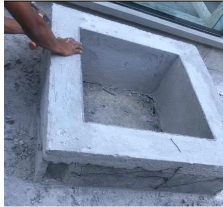
Ilustración 89: Picado de repello
