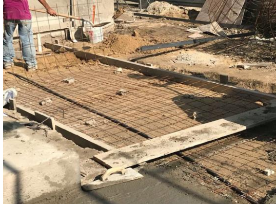
Ilustración 35: Fundición de espejos de agua
