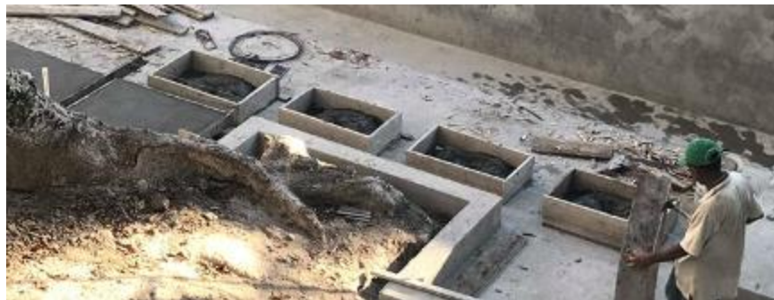
Ilustración 88: Fundición de pasos
