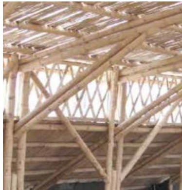
Ilustración 24: Arriostres y diagonales de bambú
