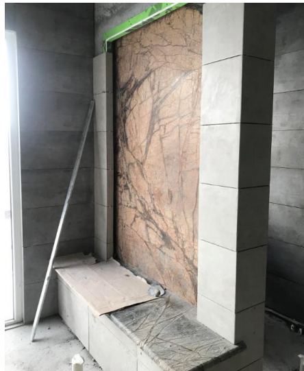
Ilustración 112: Instalación de cerámica en área de ducha
