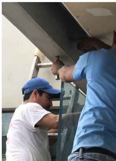
Ilustración 100: Instalación de vidrios
