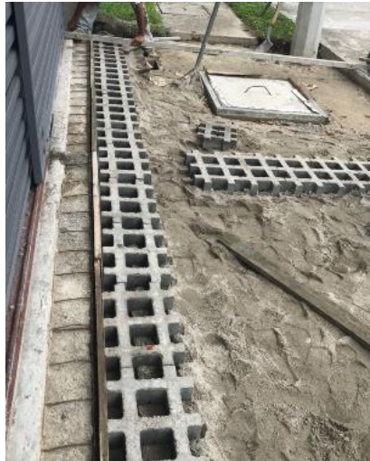
Ilustración 104: Colocación de adoquines
