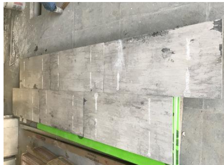
Ilustración 58: Prueba colocación de piezas
