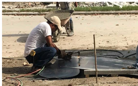
Ilustración 36: Gradas con Estructura Metálica
