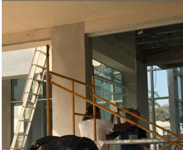
Ilustración 118: Instalación de puertas tipo acordeón
