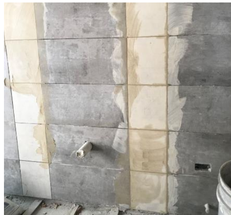
Ilustración 117: Fraguado de pared en baño principal
