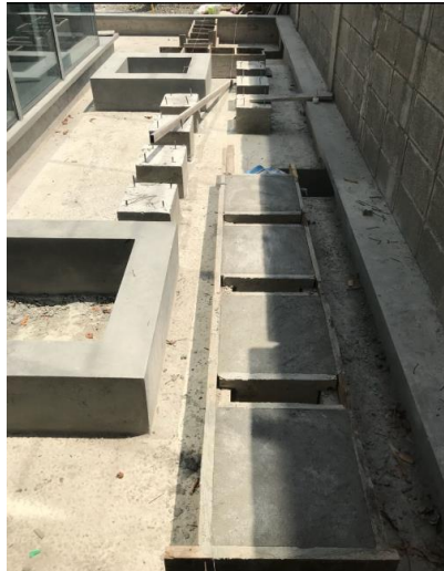
Ilustración 115: Fundición de pasos de circulación
