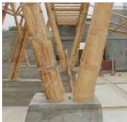
Ilustración 23: Colocación de columnas de bambú
