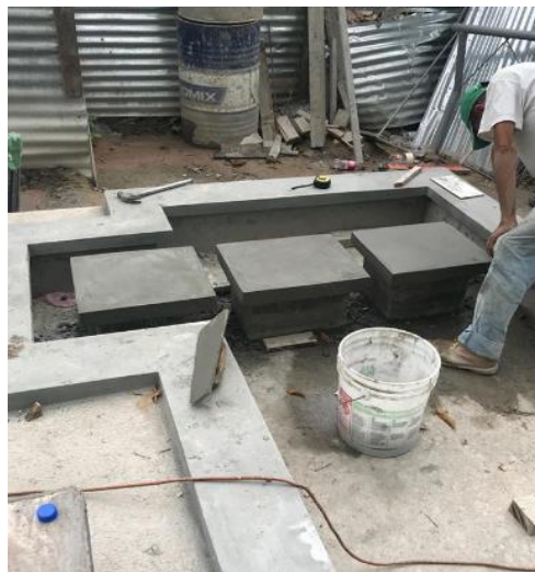
Ilustración 83: Pulido de pasos de circulación.
