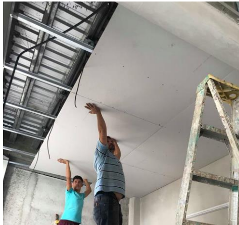
Ilustración 50: Instalación de tabla yeso, área de cocina
