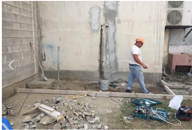
Ilustración 120: Limpieza de área para fundición de plancha
