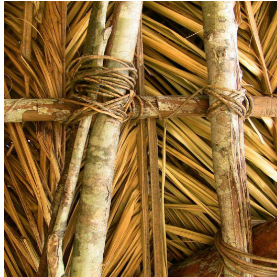
Ilustración 5: Detalle del amarre con bejuco en una pared de palma
