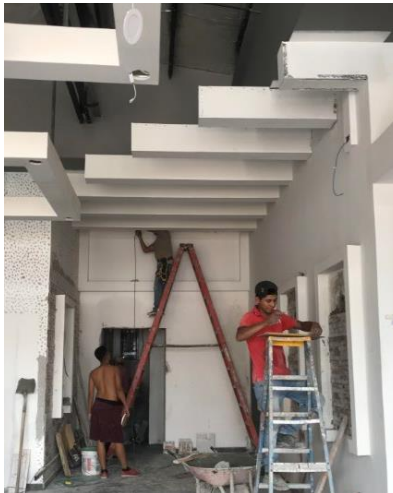
Ilustración 110: Instalación de fachaleta y detalles de tabla yeso
