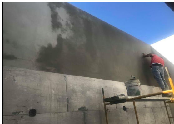
Ilustración 75: Pulido en área de terraza
