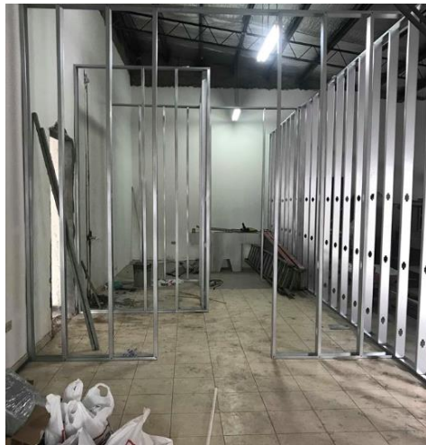
Ilustración 84: Instalación de perfiles metálicos para tabla yeso.
