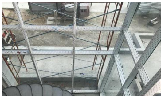
Ilustración 55: Instalación de perfiles metálicos en muro cortina.
