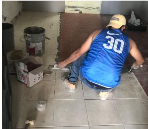
Ilustración 105: Instalación de nueva cerámica
