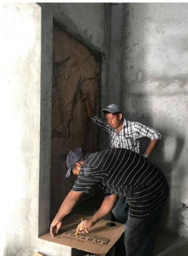
Ilustración 51: Instalación de mármol
