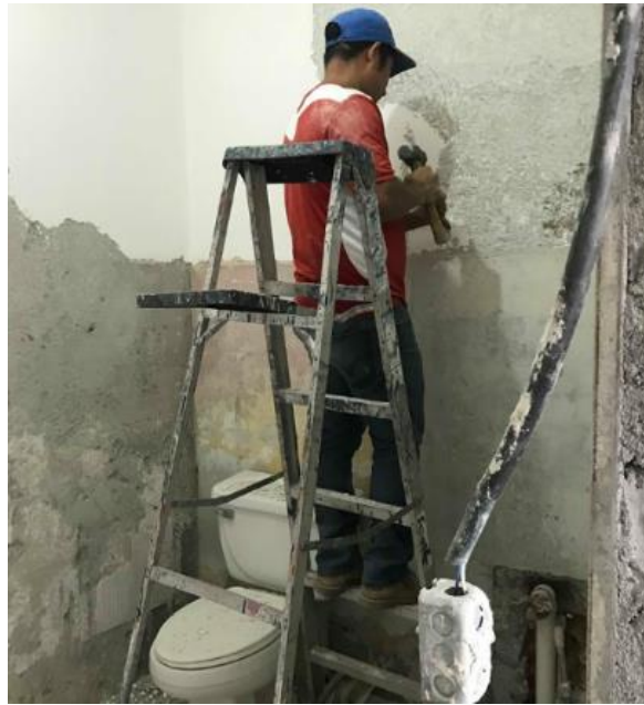
Ilustración 87: Picado de pared.
