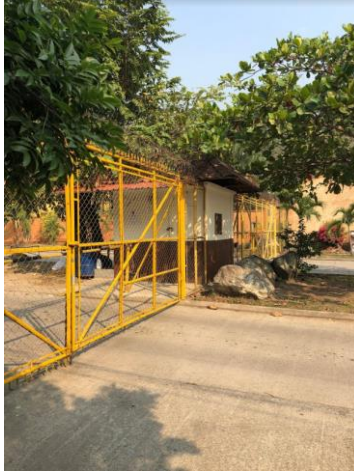
Ilustración 26 Caseta secundaria residencia Pedregal
