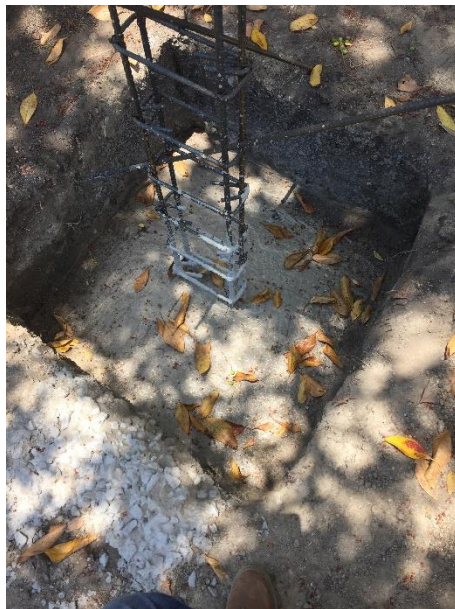
Ilustración 23 Fundición de zapata aislada apartamento Guillermo Bográn
