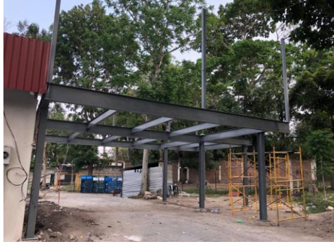
Ilustración 35 Supervisión de estructura oficina G+a
