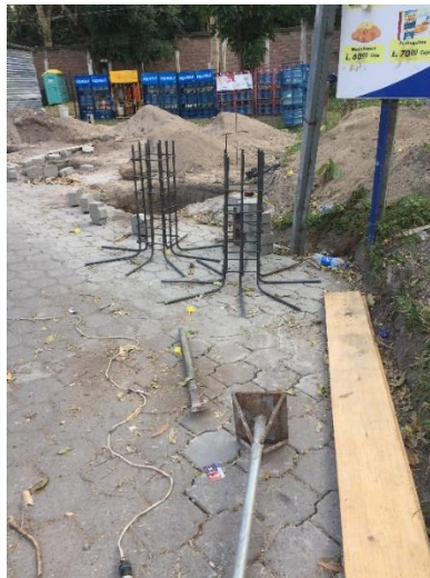
Ilustración 19 Armado de zapatas aisladas oficinas Grupo Arquitectos
