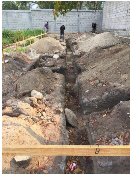
Ilustración 21 Excavaciones para zapata corrido apartamento Guillermo Bográn
