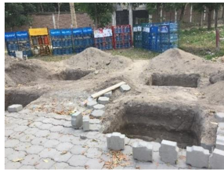
Ilustración 18 Excavación para zapatas aisladas oficinas Grupo Arquitectos
