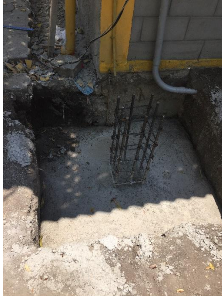
Ilustración 24 Fundición de zapata aislada oficinas Grupo Arquitectos
