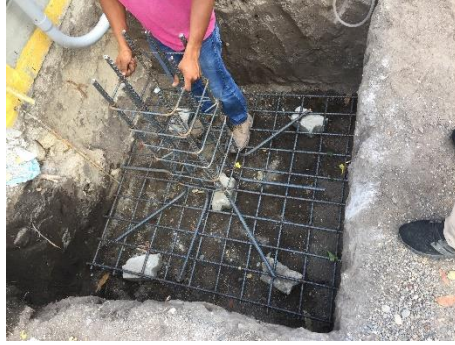
Ilustración 20 Ubicación de armado para fundir zapata oficinas Grupo Arquitectos
