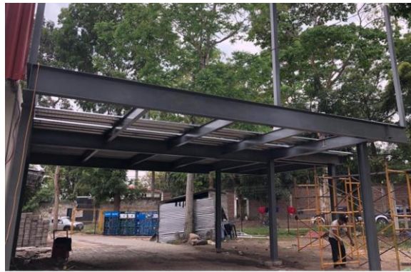
Ilustración 36 Instalación de lámina cero oficinas G+a
