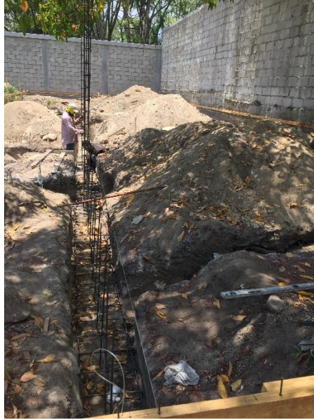
Ilustración 22 Colocación de armado de zapata corrida apartamento Guillermo Bográn
