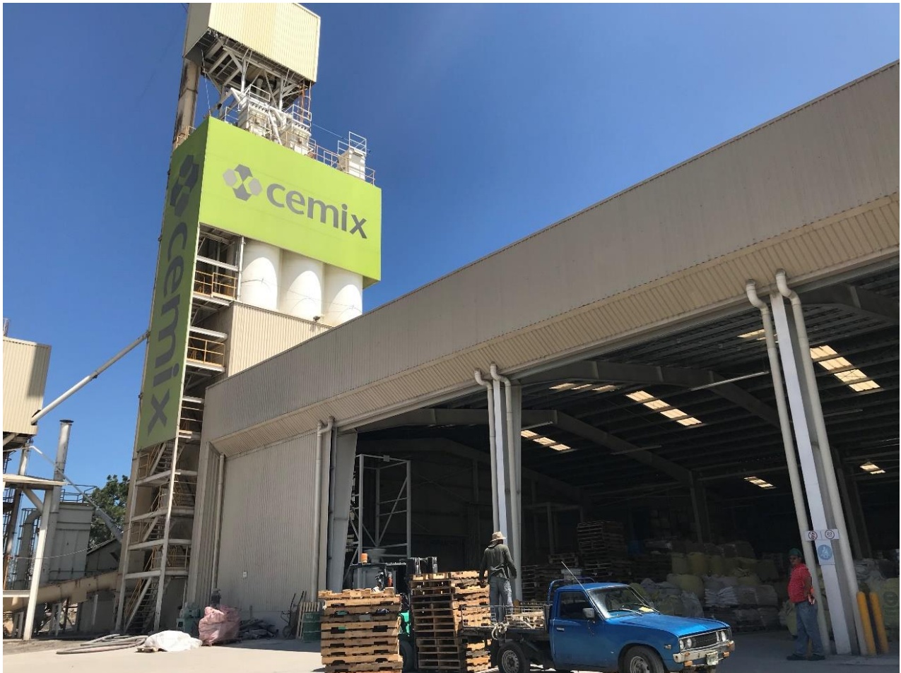
Ilustración 67: Área de descarga y almacén en nave industrial, CEMIX
