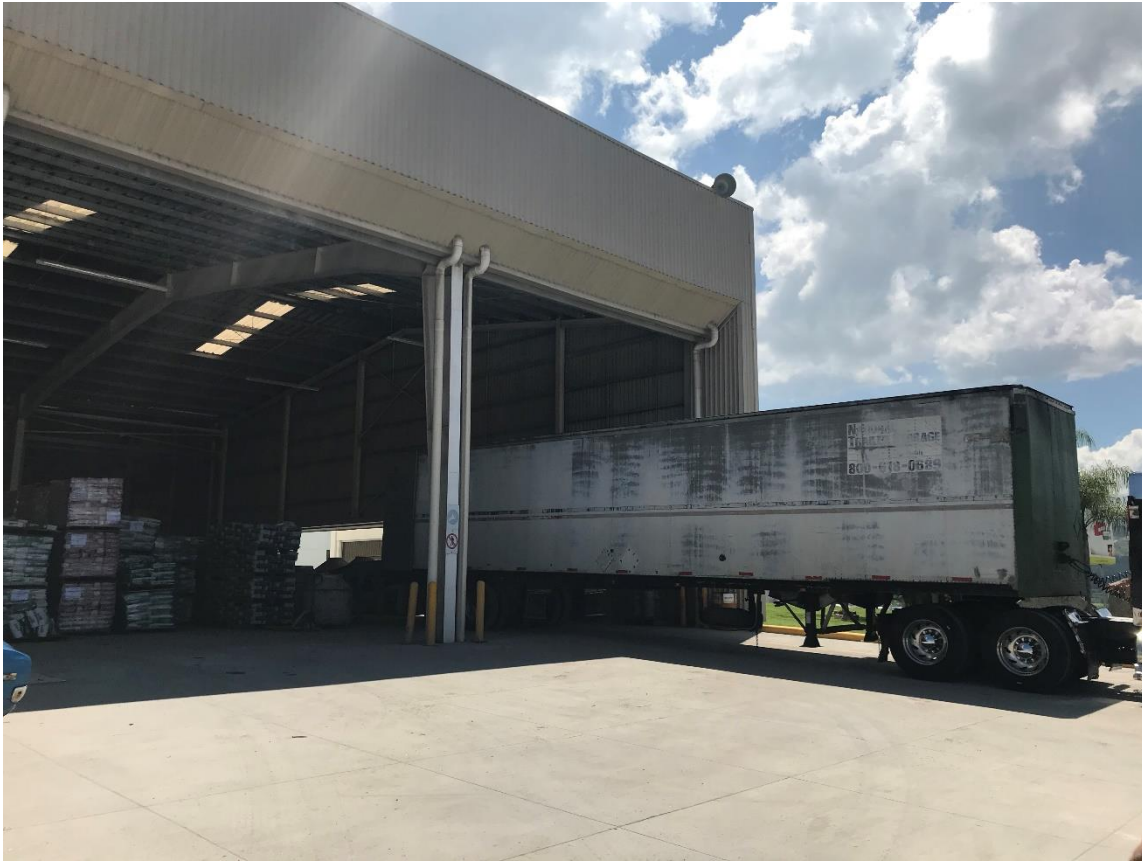
Ilustración 68: Área de descarga y almacén en nave industrial, CEMIX
