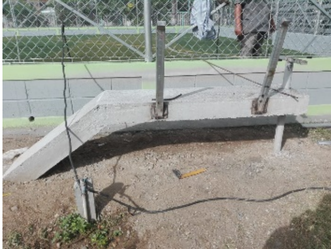
Ilustración 39 Instalación de banca en canchas deportivas de Museo Ferroviario.
