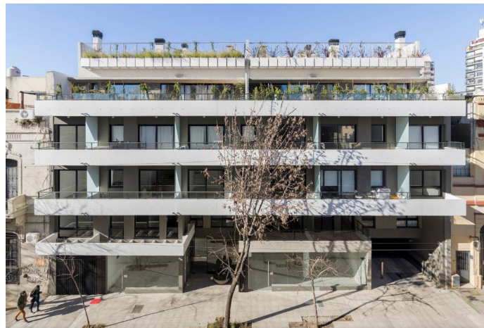
Ilustración 30. Perspectiva Exterior del Edificio JA1205
