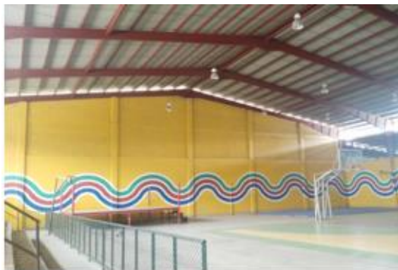
Ilustración 62. Estado actual del Palacio Municipal de los Deportes.
