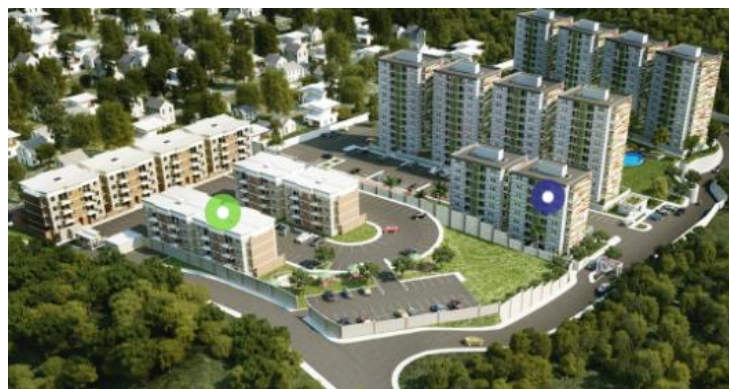
Ilustración 9. Complejo Eco Vivienda Fase 1 y Fase 2.
