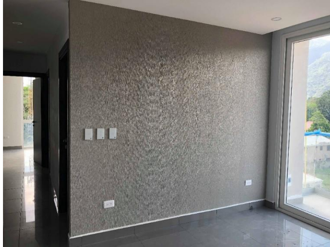
Ilustración 113. Trabajo finalizado en pared de sala
