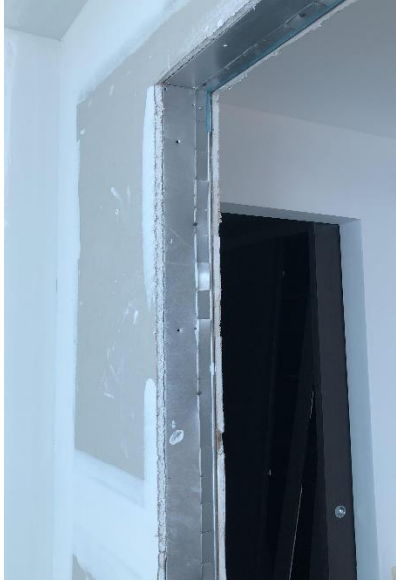
Ilustración 117. Corrección en doble pared de baño principal
