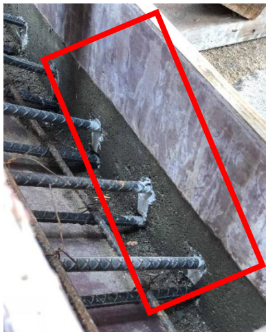
Ilustración 130. Adhesivo utilizado en estructura de gradas
