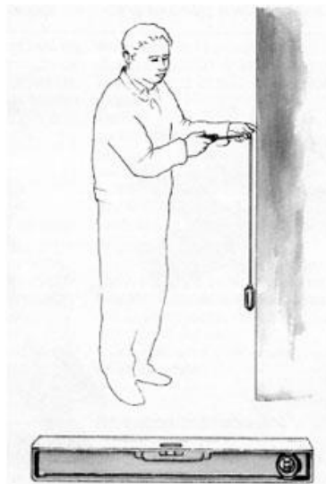
Ilustración 84. Utilización de la plomada en muro
