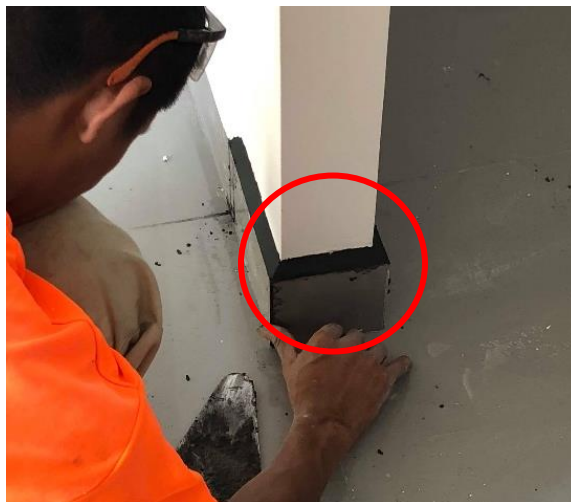
Ilustración 77. Cambio de remate en condominio 2DS
