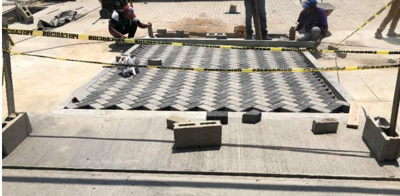
Ilustración 122. Pendiente en rampa de acceso principal
