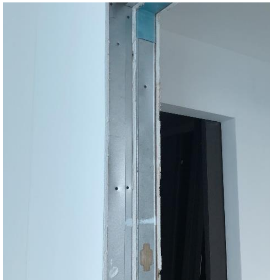
Ilustración 116. Solución errónea en boquete de puerta
