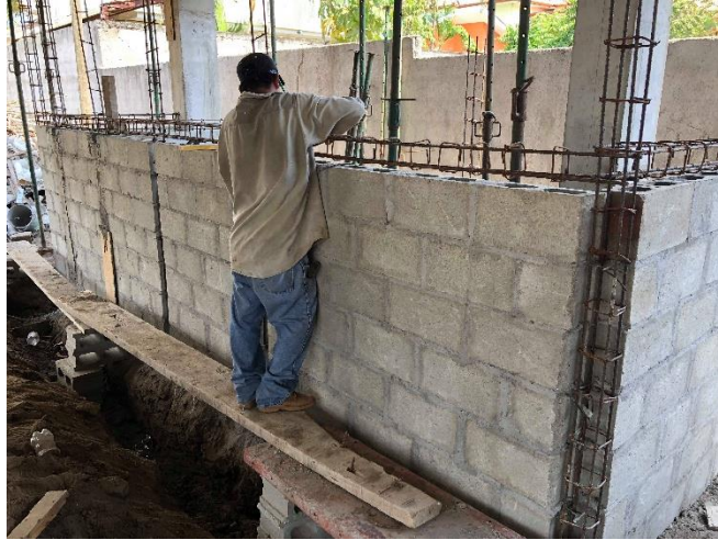
Ilustración 99. Armado de solera intermedia
