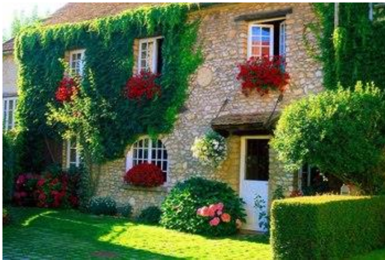
Ilustración 44. Fachada exterior verde
