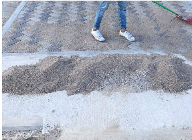
Ilustración 143. Proceso de sellado en adoquín acceso a la torre
