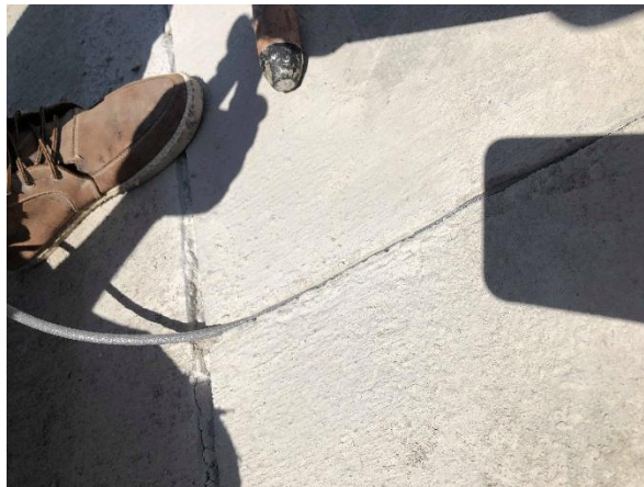
Ilustración 86. Colocación de del sellador y manguera
