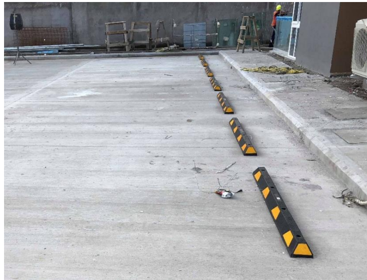
Ilustración 136. Topes para estacionamientos
