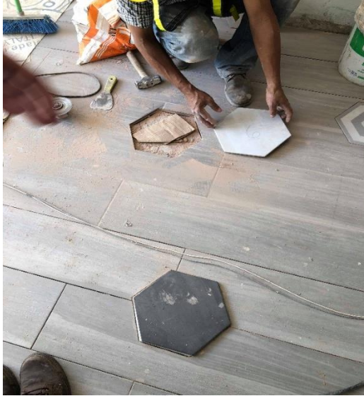
Ilustración 49. Colocado de cerámica en pasillo
