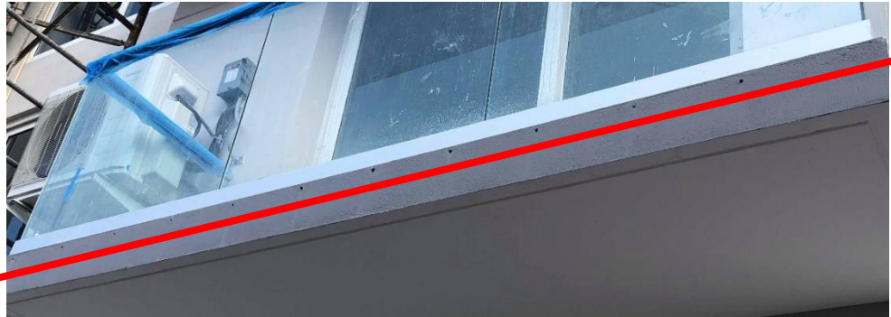
Ilustración 146. Desagües en terraza de condominio 2C
