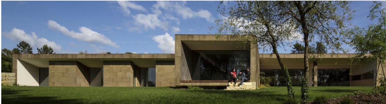
Ilustración 40. Fachada frontal casa en Leiria
