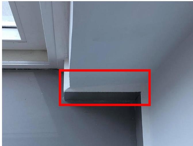
Ilustración 138. Error en acabado de zócalo
