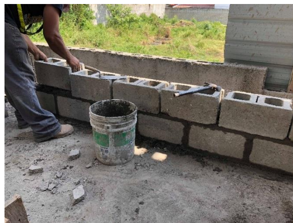
Ilustración 98. Hilada de bloques
