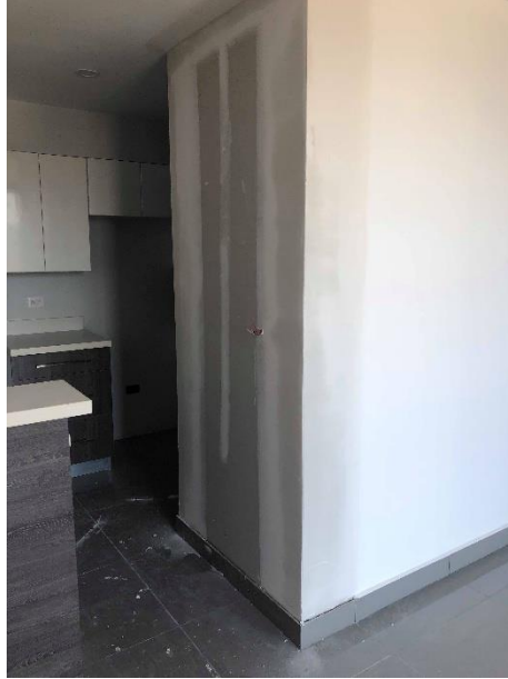
Ilustración 81. Corrección de pared en condominio 6B
