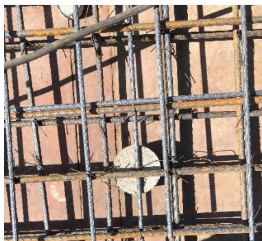
Ilustración 76. Separadores de refuerzo
