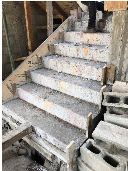
Ilustración 96. Fundición de una escalera
