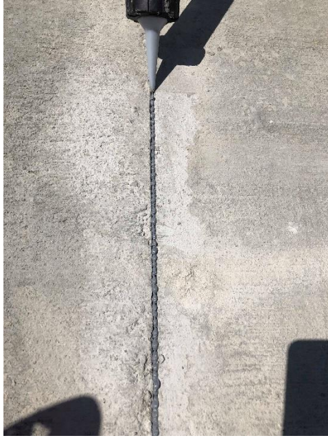
Ilustración 87. Método de aplicación del sellador
