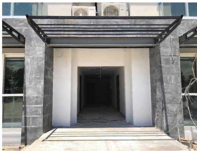
Ilustración 156. Acceso principal de la torre
