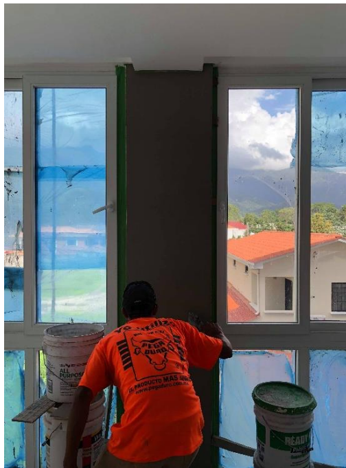
Ilustración 59. Reparación en pared de sala
