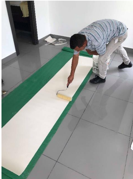
Ilustración 112. Colocado de pegamento en papel tapiz
