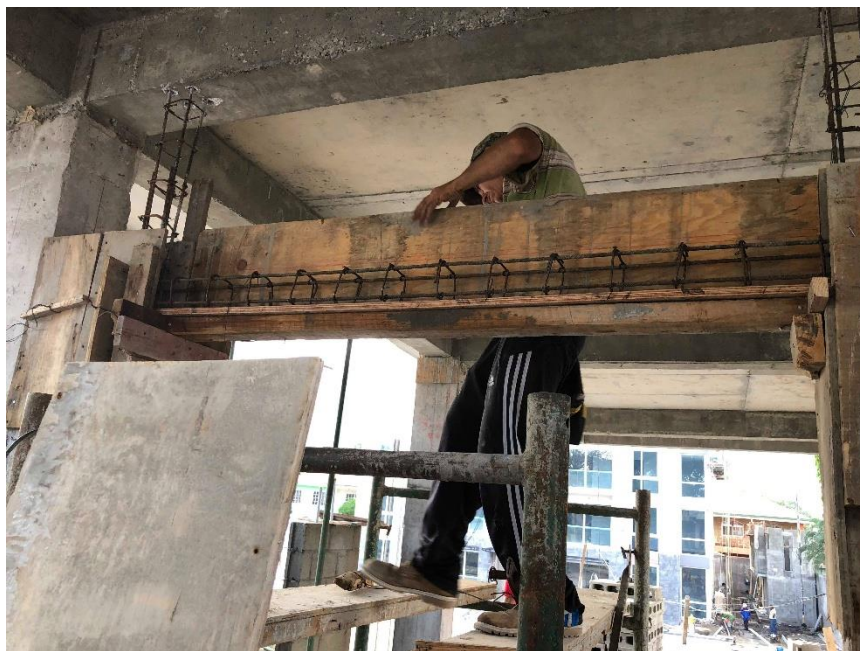
Ilustración 134. Proceso de ejecución cargador para puerta
