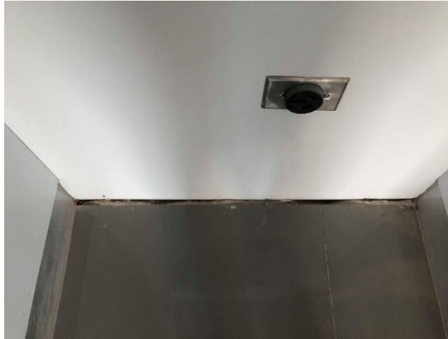
Ilustración 60. Trabajo incompleto en unión
