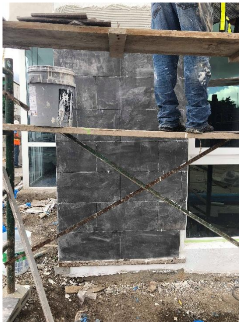
Ilustración 51. Colocado de enchape en fachada frontal
