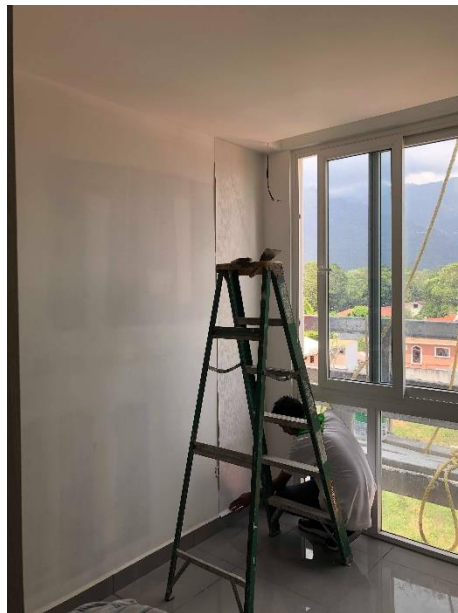
Ilustración 114. Proceso de instalación papel tapiz
