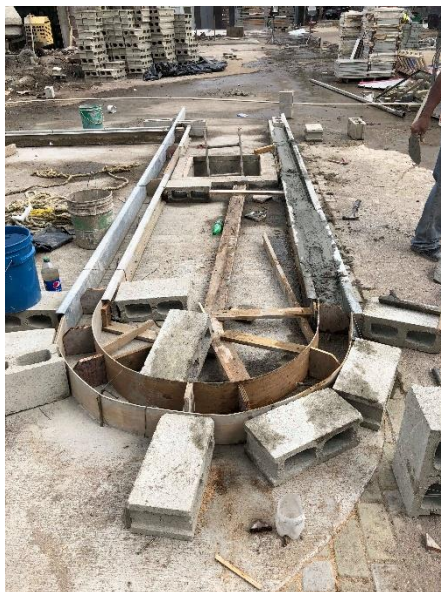
Ilustración 111. Encofrado de mediana en área exterior
