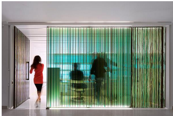
Ilustración 42. Vidrio reciclado utilizado en paredes
