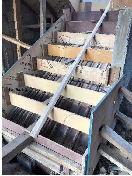
Ilustración 95. Estructura del encofrado de una escalera
