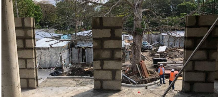
Ilustración 129. Boquetes para ventanas
