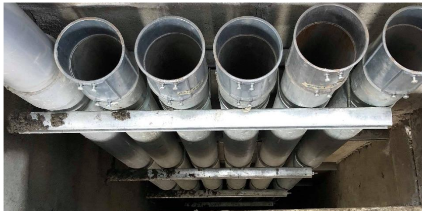
Ilustración 132. Estructura metálica para estabilidad en ductos
