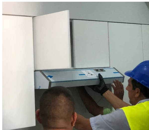
Ilustración 106. Proceso de instalación de campana
