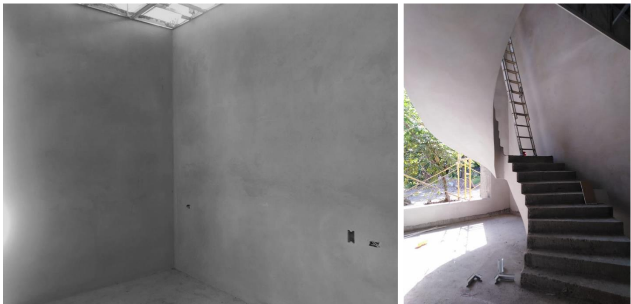
Ilustración 91 Acabado de Pulido en Paredes Internas y Escalera Principal
