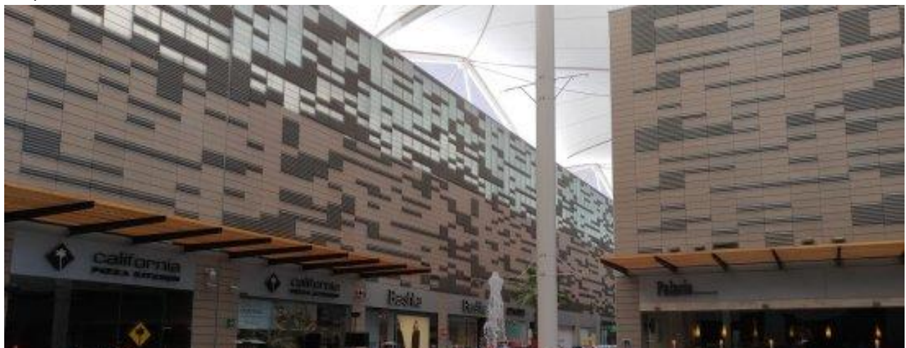
Ilustración 16 Fachada Tablillas de Terracota usados en el Centro Comercial Paseo Acoxpa.
