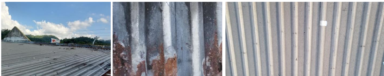
Ilustración 129 Registro Fotográfico de las Láminas de Aluzinc de las Cubierta (Segmento 1 & 2)
