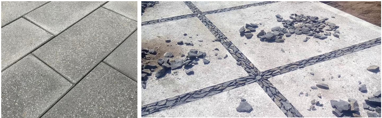
Ilustración 46 Acabado y Losetas de Concreto Martelinado para Exteriores.
