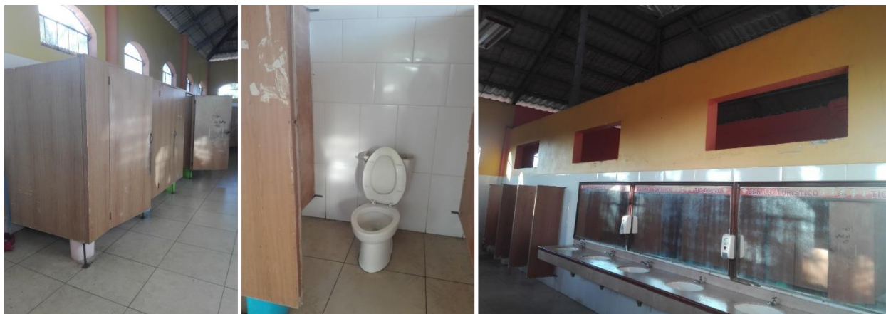
Ilustración 106 Registro Fotográfico del Núcleo Sanitario del Restaurante.
