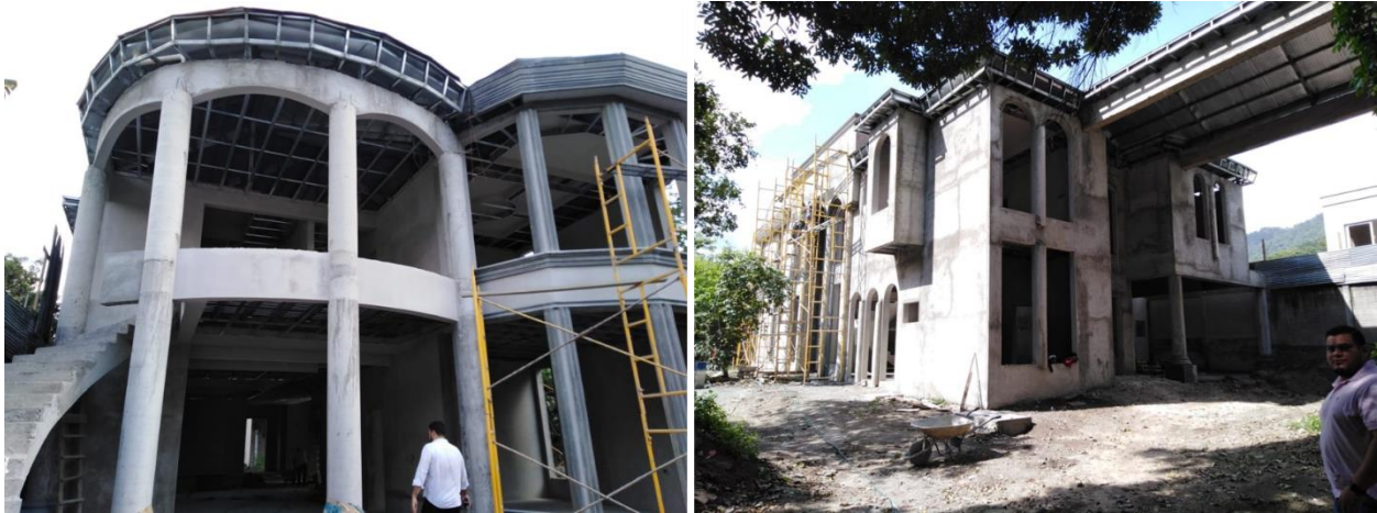
Ilustración 89 Avance de Obra del Repello de Paredes Exteriores.
