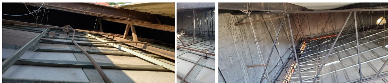
Ilustración 131 Registro Fotográfico del Interior de la Estructura del Techo (Segmento 2).
