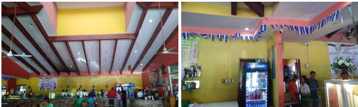
Ilustración 102 Registro Fotográfico de los Detalles de Cielo Falso Existente.
