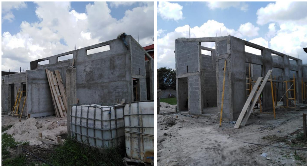
Ilustración 98 Visita e Inspección de Obra en Residencial Rancho Tara.
