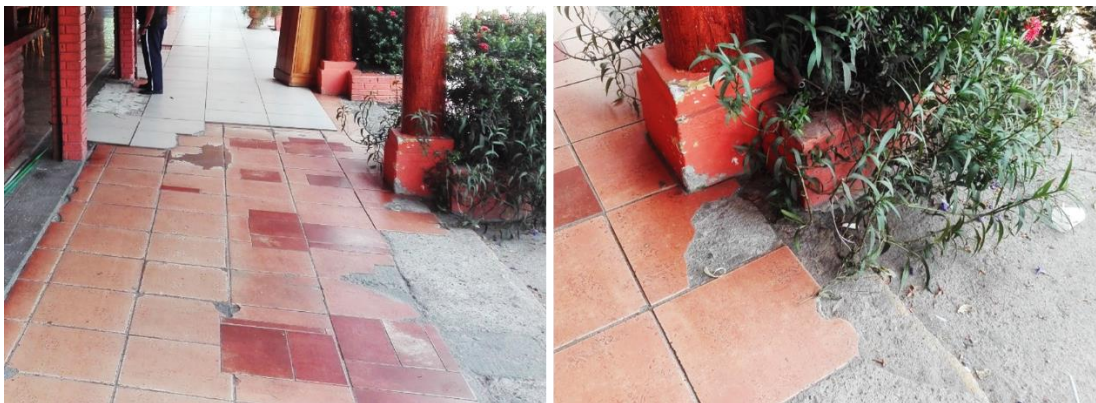
Ilustración 104 Registro Fotográfico de los Detalles de Piso Existente.
