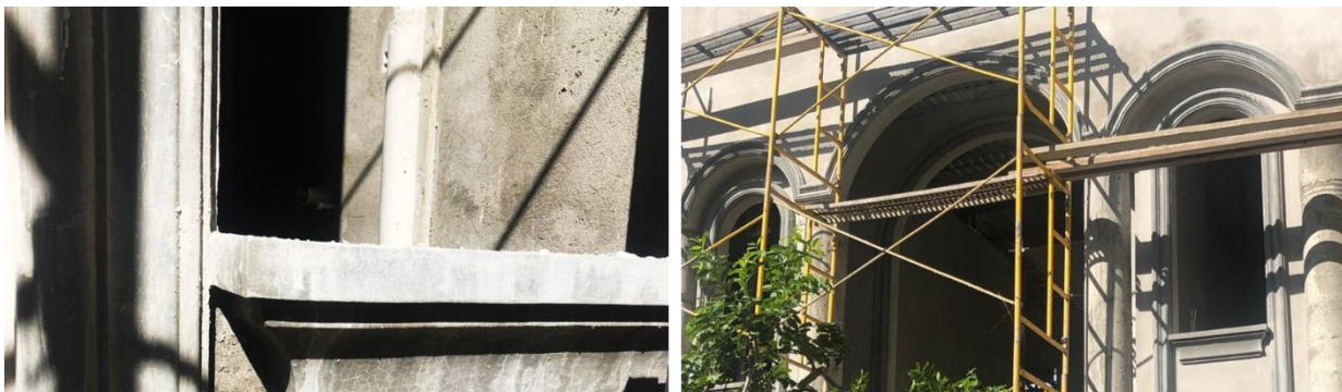
Ilustración 90 Detalle de Molduras y Alfeizar en las Ventanas
