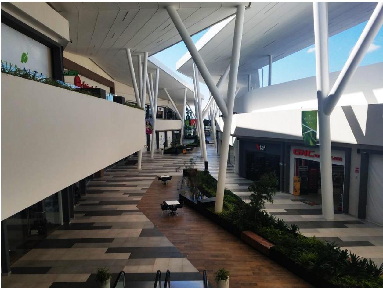
Ilustración 25 Uso de Porcelanato Para Exteriores como Revestimiento de Piso en Interior.
