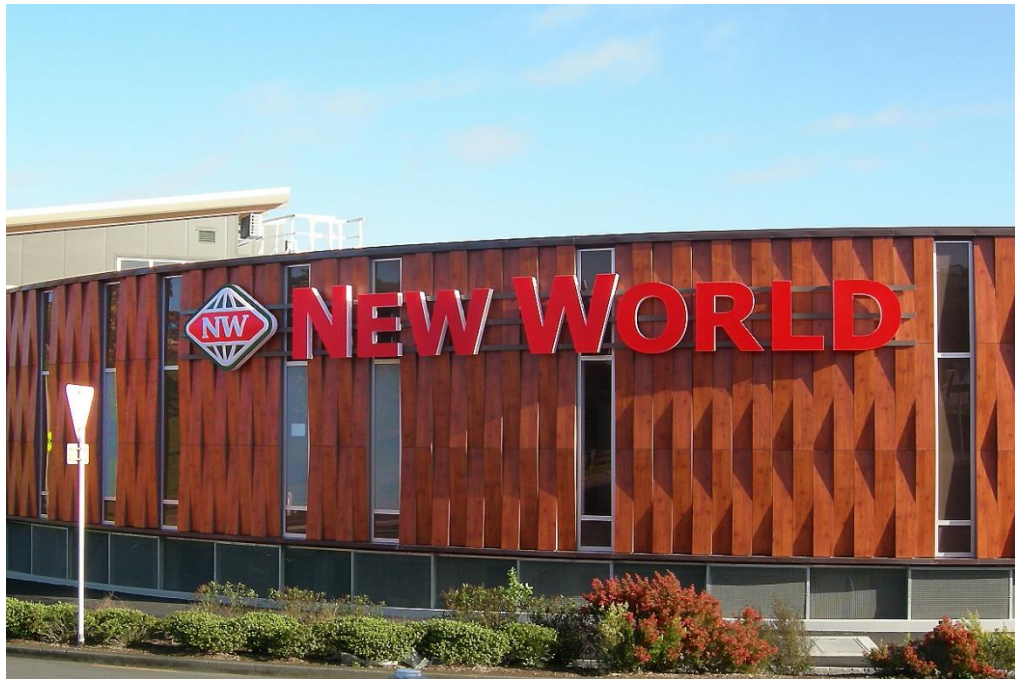
Ilustración 13 Paneles Fenólicos empleados en el Centro Comercial New World en Australia.
