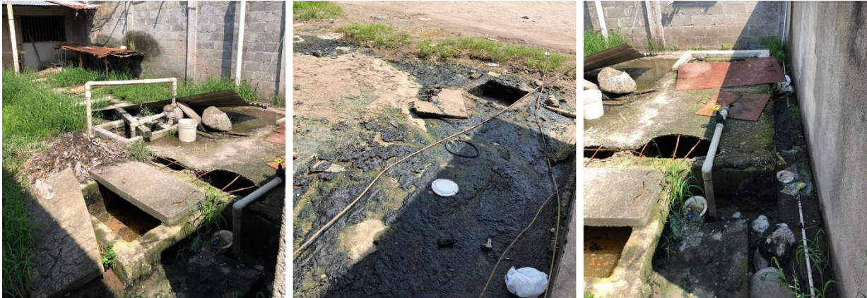
Ilustración 143 Estado Actual de las Fosas Séptica del Restaurante Tío Dolmo.
