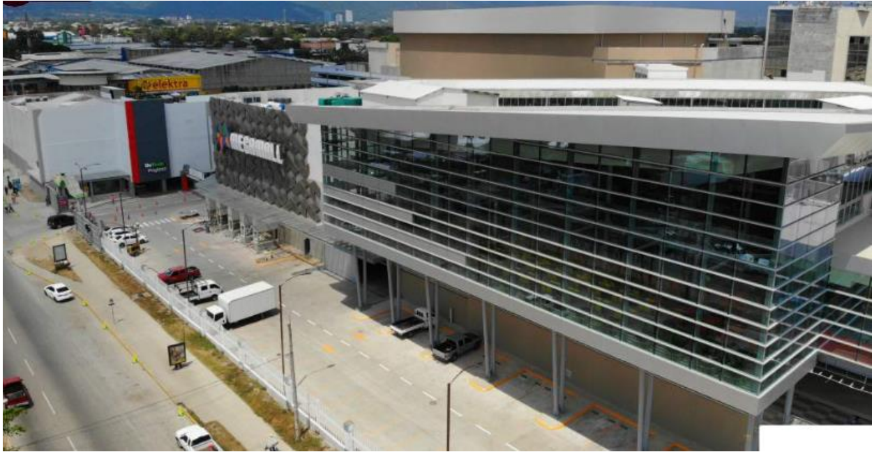
Ilustración 63 Fachada Principal de Muro Cortina Estructural Empleado en Mega Mall.
