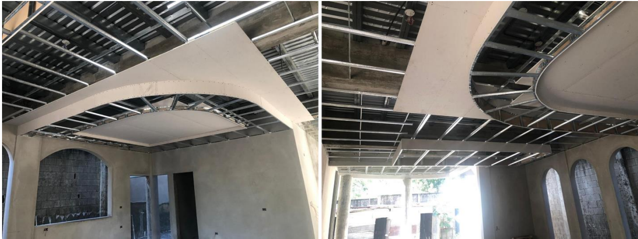
Ilustración 94 Supervisión de la instalación de las Láminas de Tabla Yeso en la Cocina.
