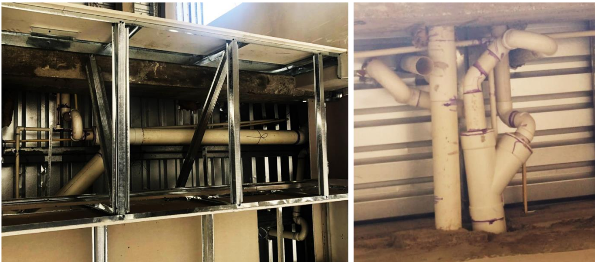
Ilustración 93 Red Hidrosanitaria de Entrepiso Inspeccionada.
