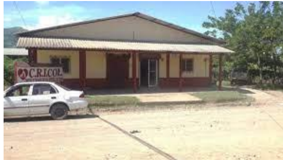
Ilustración 62. Exterior “Centro de Rehabilitación Integral de Colon”
