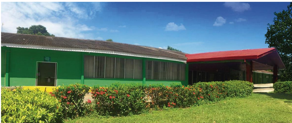
Ilustración 19. “Centro de Rehabilitación Teletón San Pedro Sula”
