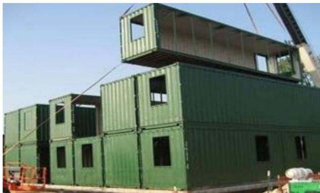
**Ilustración 26.** Colocación de un tercer nivel – Edificio de contenedores habitables en Alemania
