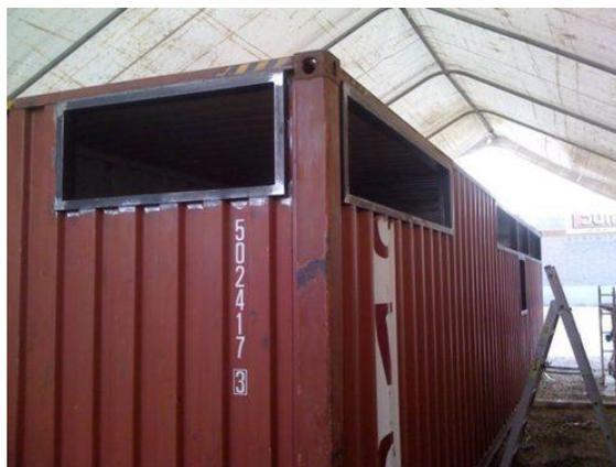
**Ilustración 51.** Colocación de marcos en el contenedor
