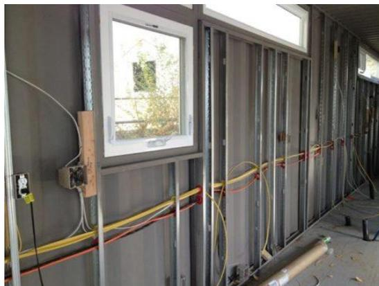
**Ilustración 78.** Colocación de canalización dentro del contenedor
