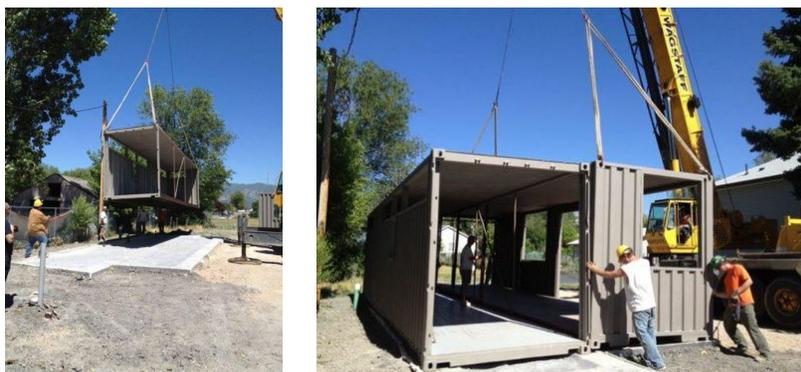
**Ilustración 75.** Colocación de los contenedores sobre los cimientos
