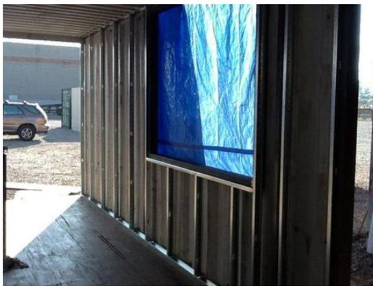
**Ilustración 49.** Cortes de puertas y ventanas en el contenedor
