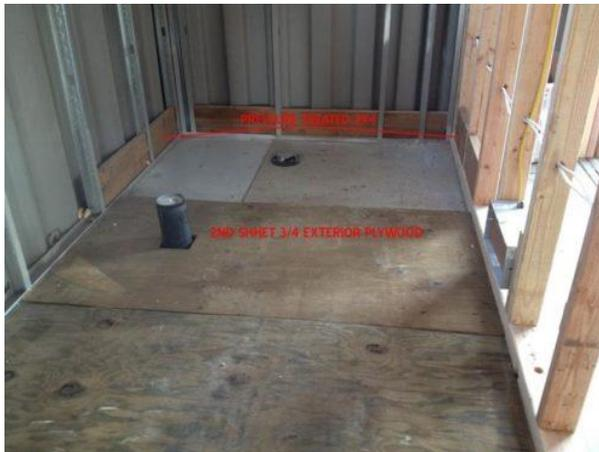
**Ilustración 83.** Sellado de piso luego de colocar tuberías
