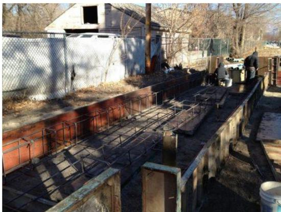
**Ilustración 73.** Colocación de barras y pilotaje
