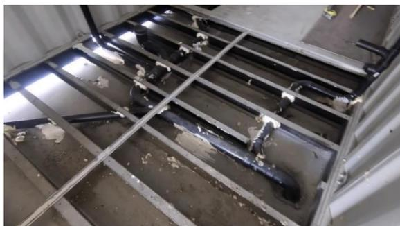
**Ilustración 82.** Tuberías bajo estructura del contenedor
