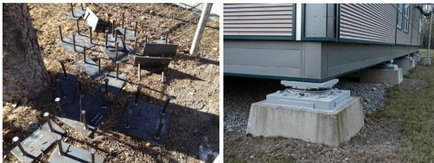
**Ilustración 76.** Ensamblaje de placas a los cimientos
