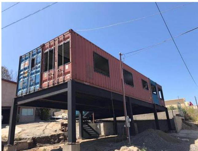
**Ilustración 72.** Cimentación con estructuras de vigas de acero
