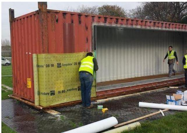
**Ilustración 47.** Colocación de marcos en aberturas del contenedor
