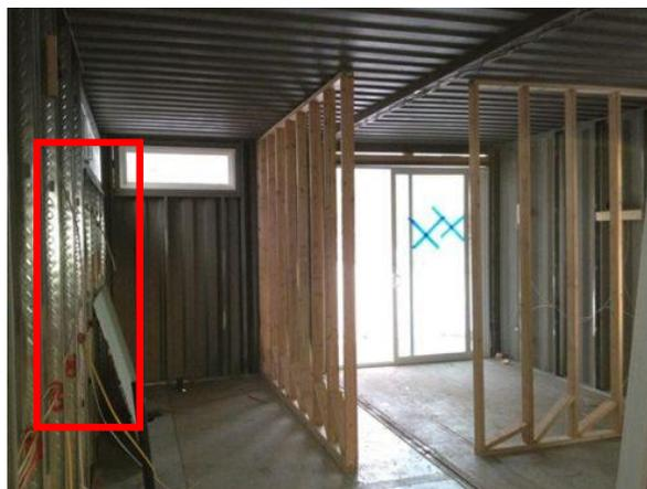
**Ilustración 77.** Marcado de líneas guías en paredes del contenedor
