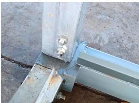
**Ilustración 15.** Detalle de la unión del marco para contenedor
