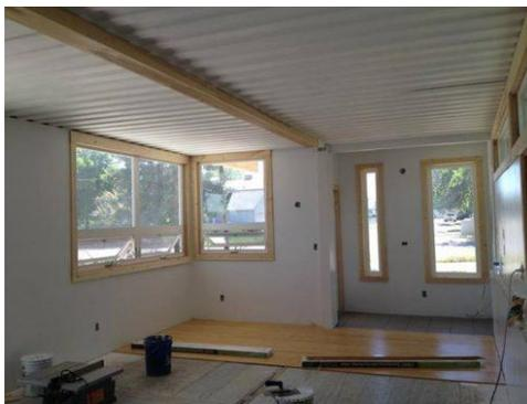
**Ilustración 57.** Acabado de madera en piso de contenedor
