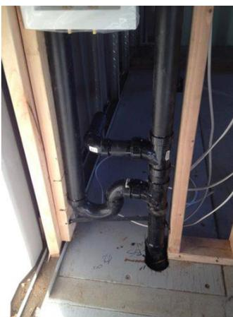
**Ilustración 81.** Instalación de tuberías dentro de los muros del contenedor
