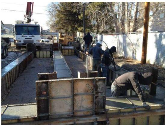
**Ilustración 74.** Encofrado y armado de bases
