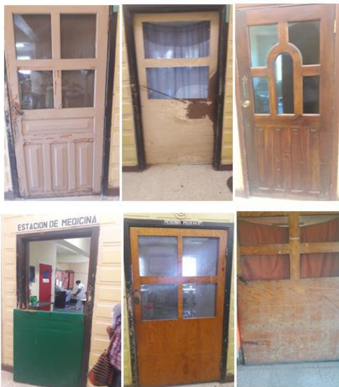
Ilustración 11. Puertas actuales hospital Manuel Subirana
