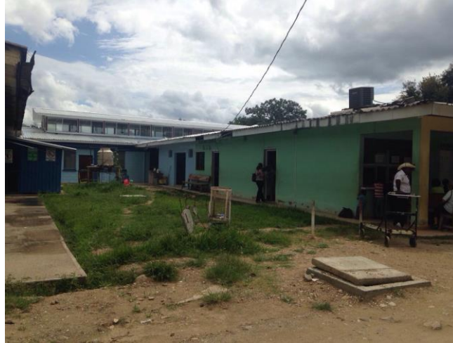
Ilustración 9. Área de mantenimiento
