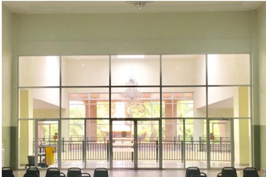
Ilustración 34. Fachada posterior interior de concreto pintado 31% y vidrio 69% con un área de 70m 2
