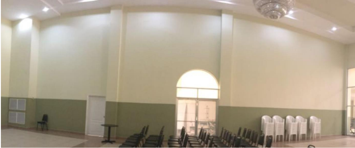
Ilustración 33. Fachada lateral derecho interior de concreto pintado 93%, vidrio 5% y madera 2% con un área de 137.2 m 2
