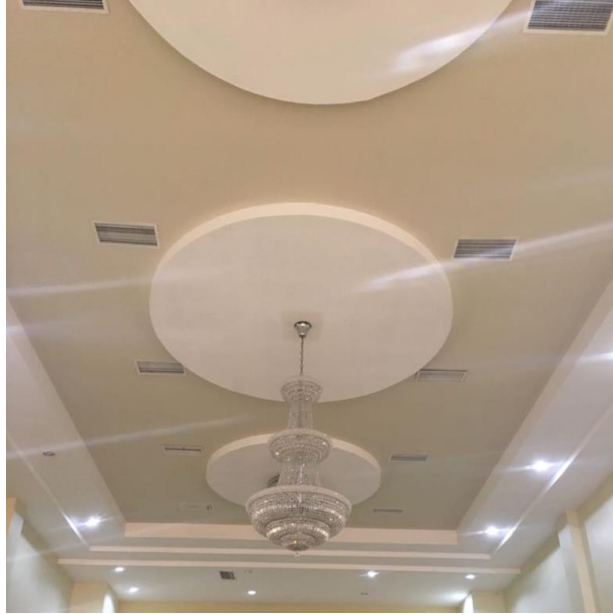
Ilustración 35. Cielo falso del salón con cuatro niveles y circunferencias de tabla yeso con un área total de 195.47m 2
