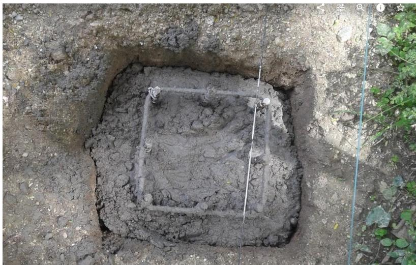
**Ilustración 52: Fundición de Dado de concreto**
