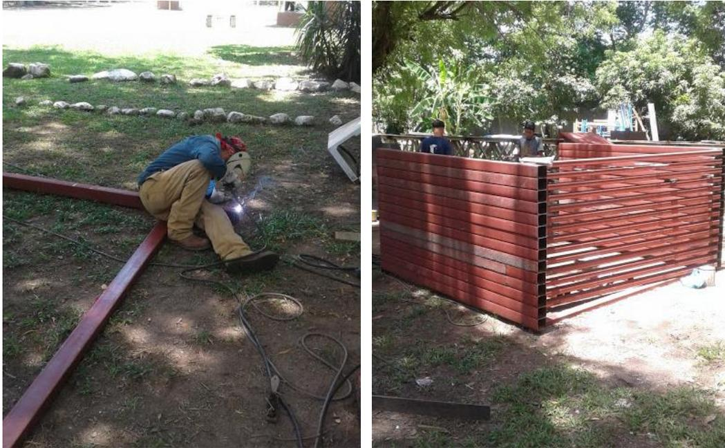
**Ilustración 51: Elaboración de Estructura Metálica**
