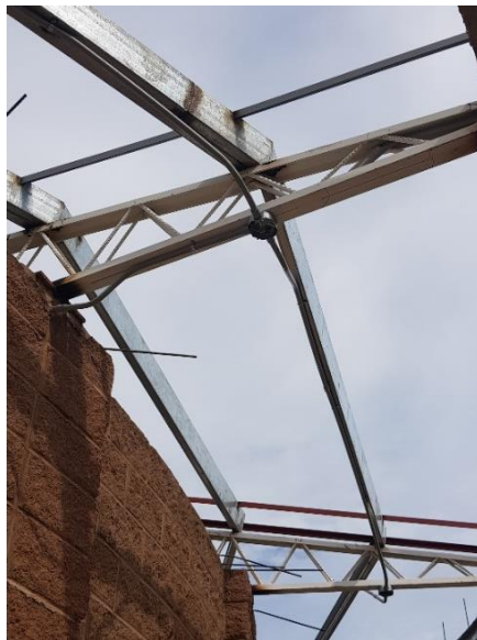
Ilustración 134: Instalación de tubería y cajas metálicas para iluminación.
