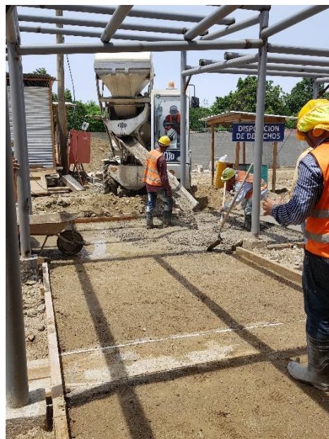
Ilustración 149: Fundición de acera en pasillo principal.
