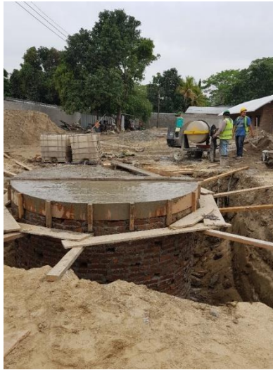
Ilustración 111: Fundición de losa del ultimo pozo de infiltración.
