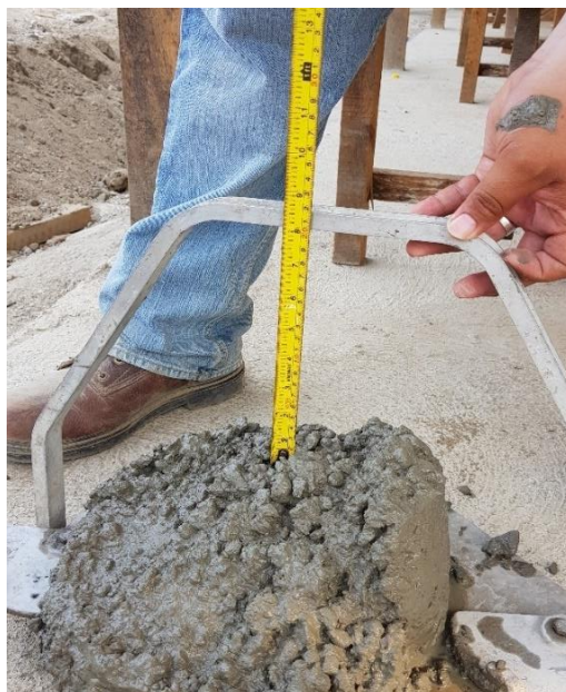
Ilustración 31: Pruebas de revenimiento del concreto.
