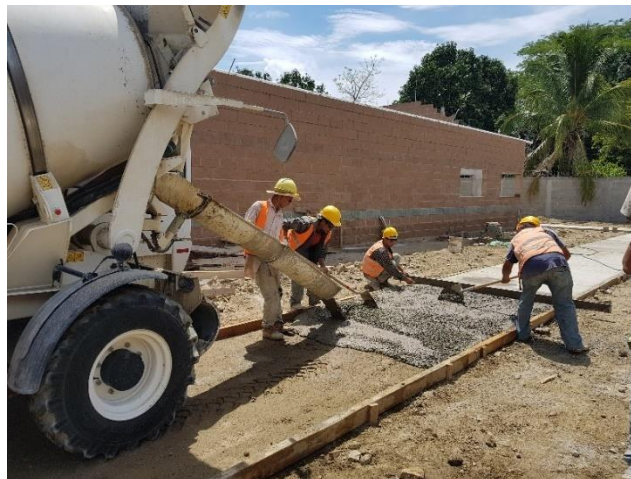
Ilustración 73: Fundición de aceras entre módulos de autonomía económica y salud sexual.
