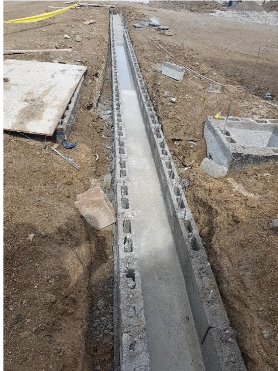
Ilustración 127: Colocación de bloque #4 en canal recolector de agua lluvias para la sobreelevación en el módulo de recepción.
