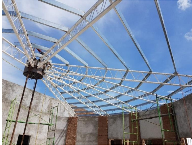
Ilustración 125: Armado de estructura de techo para el módulo de recepción.
