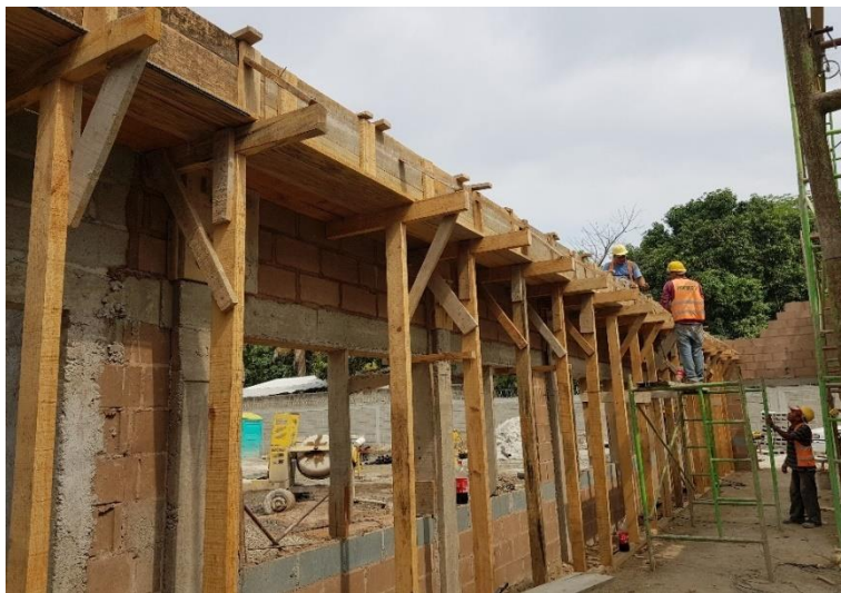
Ilustración 23: Colocación de puntales para fundición de viga canal.
