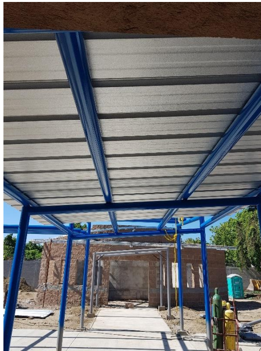
Ilustración 159: Colocación de láminas de Aluzinc calibre 24 en marcos metálicos.
