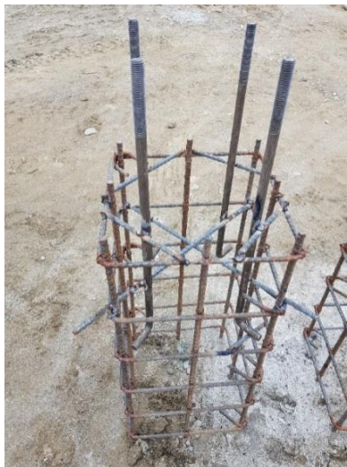
Ilustración 126: Armado de hierro y soldadura de pedestales para poste de iluminación.
