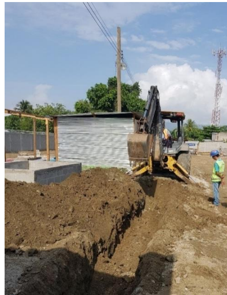
Ilustración 82:Excavación para instalación de tubería de red principal de agua para pozos de infiltración.
