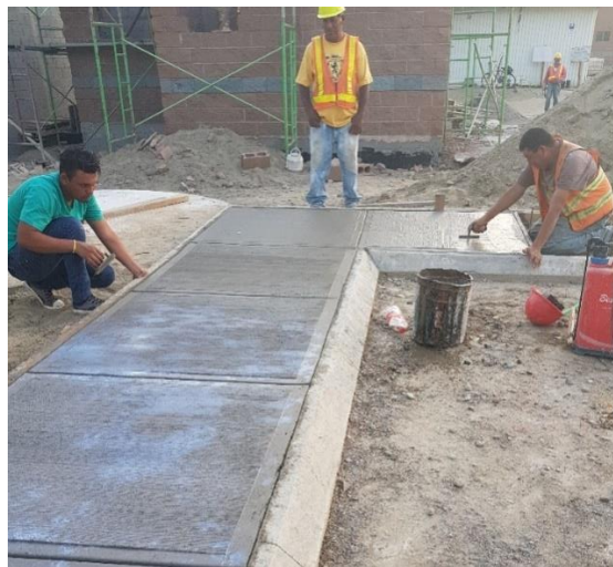
Ilustración 55:Fundición de aceras en área de caseta de vigilancia.
