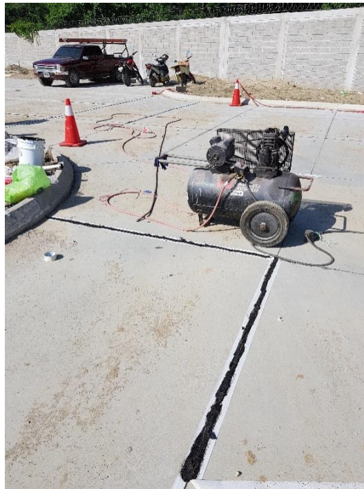
Ilustración 153: Uso de compresor de aire para limpieza de juntas.
