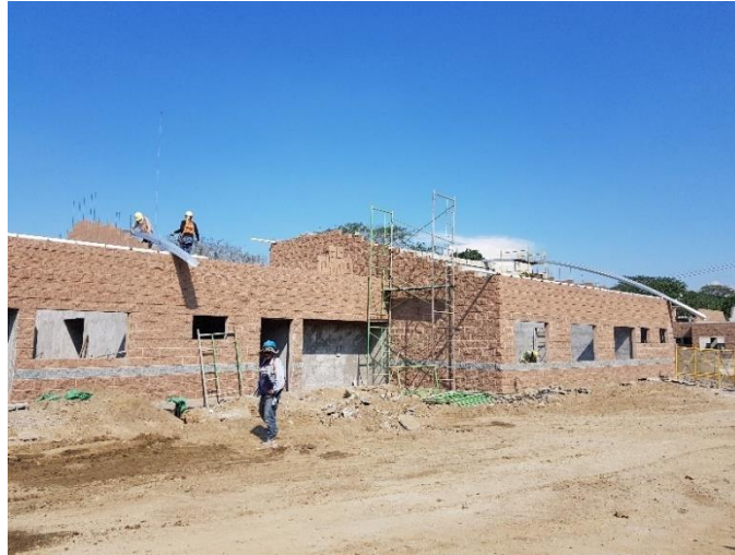
Ilustración 60: Instalación de techos curvos en módulo de salud sexual.
