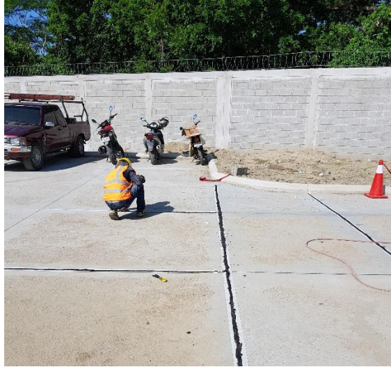
Ilustración 152: Aplicación de sellador de juntas en pavimento del área de parqueo.
