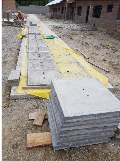
Ilustración 128: Fundición de tapaderas para casquetes de las cajas de registro.
