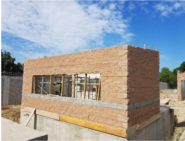
Ilustración 79: Resane de paredes internas y externas de la cisterna de agua potable y del cuarto de bombas.
