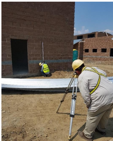
Ilustración 48:Levantamiento topográfico de puntos de referencia para aceras.
