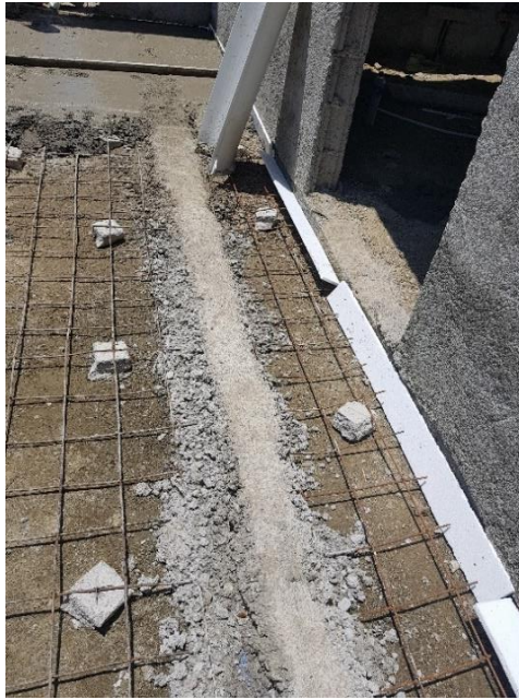
Ilustración 36: Armado de hierro y colocación de styrofoam para fundición de firme de piso.
