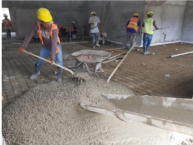
Ilustración 76:Fundición de firme de piso módulo tención a los adolescentes.
