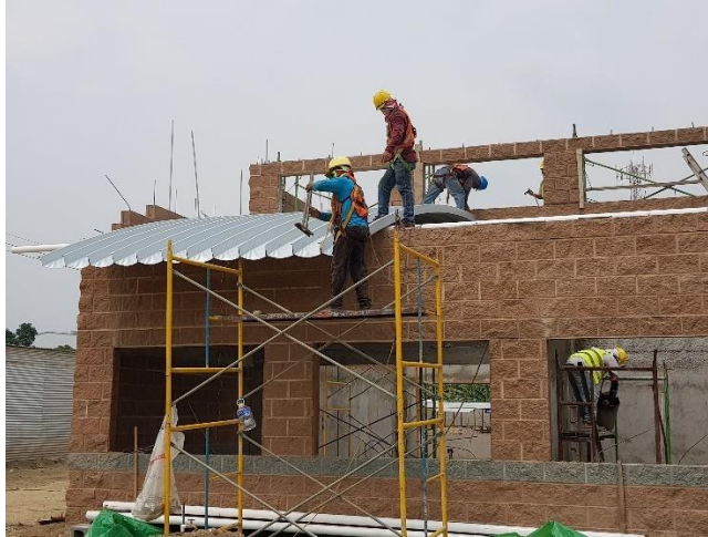
Ilustración 16: Instalación de láminas autoportantes de perfil k.
