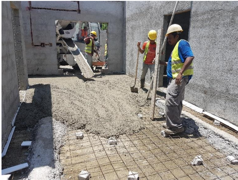
Ilustración 38: Fundición de firme de piso primer área modulo autonomía económica.
