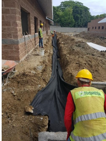
Ilustración 131: Proceso de instalación de materiales para subdrenaje de aguas lluvias.
