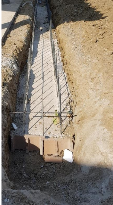
Ilustración 50: Fundición de canal recolector de aguas lluvias.
