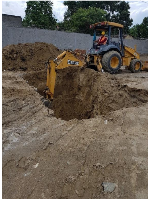
Ilustración 83: Excavación para la construcción de ultimo pozo de infiltración.
