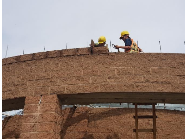
Ilustración 133: Colocación de las ultimas hiladas de bloque splitface #6 en el módulo de recepción.
