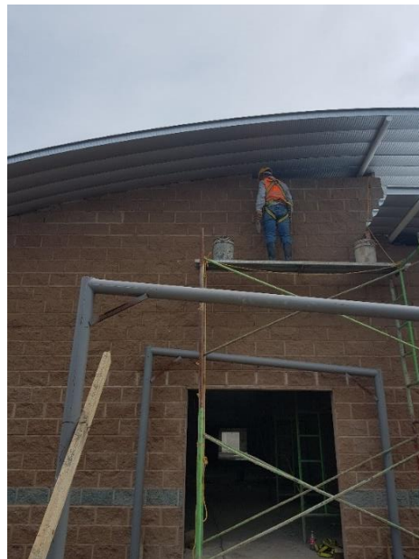
Ilustración 132: Cierre de culata del módulo de autonomía económica.
