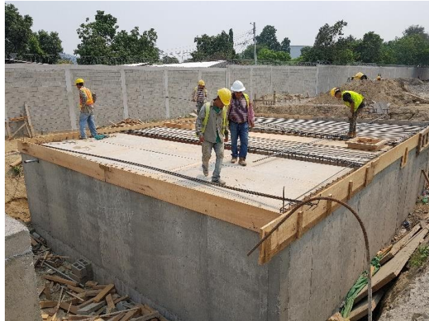
Ilustración 24: Encofrado y armado de hierro para losa de cisterna agua potable.
