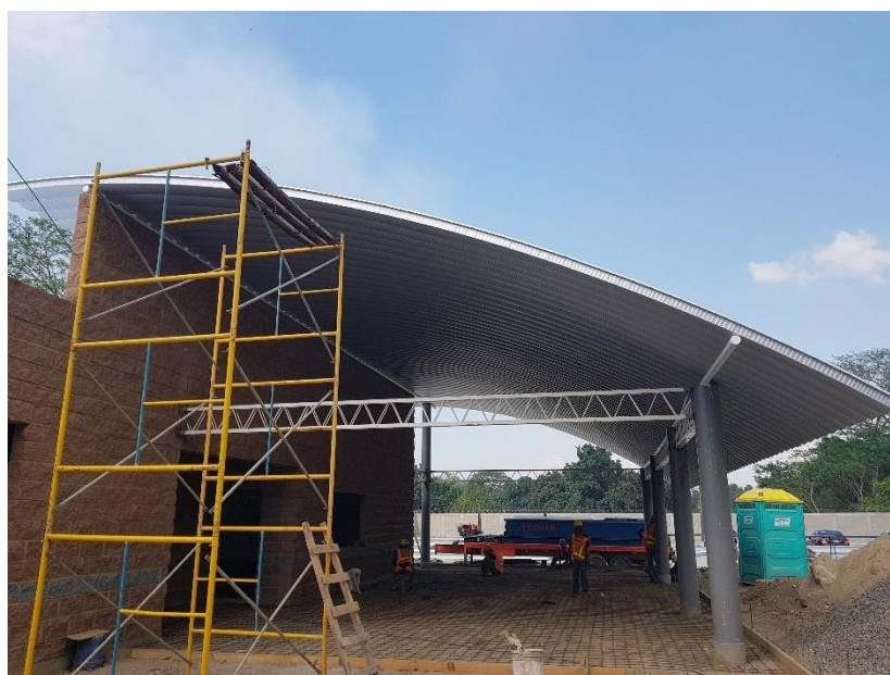
Ilustración 40: Colocación del techo en el módulo de cafetería.
