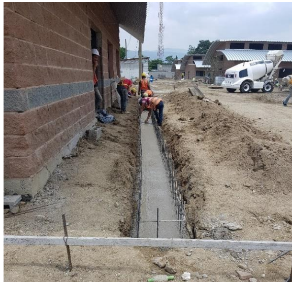
Ilustración 91: Fundición de canal recolector de aguas lluvias en módulo de atención a los adolescentes.
