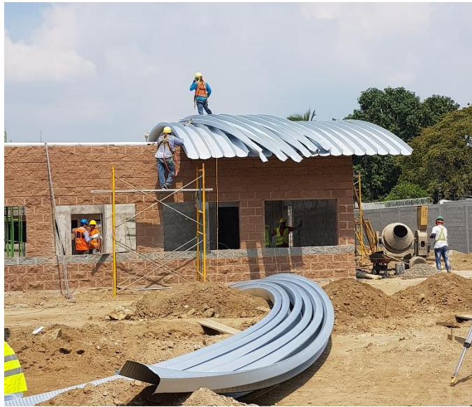
Ilustración 64: Instalación de techo curvos en parte posterior módulo de salud sexual.
