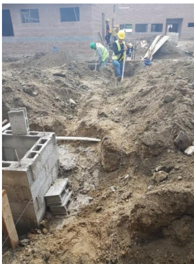
Ilustración 110: Excavación de canal recolector de aguas lluvias entre los módulos de salud sexual y cuidado infantil.
