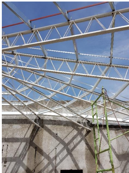
Ilustración 137: Acabado Final de aplicación de pintura anticorrosiva en estructura de techo.
