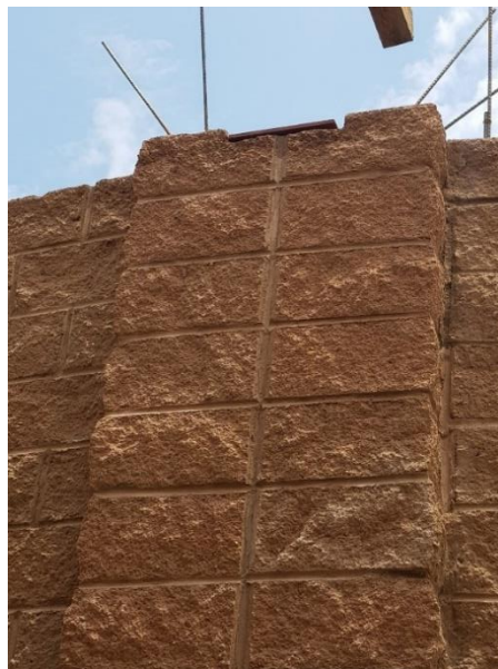
Ilustración 96: Colocación y anclaje de placas metálicas en columnas del módulo de recepción. Fuente: Sandoval, E. (2018)
