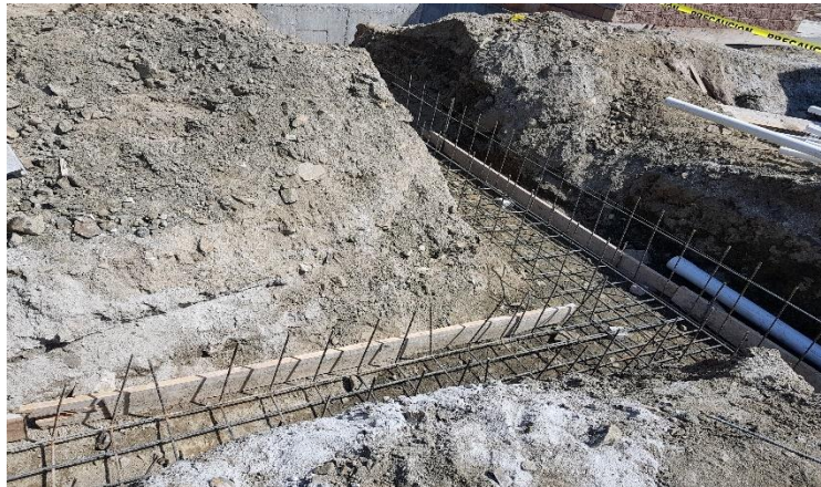
Ilustración 138: Continuación de armado de hierro para fundición de canal de aguas lluvias.
