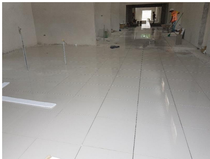
Ilustración 116: Pegado de porcelanato esmaltado de 50 x 50 en el módulo de atención a la violencia.
