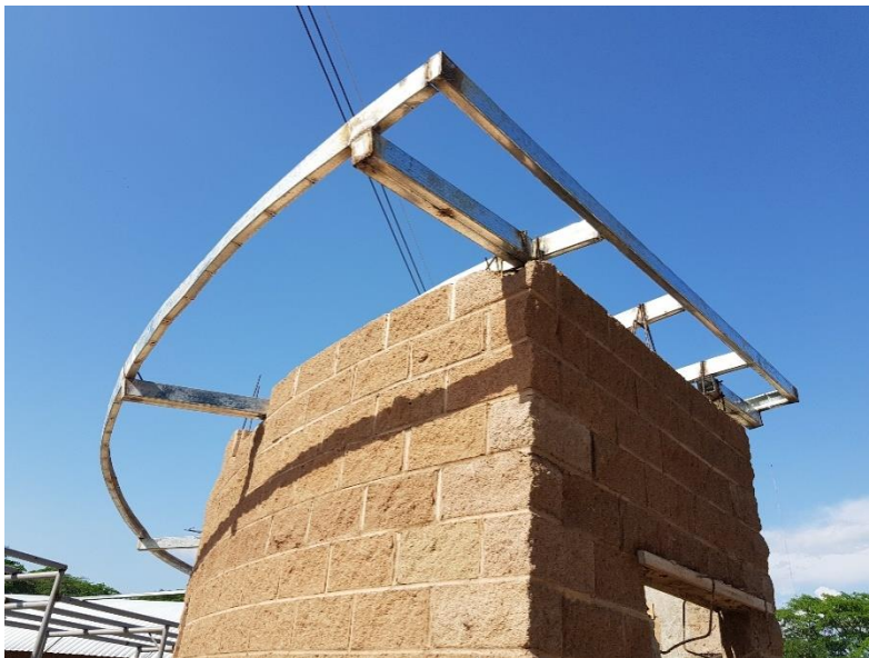
Ilustración 143: Anclaje de armadura de techo con varillas #3 soldadas.
