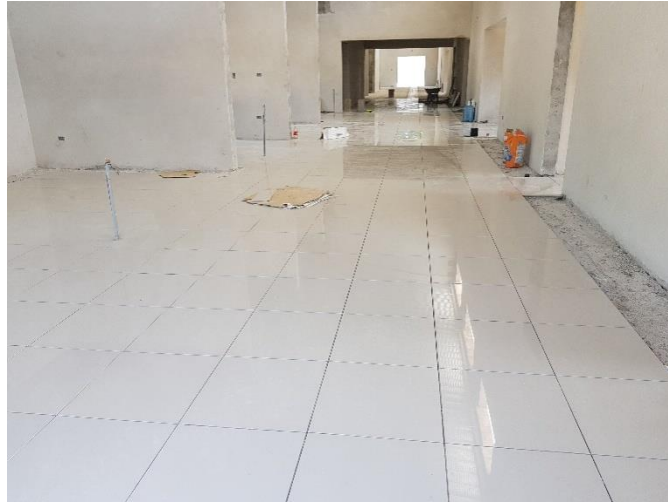
Ilustración 144: Pegado de porcelanato 50x50 esmaltado.
