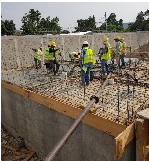
Ilustración 28: Fundición de losa de cisterna agua potable.
