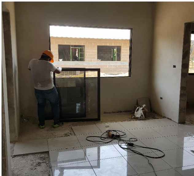
Ilustración 146: Instalación de perfil de aluminio y ventanas corredizas.
