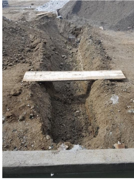
Ilustración 103: Excavación para continuación de canal recolector de aguas lluvias.
