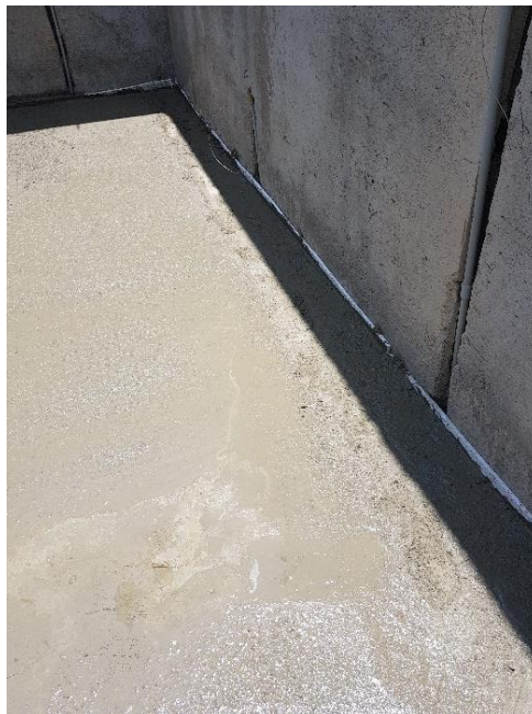
Ilustración 37: Fundición de firme de piso área de atención a la violencia con acabado tipo codaleado fino.
