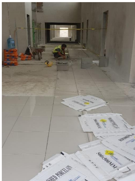
Ilustración 117: Pegado de porcelanato esmaltado de 50 x 50 en el módulo de salud sexual.
