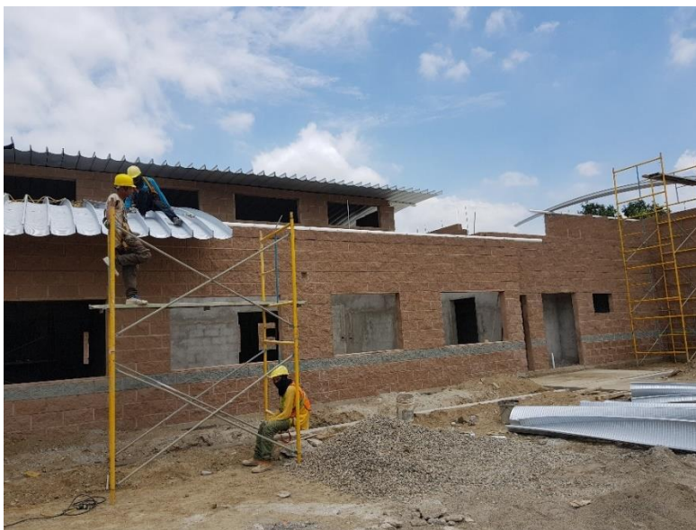
Ilustración 109: Se realizó colocación del techo curvo en la parte media del módulo de autonomía económica.
