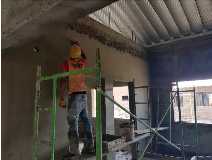
Ilustración 99: Pulido de paredes en módulo de autonomía económica.
