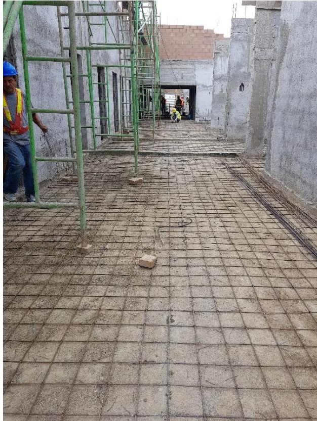
Ilustración 35: Armado de hierro para firme de piso.
