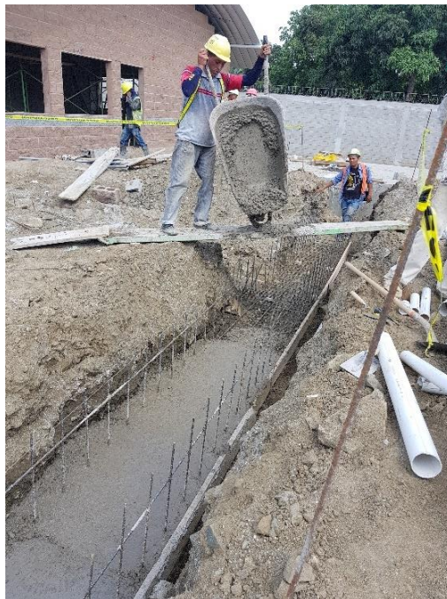
Ilustración 139: Fundición de continuación de canal recolector de aguas lluvias.
