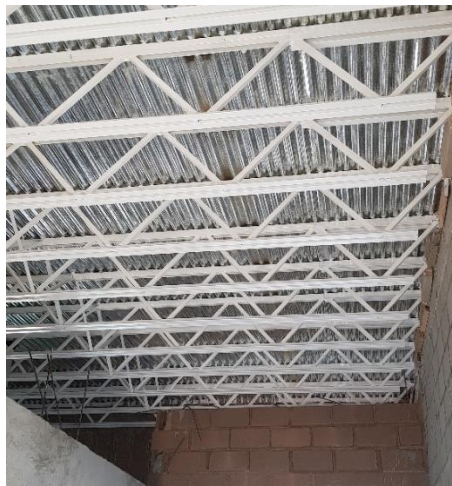
Ilustración 21: Anclaje y soldadura de placas metálicas y colocación de vigas joist.
