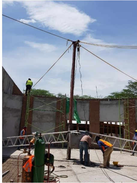
Ilustración 97:Colocación de anillo de compresión con vigas joist.
