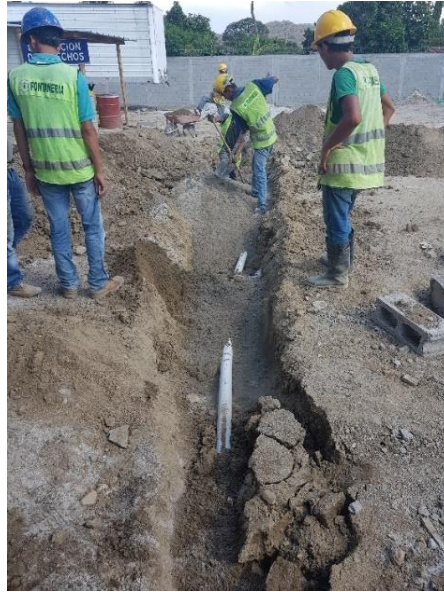
Ilustración 81:Excavación e instalación de la tubería de red principal de agua potable para el módulo de autonomía económica.
