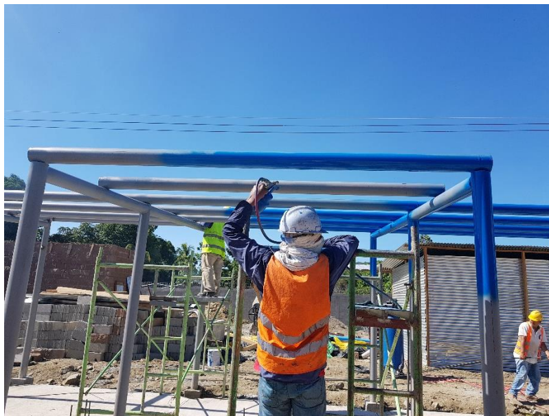
Ilustración 157: Aplicación de pintura color azul en marcos metálicos en pasillo principal.
