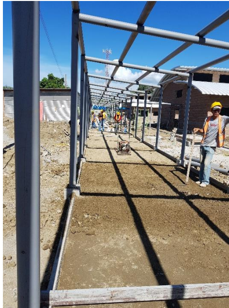
Ilustración 160: Continuación de colocación de marcos metálicos de pasillo principal.
