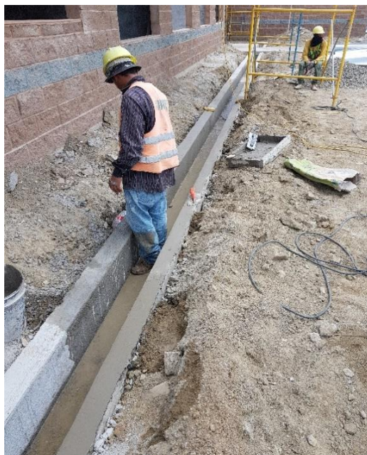
Ilustración 118: Pulido del canal recolector de aguas lluvias en el módulo de autonomía económica.
