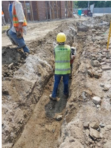
Ilustración 46: Compactado de zanjeado de instalación tubería contra incendios.
