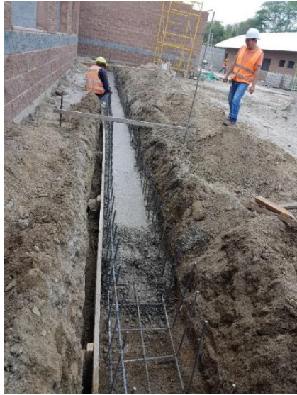
Ilustración 95: Armado de hierro y fundición de canal recolector de aguas lluvias en módulo de autonomía económica.
