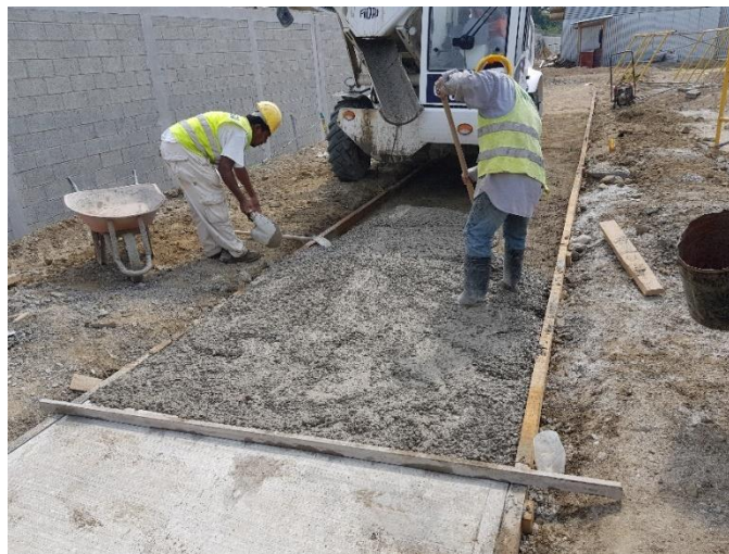
Ilustración 65: Fundición de aceras en parte posterior del módulo de atención a la violencia.
