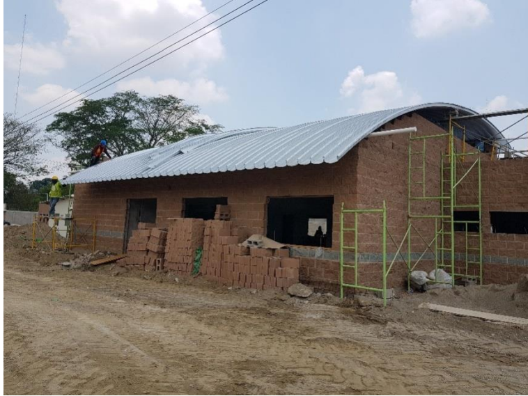
Ilustración 74: Instalación de techos curvos en el módulo de atención a los adolescentes.
