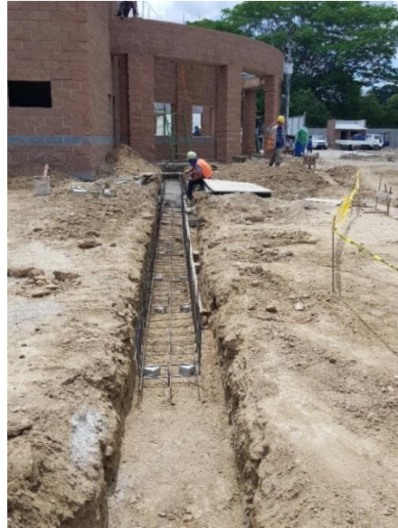
Ilustración 105: Excavación, armado de hierro con varillas #3 y fundición de canal recolector de aguas lluvias en módulo de recepción.
