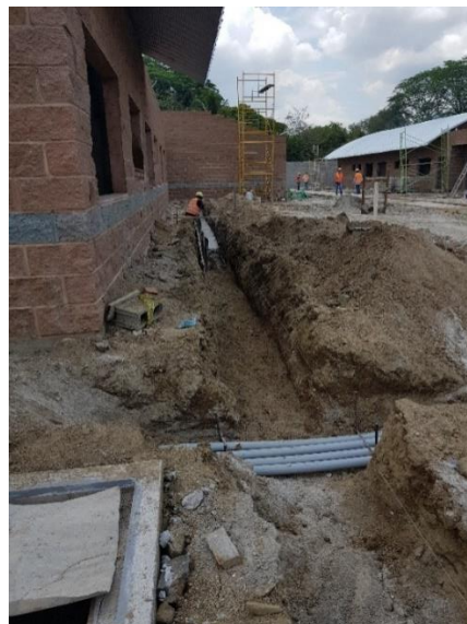
Ilustración 94: Excavación de canal recolector de aguas lluvias en módulo de autonomía económica.
