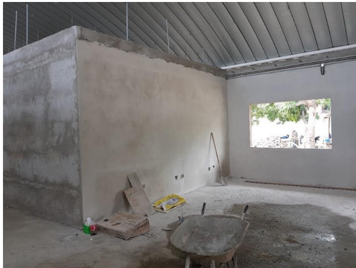
Ilustración 100: Pulido de paredes en módulo de atención a la violencia.
