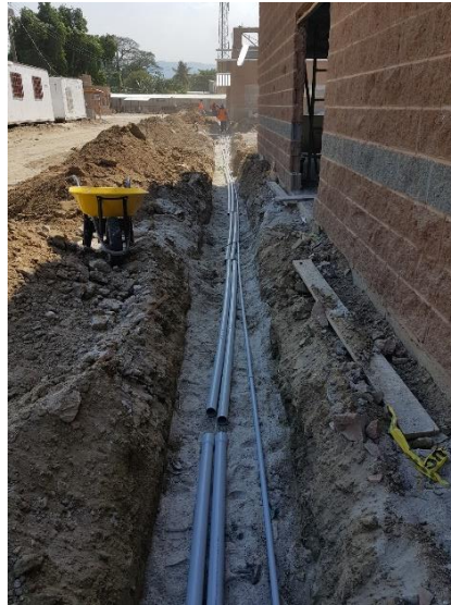
Ilustración 56: Instalación de tubería para cajas de datos en módulo de salud sexual.
