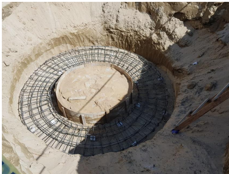
Ilustración 84: Armado y colocación de hierro para ultimo pozo de infiltración.
