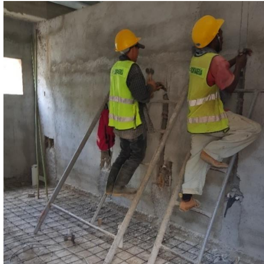
Ilustración 54:Ranurado para tubería de ventilación en baños de módulo de cafetería.
