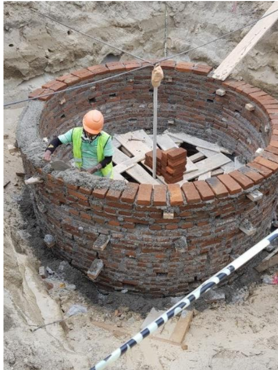
Ilustración 92: Construcción de último pozo de infiltración.
