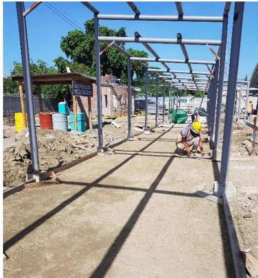
Ilustración 148: Preparación de acera para pasillo principal.
