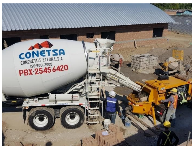
Ilustración 32: Uso de máquina Concretera para fundición de losa.
