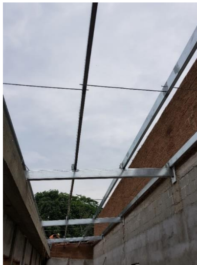
Ilustración 88: Instalación de canaletas para el Techo a un agua en el módulo de autonomía económica.
