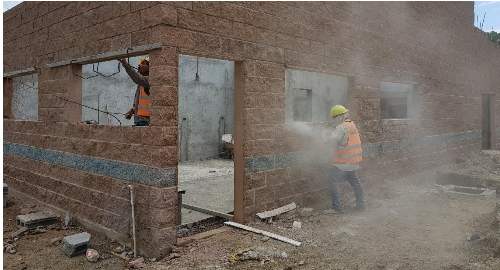
Ilustración 66: Tallado de ventanas en modulo autonomía económica.
