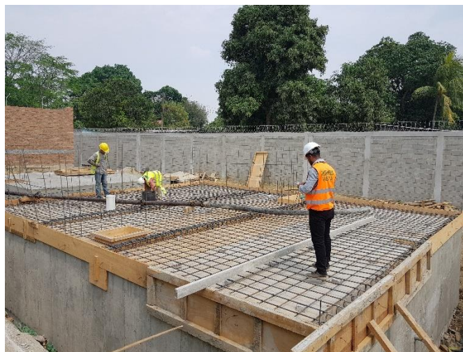
Ilustración 25: Armado de Hierro para losa de cisterna agua potable.
