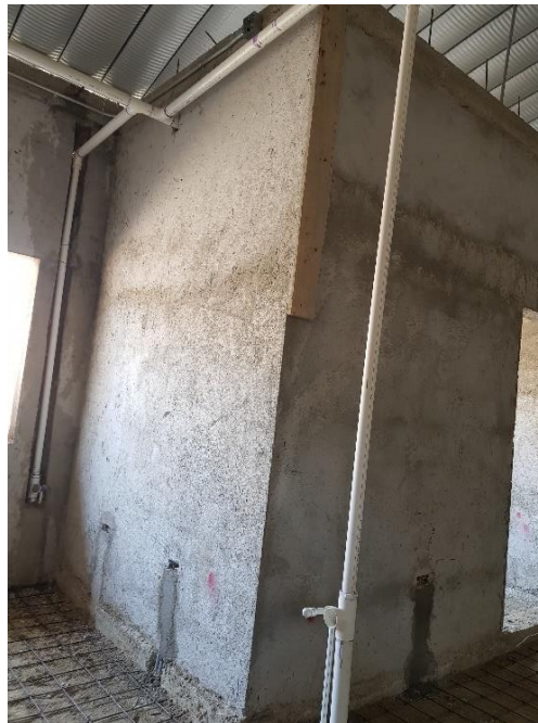
Ilustración 44: Instalación de tubería de ventilación en módulo de autonomía económica.
