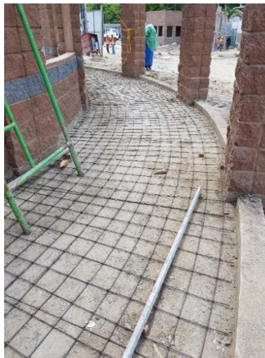
Ilustración 106: Armado de hierro en módulo de recepción.
