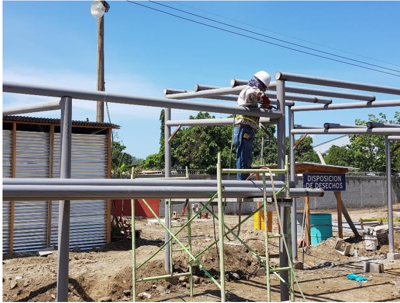
Ilustración 156: Resane de soldaduras en marcos metálicos en pasillo principal.
