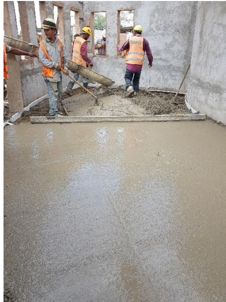
Ilustración 70: Fundición de firme de piso en el módulo de sala de meditación.
