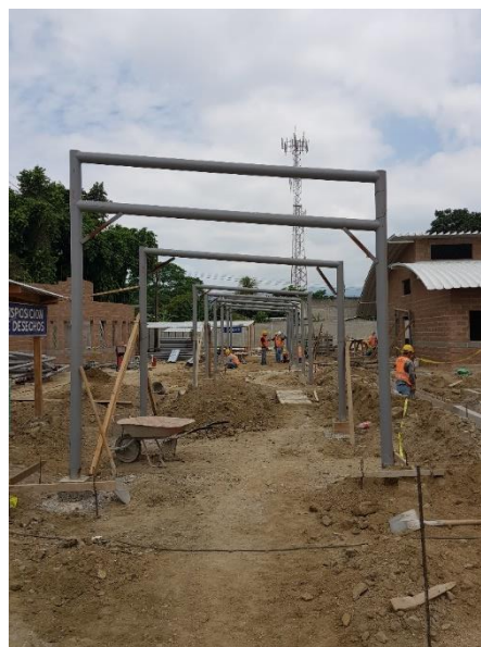
Ilustración 120: Colocación de los marcos metálicos para el techo del pasillo.
