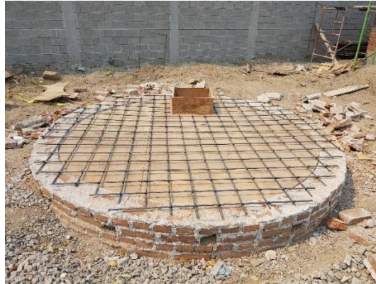
Ilustración 18:Encofrado y armado de hierro de pozos de infiltración.
