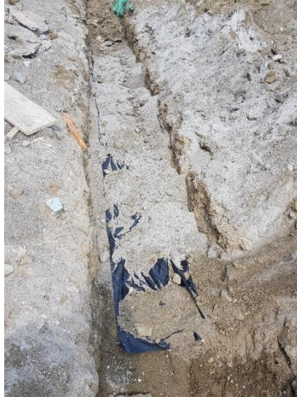
Ilustración 45: Zanjeado para instalación de tubería contra incendios.
