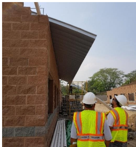
Ilustración 15: Instalación y aprobación de láminas autoportantes de perfil K.
