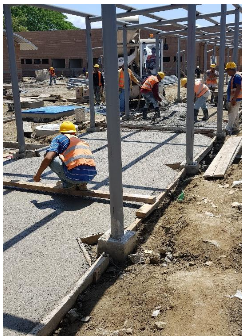
Ilustración 161: Fundición de aceras de la continuación de pasillo principal.
