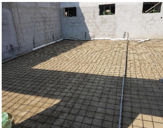
Ilustración 42: Armado de hierro para firme de piso módulo de autonomía económica.
