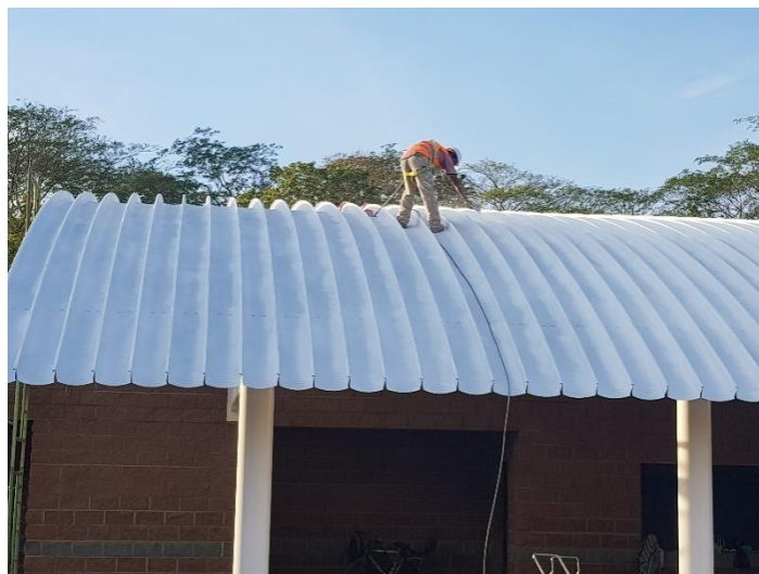
Ilustración 77:Aplicación de pintura impermeabilizante y térmica en módulo de cafetería.
