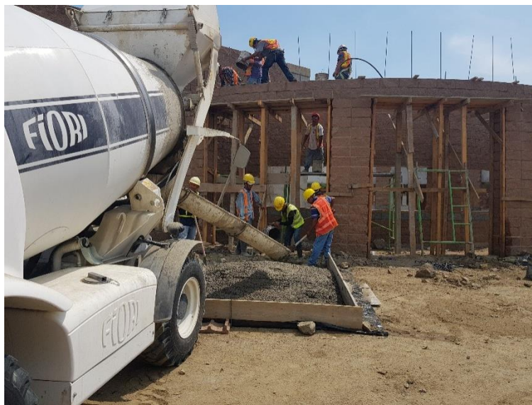
Ilustración 69: Fundición de viga canal modulo recepción.
