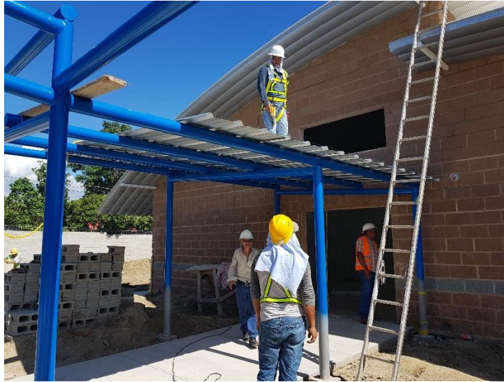
Ilustración 158: Instalación de láminas de Aluzinc en pasillo principal.
