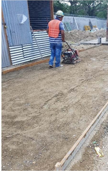
Ilustración 49:Uso de compactadora de plato para el nivel del suelo.
