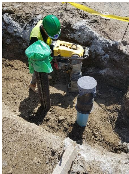
Ilustración 141: Compactación de suelo con maquina bailarina para Hidrantes contra incendios.
