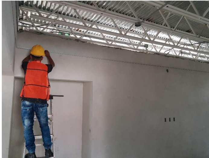
Ilustración 150: Colocación de ángulos de carga para cielo falso.
