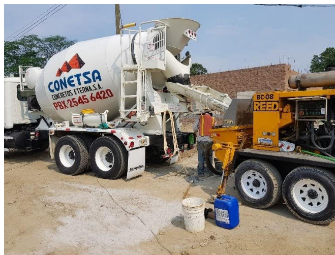
Ilustración 27: Uso de máquina concretera y de succión para fundición de losa de cisterna agua potable.
