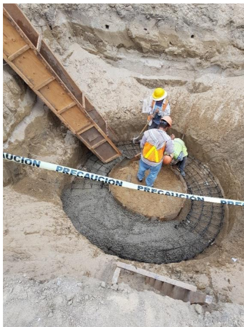
Ilustración 85: Fundición de firme para ultimo pozo de infiltración.
