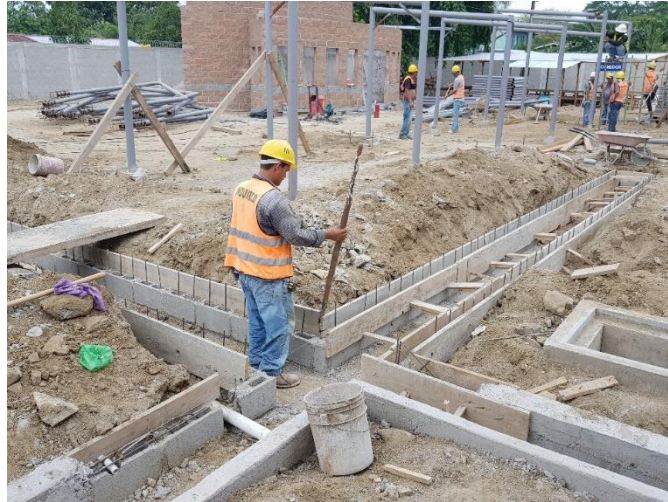
Ilustración 123: Continuación del canal recolector de aguas lluvias entre los módulos de atención a la violencia y autonomía económica.
