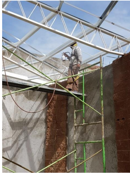
Ilustración 136: Aplicación de pintura anticorrosiva color blanco en la estructura de techo módulo de recepción.
