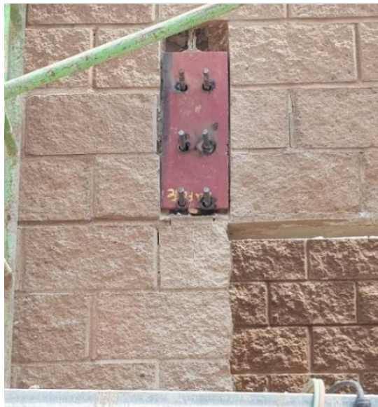
Ilustración 19: Anclaje de placa metálica y soldadas.
