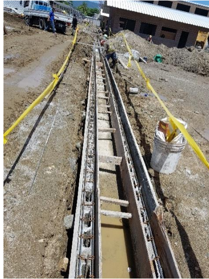
Ilustración 140: Armado y encofrado para fundición de jamba superior de canal.
