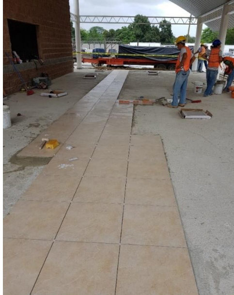
Ilustración 115: Pegado de porcelanato antiderrapante de 50 x 50 en el módulo de cafetería en el área de comedor.
