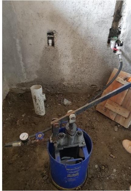
Ilustración 62: Pruebas Hidrostáticas con bomba a presión en módulo de autonomía económica.
