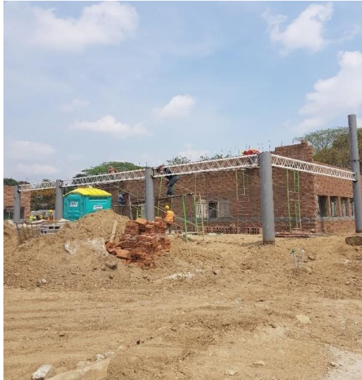
Ilustración 20: Anclaje y soldadura de placa metálicas y vigas joist.
