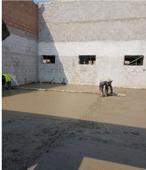
Ilustración 43: Fundición de firme de piso para del módulo de autonomía económica.
