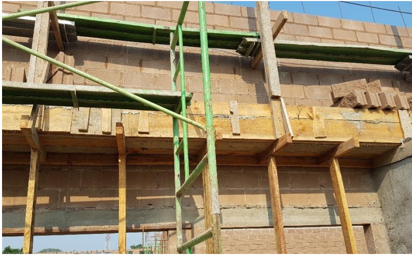
Ilustración 22: Encofrado y armado para fundición de viga canal.
