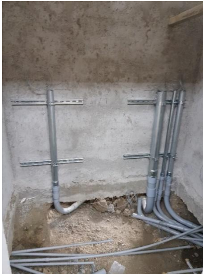
Ilustración 87: Instalación de tubería principal para la red eléctrica en el cuarto de tableros en el módulo de salud sexual.
