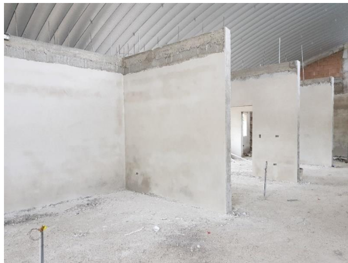
Ilustración 98:Pulido de paredes en módulo de salud sexual.
