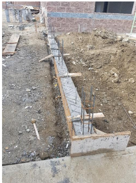
Ilustración 129: Encofrado y fundición de sobreelevación para muro.
