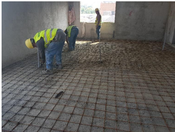
Ilustración 58: Armado de hierro para fundir firme de piso en módulo de autonomía económica. Fuente: Sandoval, E. (2018).
