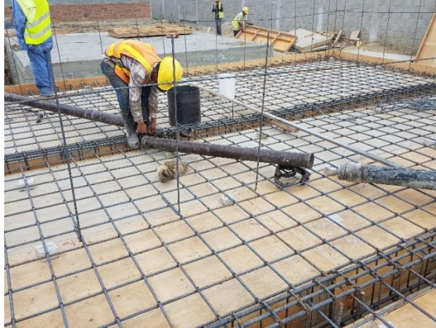
Ilustración 26: Instalación de tubos de succión para concreto.
