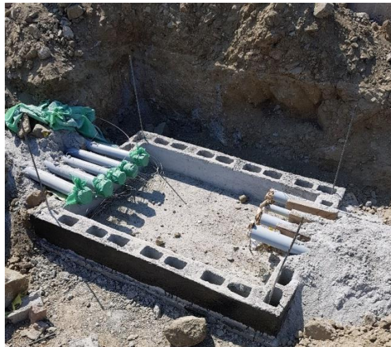
Ilustración 57: Caja de datos y eléctrica.
