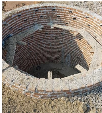
Ilustración 17: Construcción de pozos de infiltración.
