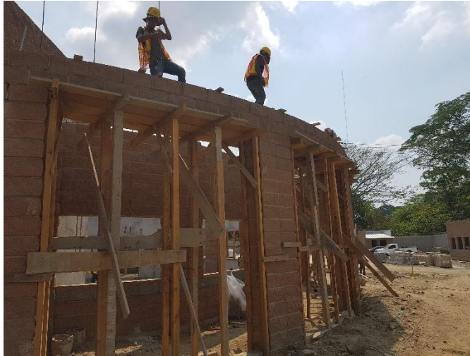
Ilustración 68: Armado y encofrado de viga canal módulo recepción.
