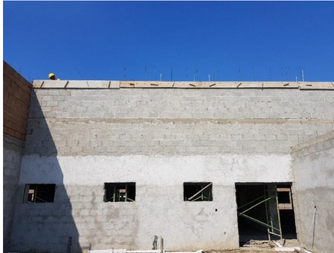
Ilustración 41: Fundición de solera superior módulo de autonomía económica.
