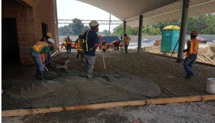
Ilustración 47:fundición de firme de piso para módulo de cafetería.
