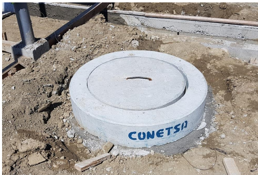
Ilustración 155: Colocación de Tapaderas de concreto para pozos de infiltración.
