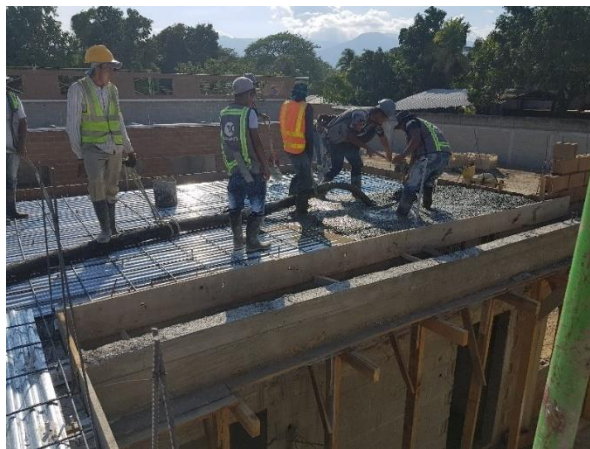
Ilustración 34: Fundición de losa con tubos de succión de concreto.
