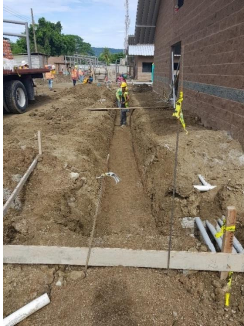
Ilustración 113: Excavación para continuación de canal recolector de aguas lluvias en módulo de salud sexual.
