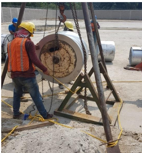
Ilustración 12: Instalación de bobinas de lámina galvanizadas para hacer el perfil.
