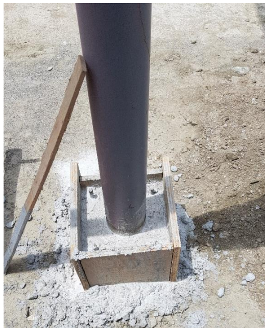
Ilustración 122: Encofrado y fundición del pedestal para los marcos metálicos.
