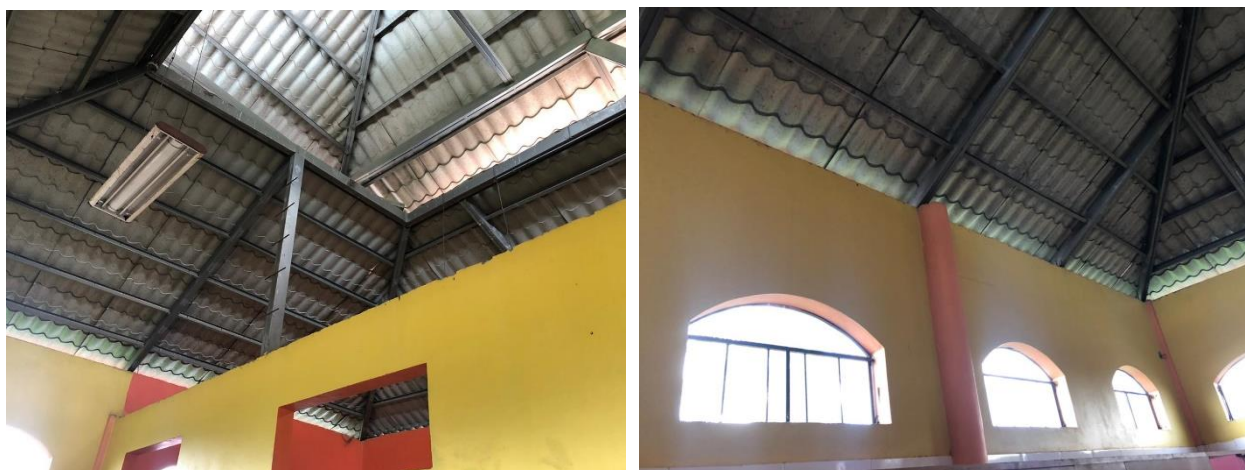
Ilustración 59 Cubierta área de Servicios Sanitarios existentes
