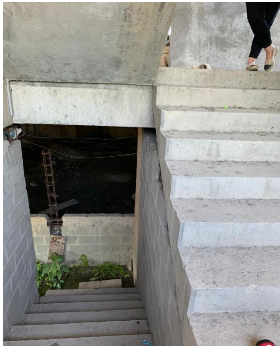
Ilustración 79. Tramo Sótano-Lobby escalera principal
