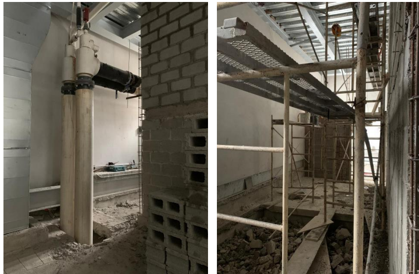
Ilustración 73. Trabajos realizados en construcción
