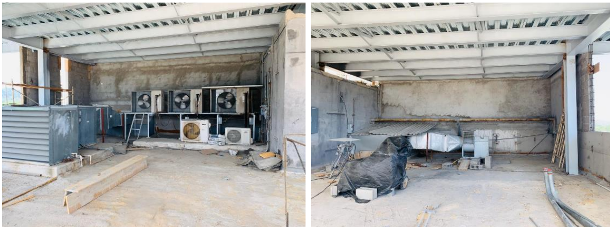
Ilustración 22. Levantamiento de espacios de ampliación Torre 2
