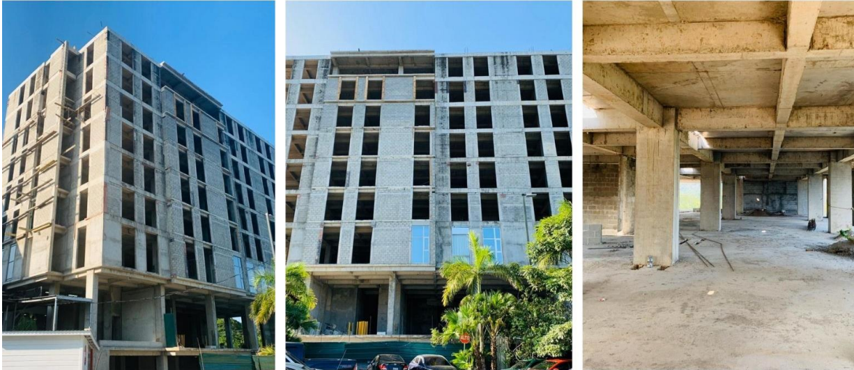
Anexos 2. Registro avance de obra Hotel Courtyard
