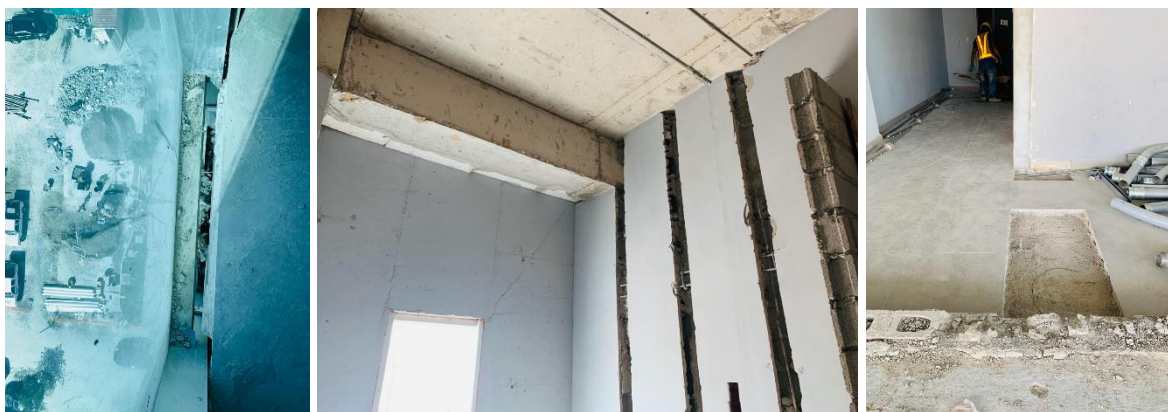
Ilustración 23. Levantamiento fotográfico de espacios de ampliación Torre 3
