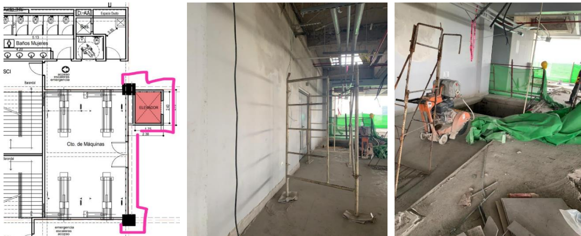
Ilustración 69. Paredes de levantamiento para nuevo enchape
