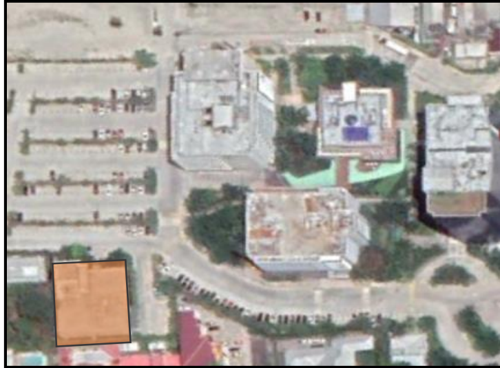
Ilustración 3. Vista aérea de Torre GK
