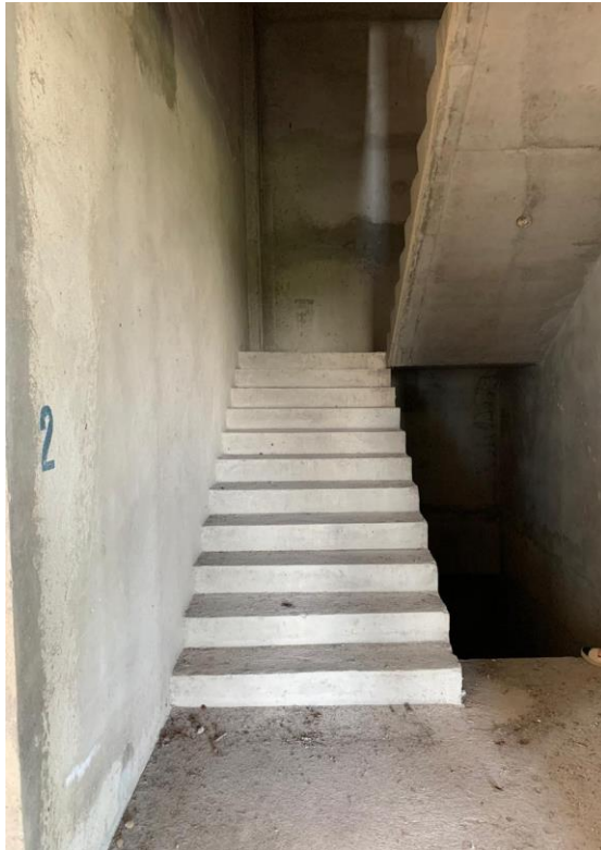
Ilustración 81. Tramo N2-N3 escalera de servicio
