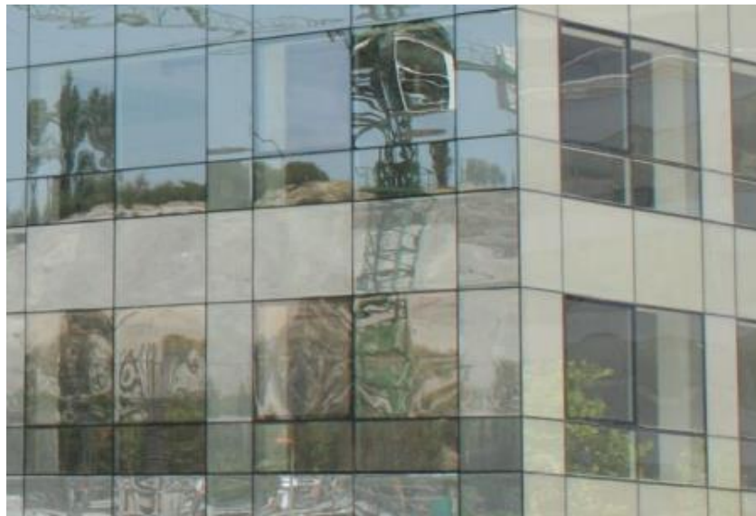
Ilustración 16. Aplicación de vidrio reflectivo en edificio.
