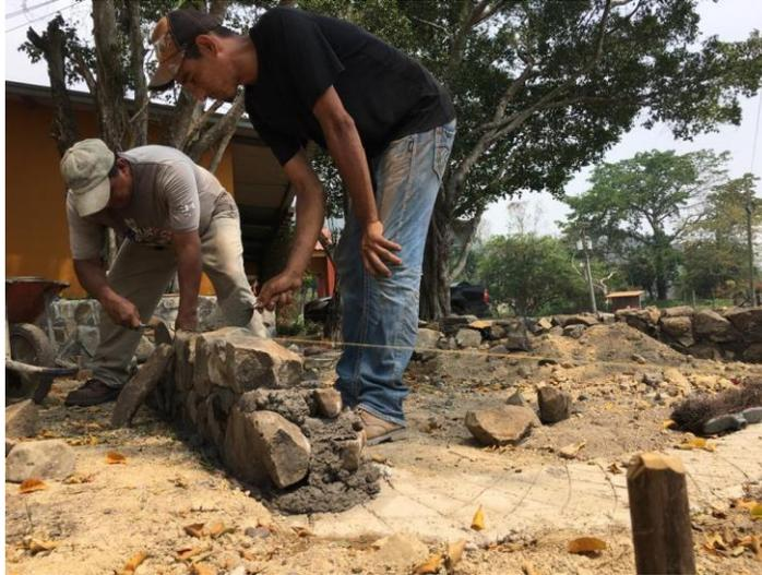
**Ilustración 68: Maestros de obra en construcción de arriates para huerta**
