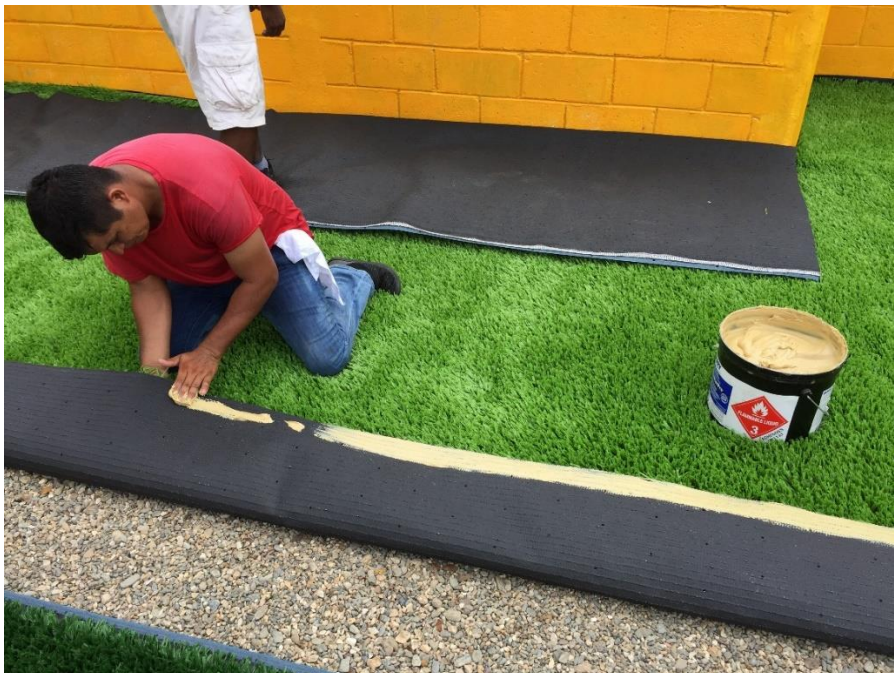
Ilustración 37. Supervisión de instalación de grama sintetica en cancha, Aldea Urraco
