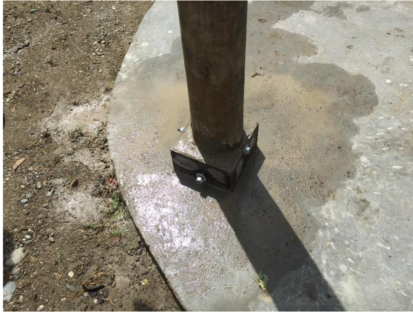
Ilustración 50. Estructura de dado para postes en el Kiosco, Supervisión Parque infantil en Corocol.
