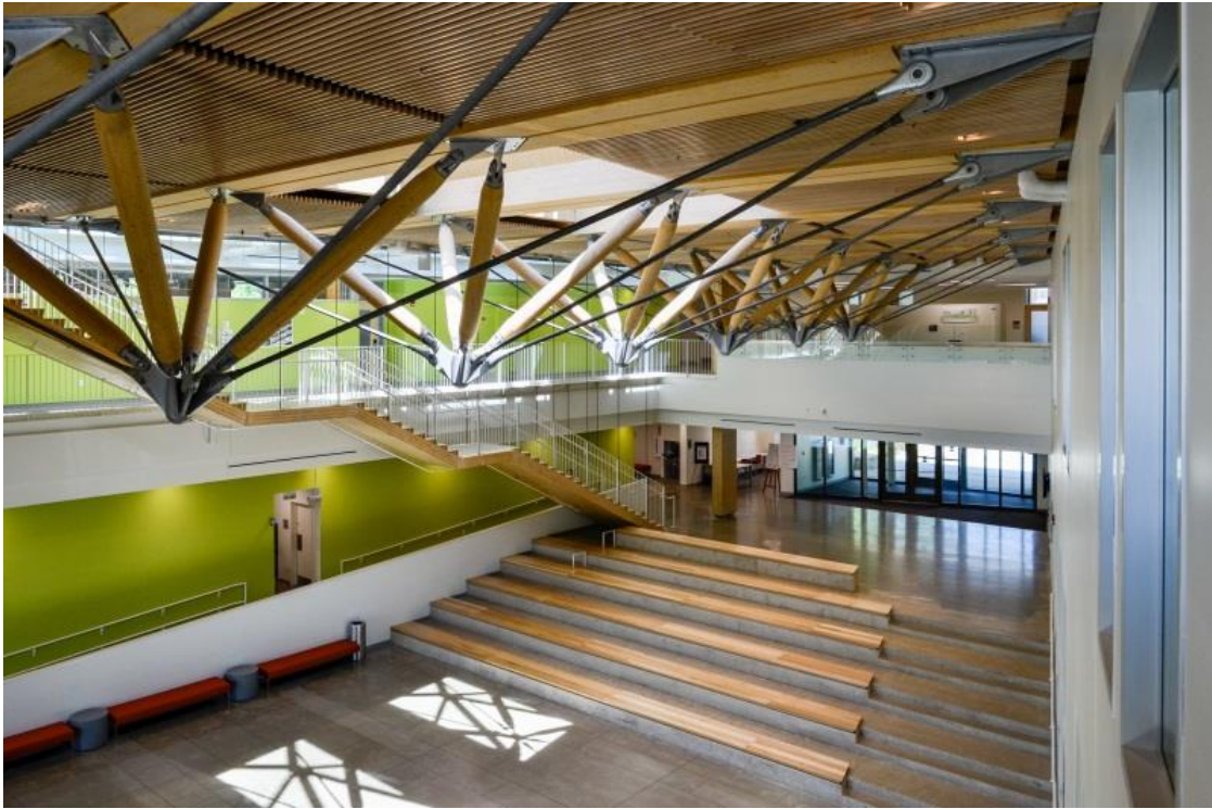
Ilustración 11. Tijeral De Madera Laminada, Universidad de Massachusetts en Amherst.
