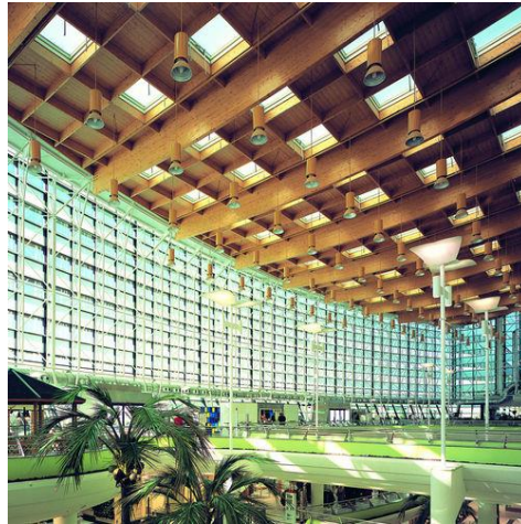
Ilustración 9. Tijeral De Madera Laminado Encolado, Centro Comercial Sanchinarro
