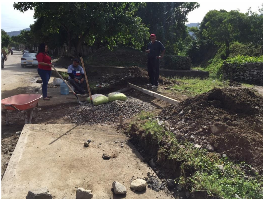
Ilustración 47. Supervisión nivelación de terreno para rampa, Parque infantil en Corocol
