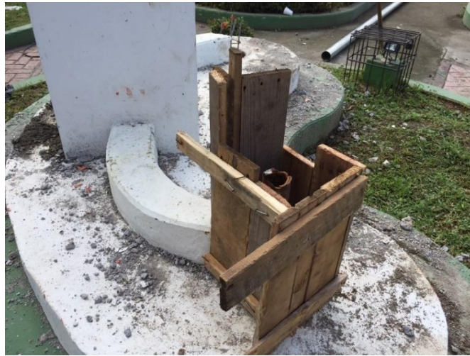
Ilustración 52. Encofrado para dado de astas, Supervisión Plaza Perú
