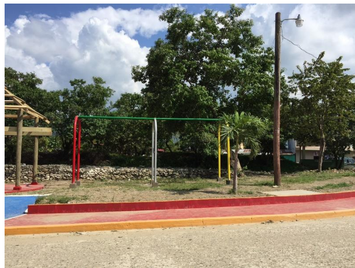
Ilustración 55. Instalación de estructura de techo y columpios, Parque Corocol
