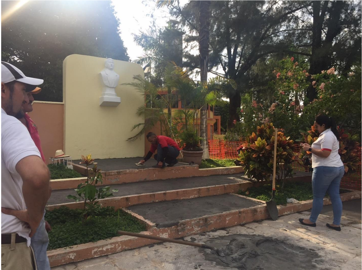
Ilustración 65. Supervisión de nivelamiento de piso, Parque Ramon Rosa
