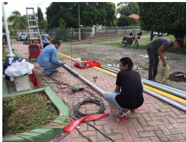
Ilustración 53. Soldadura de astas, Supervisión Plaza Perú
