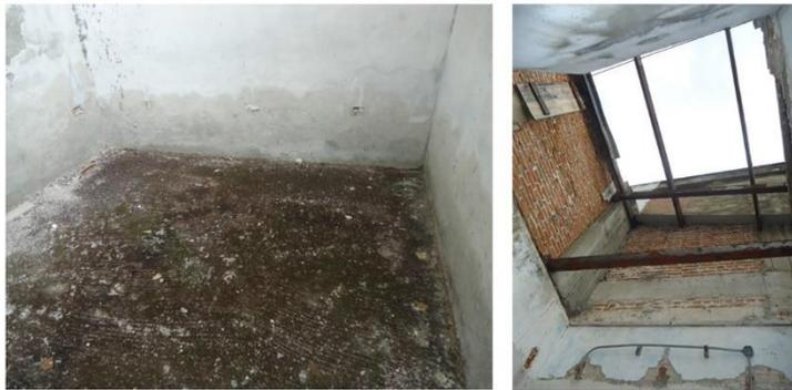
El suelo cuenta con una capa de moho, y la presencia de algunos residuos de materiales de construcción. Carece de una cubierta, y las paredes tienen marcas de humedad. En la parte superior de las paredes se encuentran elementos de madera que han sido clavados en su lugar, y materiales de pared como como ladrillo se encuentran expuestos en la zona superior de las paredes.
