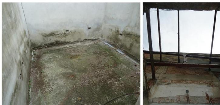
Carece de cubierta y por ello la prolongada precipitación ha creado las condiciones adecuadas para el desarrollo de agentes orgánicos en los suelos y paredes. Existen marcas de humedad en las paredes y suelo. La estructura de techo se encuentra presente, pero corroída.
