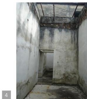
La falta de cubierta ha provocado que la humedad resida en las paredes y suelo, deteriorando ambas cosas. En el suelo han crecido plantas en grietas donde alguna vez hubo baldosas.
