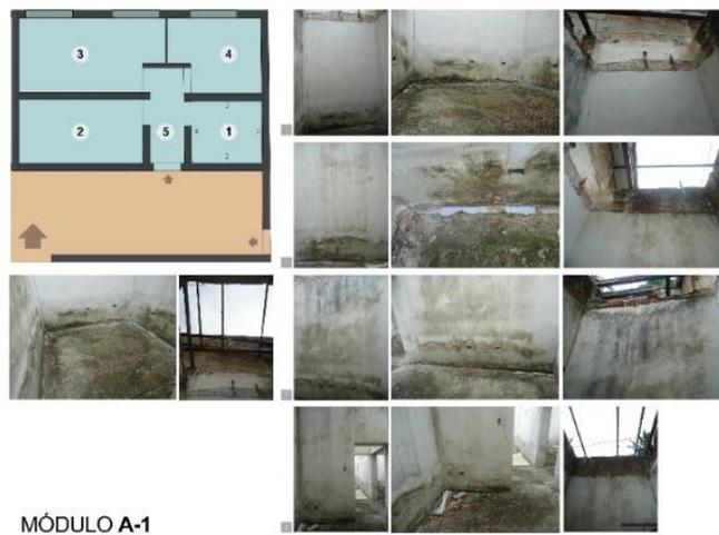
**Ilustración 19: Levantamiento de deterioro Módulo A-1**
