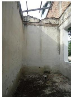
El suelo cuenta con una capa de moho, existen pequeñas aberturas en las paredes donde anteriormente hubieron componentes de las instalaciones electricas. Las hiladas superiores de las paredes se han deteriorado hasta el punto de dejar una silueta irregular. El material de reppello de las ventanas se ha desprendido en areas.
