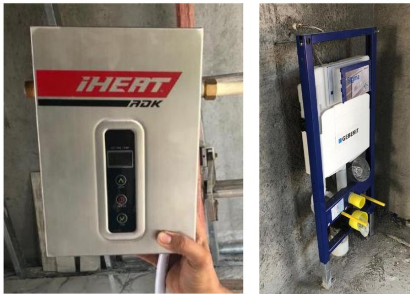
**Ilustración 57 Calentador de paso y tanque de inodoro**
