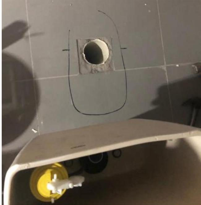
**Ilustración 69 Ensayo de ubicación de inodoro**
