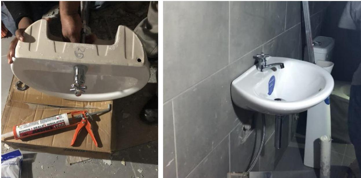
**Ilustración 68 Proceso de instalación de lavamanos**
