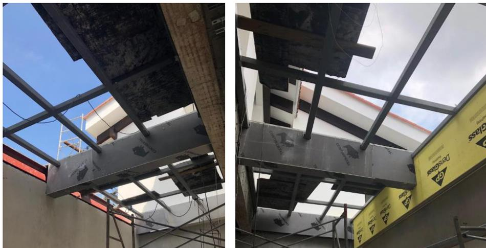
**Ilustración 107 Construcción de forros de *skylight* (Tragaluz)**
