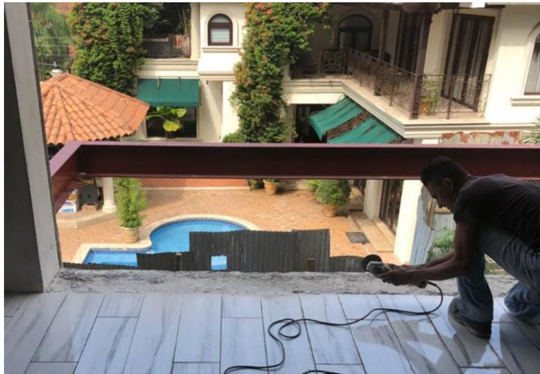
**Ilustración 91 Corte de cerámica para boquete de ventana.**
