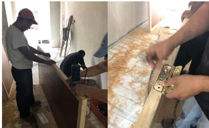
**Ilustración 89 Instalación de Puertas**
