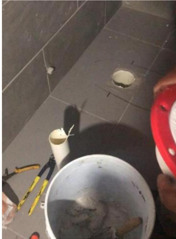
**Ilustración 71 Colocación de brida para montaje de inodoro**
