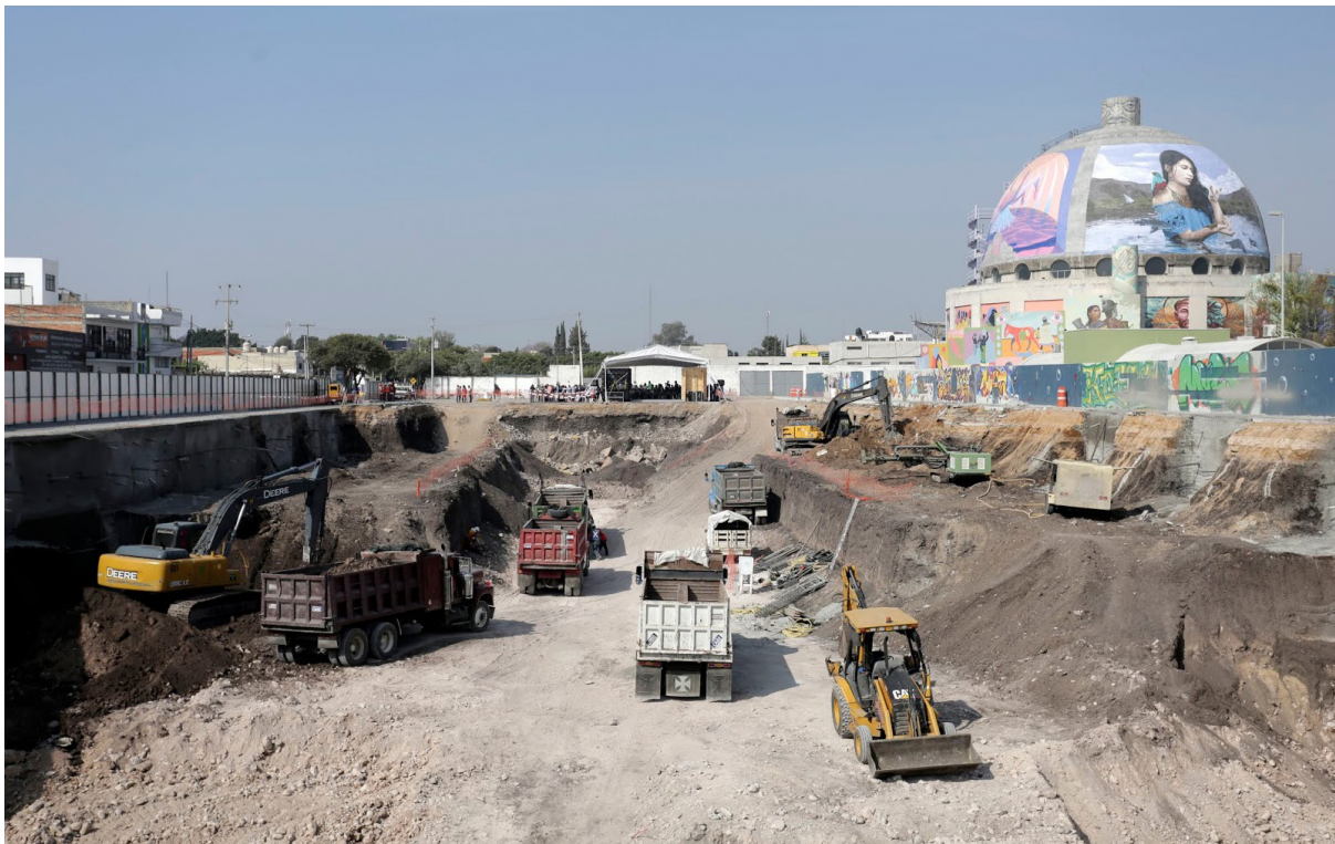
Fase de excavación para la construcción de un estacionamiento subterráneo.
