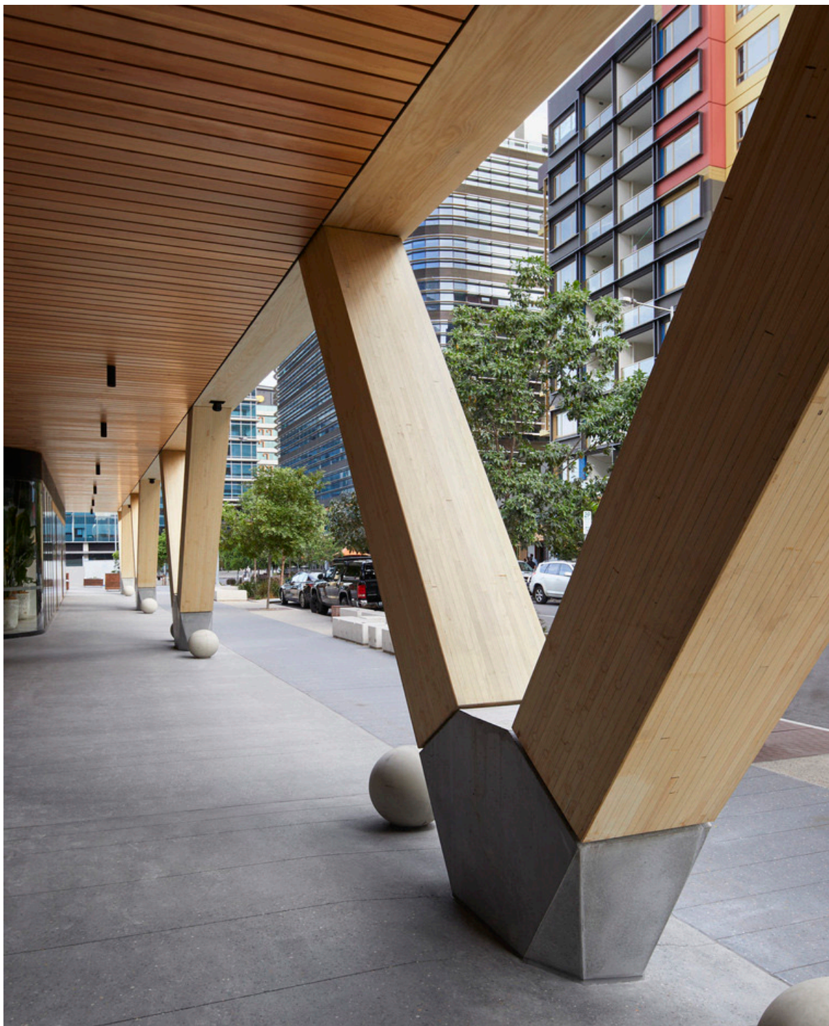
Planta baja abierta del edificio “25 King”
