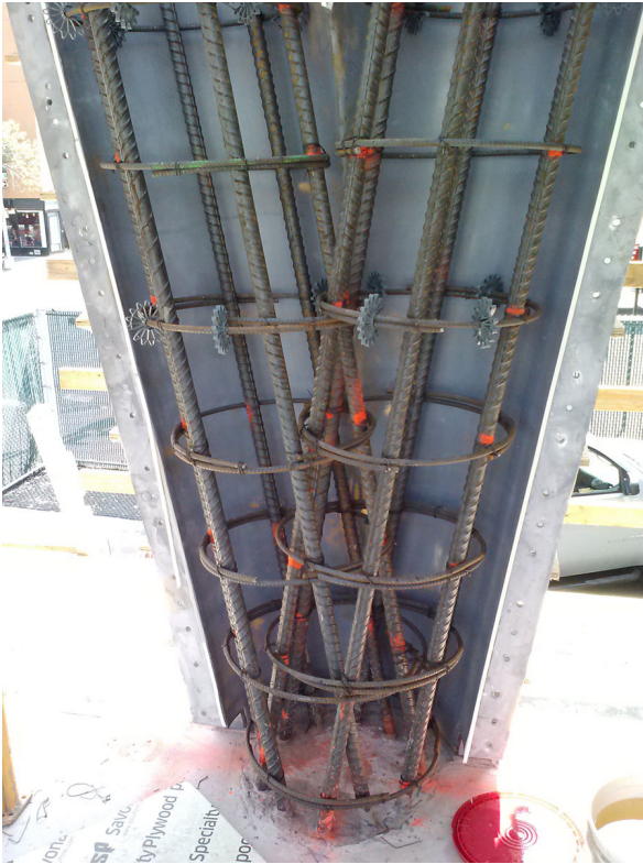
Armado y encofrado de columnas diagonales que forman la estructura diagrid
