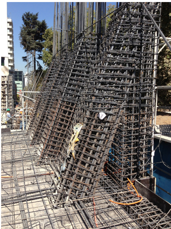
Armado de columnas tijeras para el edificio "Costanera Lyon 2"
