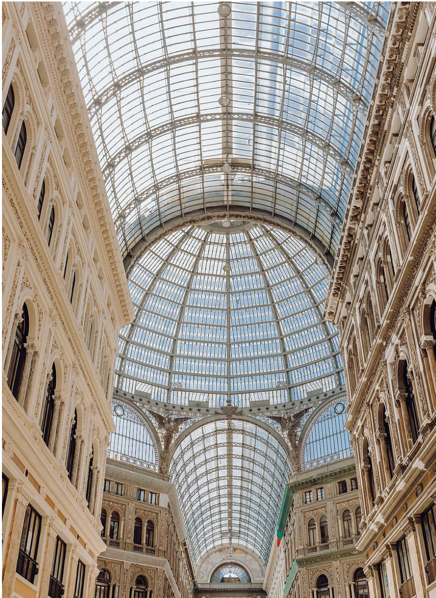
A la izquierda, Galería comercial "Galleria Umberto", Nápoles, Italia.
