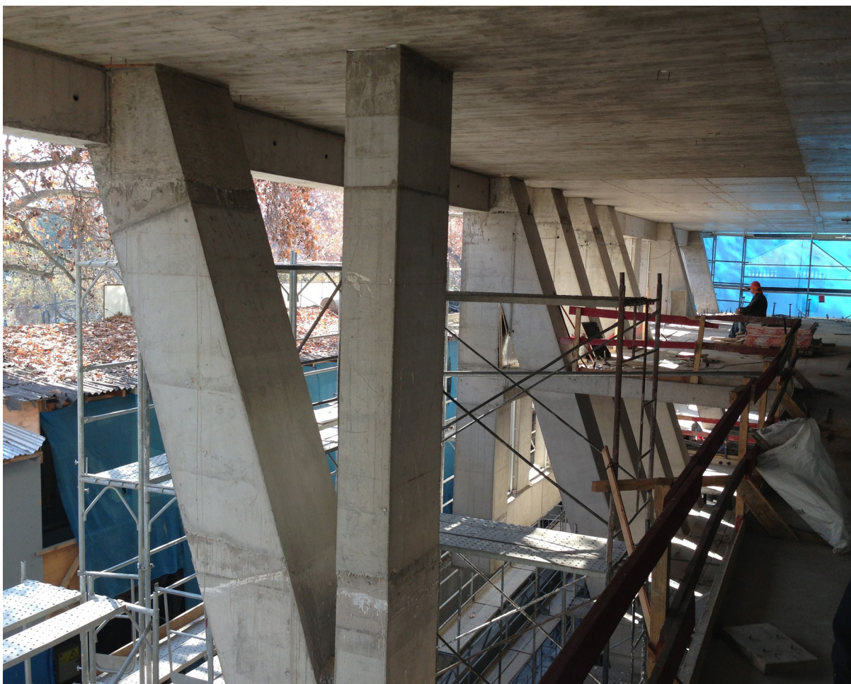
Columnas tijeras del edificio "Costanera Lyon 2"
