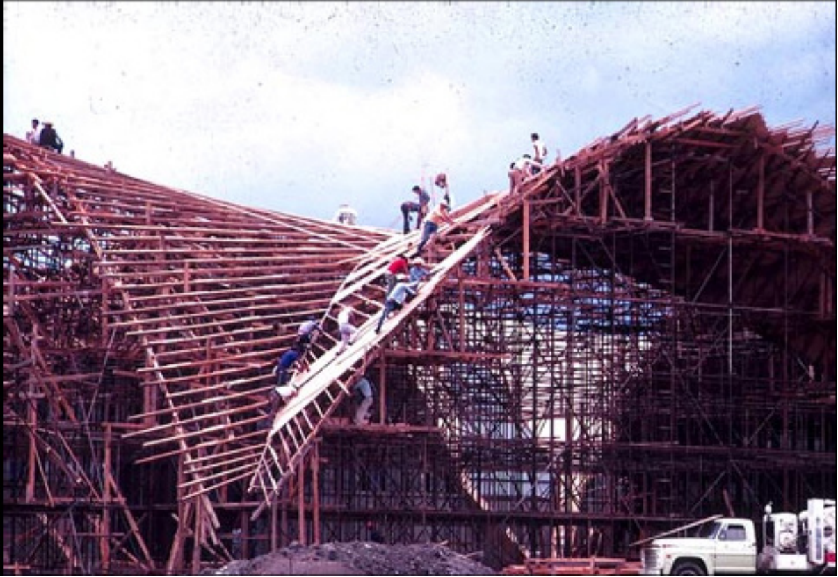
Construcción de paraboloides hiperbólicos con estructura laminar
