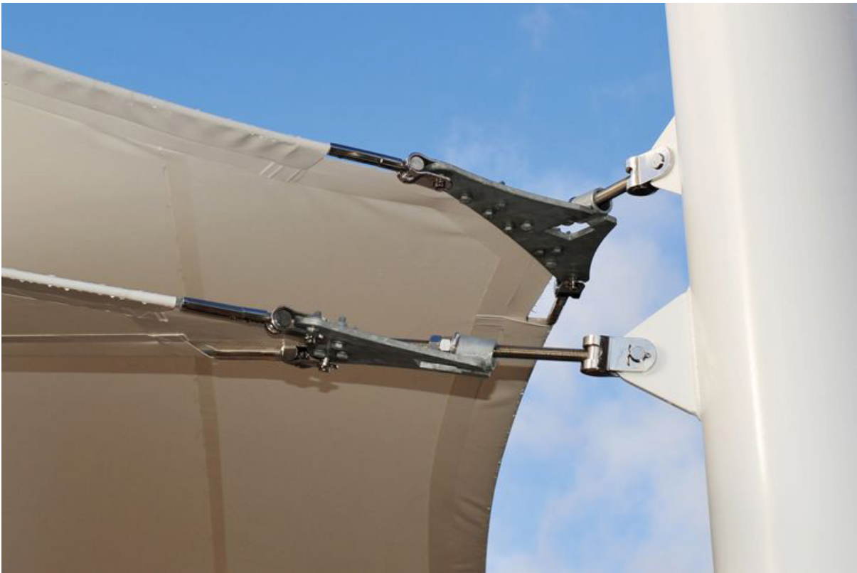
Relingas de una tenso-estructura
