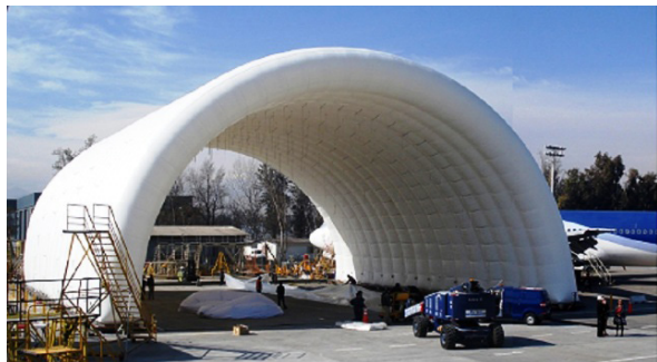
Arriba, una cubierta neumática hinchada con aire a presión
