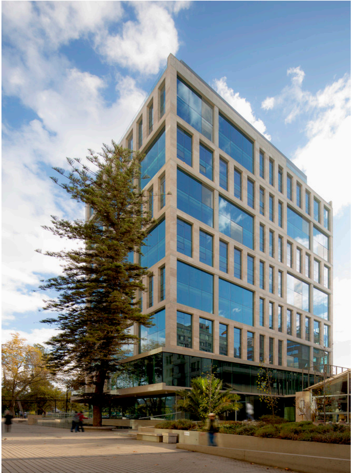
Fachada posterior del edificio corporativo “Costanera Lyon 2”, Providencia, Chile, 2014.
