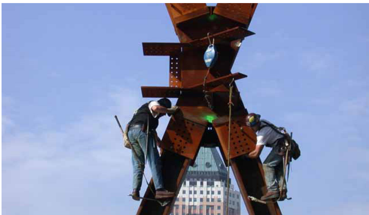
Instalación de nodos de conexión del sistema diagrid del Hearst Tower
