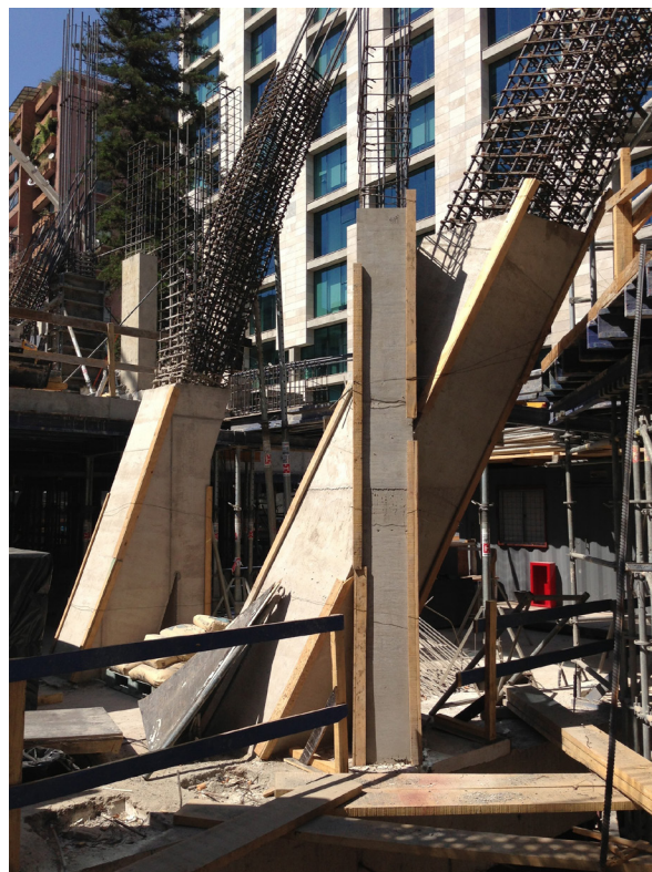
Encofrado de columnas tijeras para el edificio "Costanera Lyon 2"
