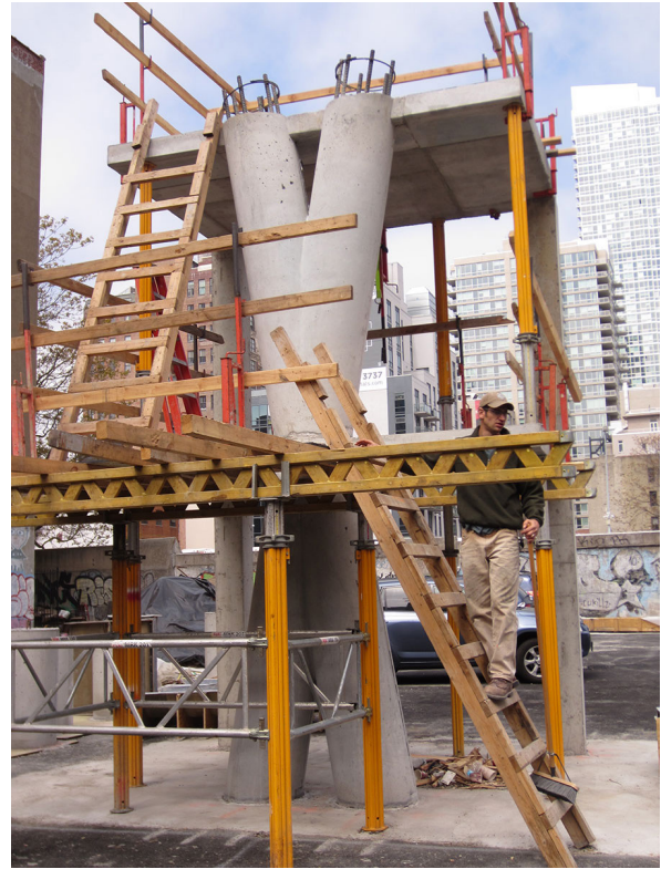
Columnas diagonales que forman la estructura diagrid de la torre 170 Amsterdam
