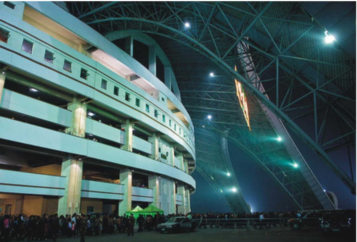
Estructura espacial de bóvedas del Estadio Rungrado Primero de Mayo
