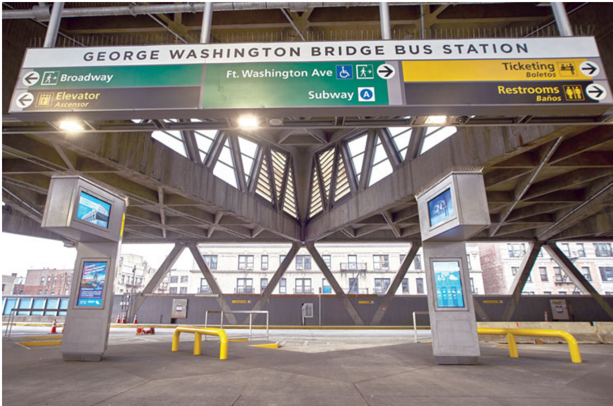
Paradas de buses al interior de la Estación de autobuses del puente George Washington, Manhattan.
