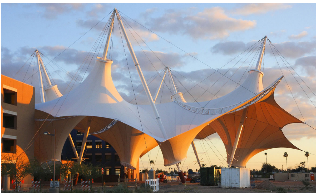
Tenso-estructura donde se observan mástiles puntuales
