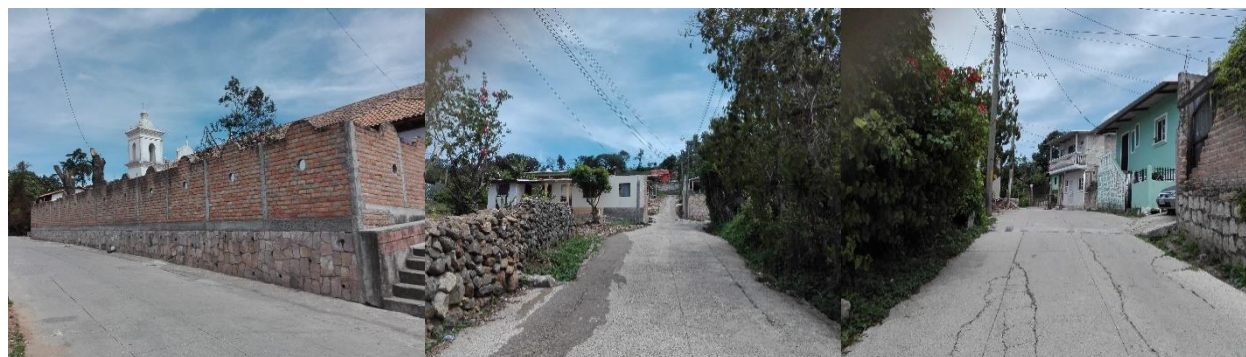
Ilustración 72 Vías Pavimentadas, Fuente Propia
