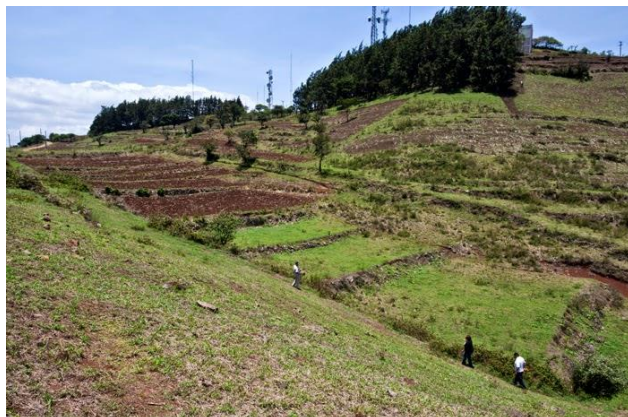
Ilustración 31 Terrazas contenidas con muros de piedra (Sosa, 2014)
