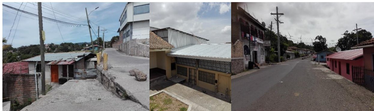
Ilustración 81 Vivienda bajo nivel de calle y construcción de altura/ Visibilidad desde Quiosco en plaza/Vista desde la RN56
