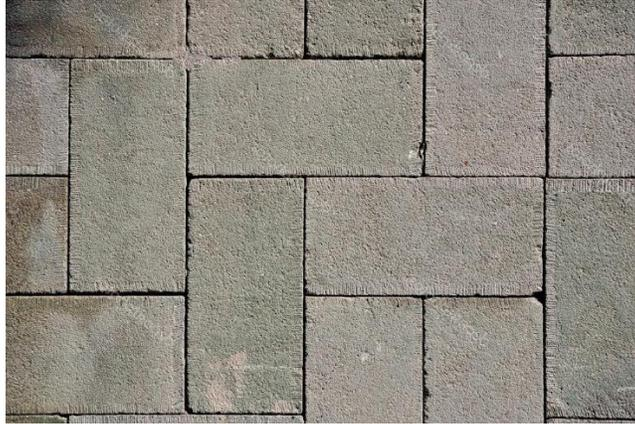
**Ilustración 124: Baldosa de hormigón para aceras.**
