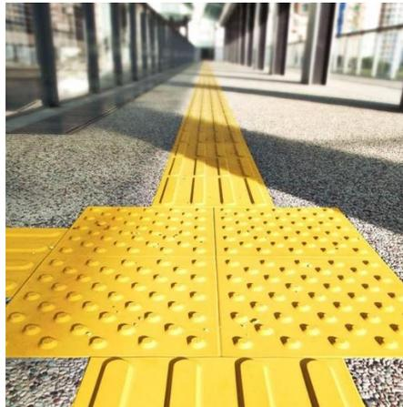
**Ilustración 41: Pavimentos podó táctiles.**
