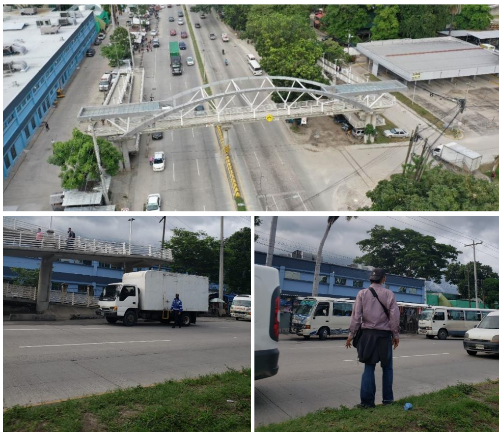
Ilustración 57 Peaton Cruzando al IHSS por debajo del Puente Elevado Peatonal.
