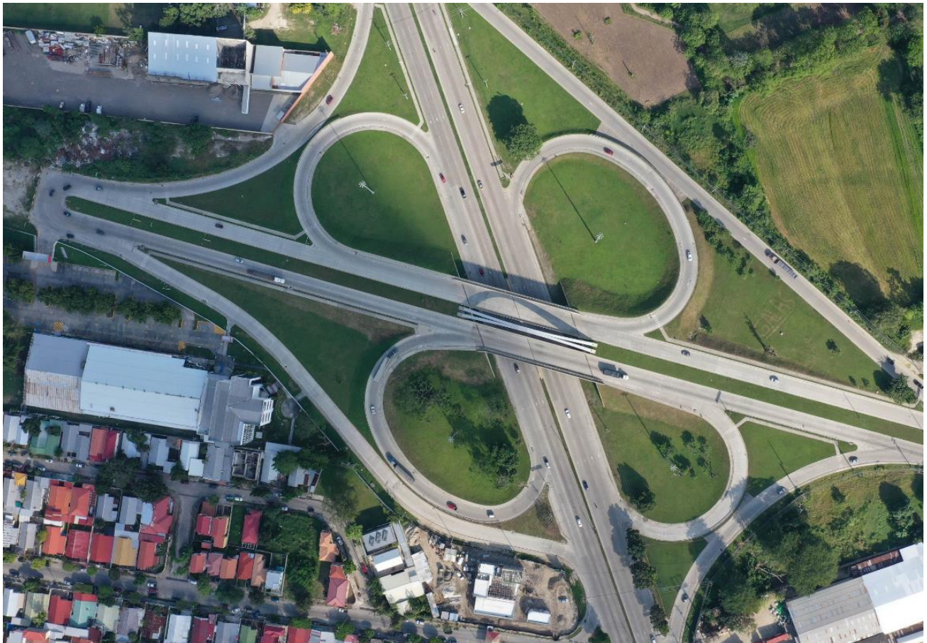
Ilustración 58 Gran Intercambiador del Norte.
