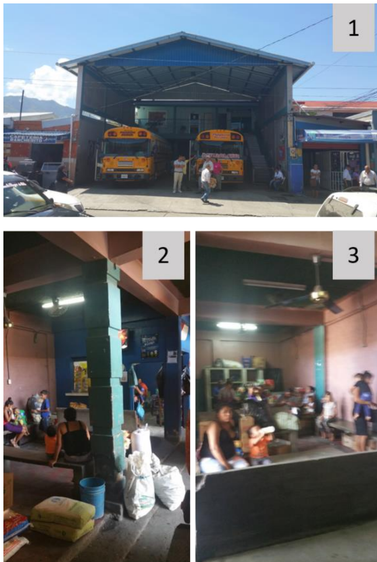
Ilustración 23. Terminal de empresa de transportes Unidos
