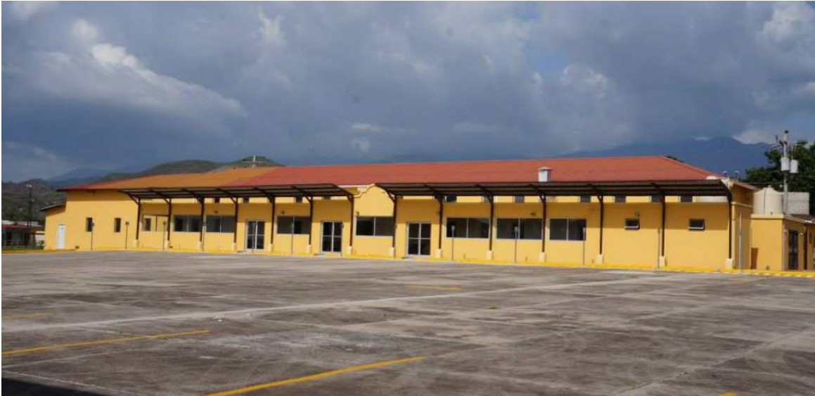
Ilustración 41. Fachada frontal de terminal de buses en Comayagua
