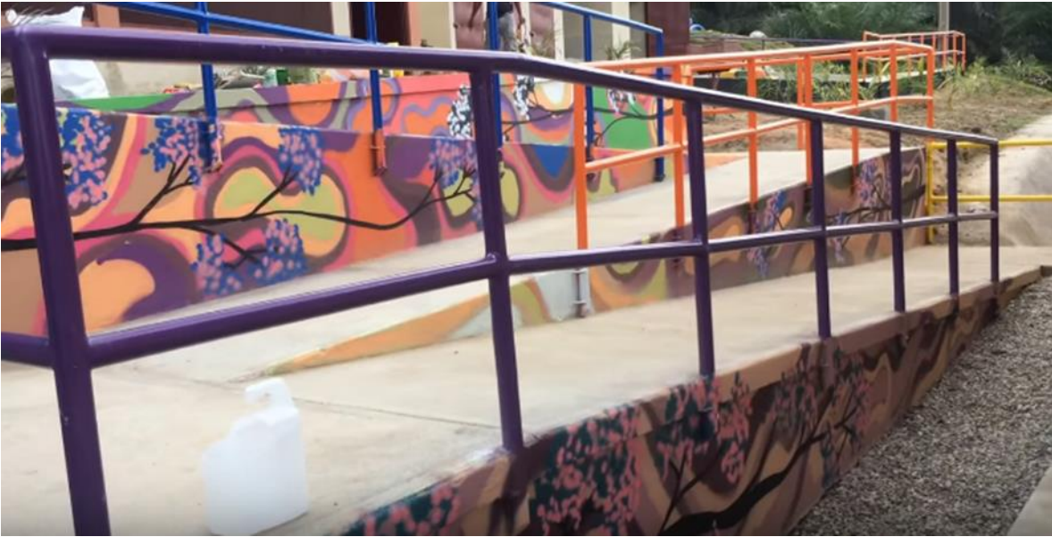
Ilustración 52. Rampa de Accesos entre Aulas.
