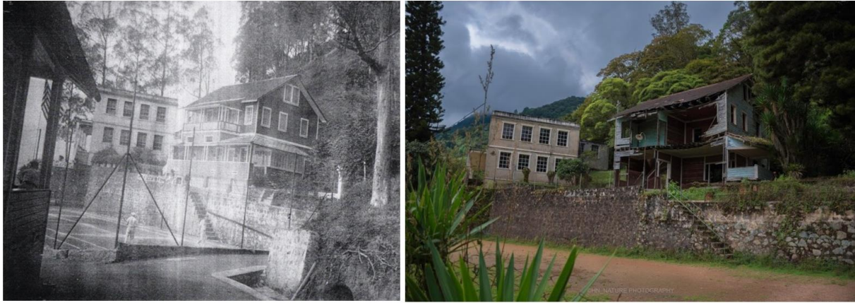
Ilustración 6. Comparación del pasado y la situación actual del Consulado, la cancha de tenis y la residencia del Superintendente de la Compañía, años 1930 y 2017.
