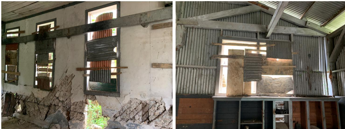
Ilustración 90. Láminas de zinc colocadas en los vacíos.
