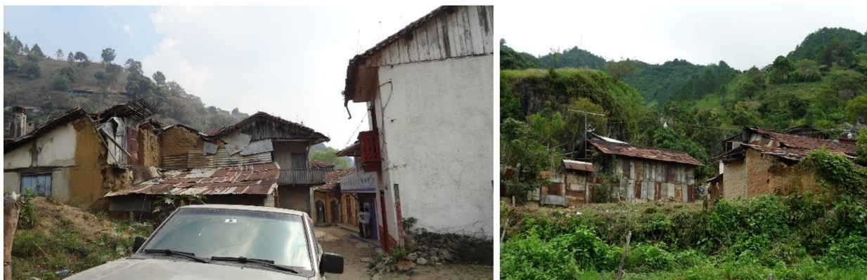
Ilustración 61. Viviendas actuales de los residentes de San Juancito predominando los mismos materiales del pasado.
