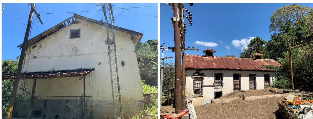
Ilustración 81. Techo a dos aguas y dos buhardillas que sobresalen de este.
