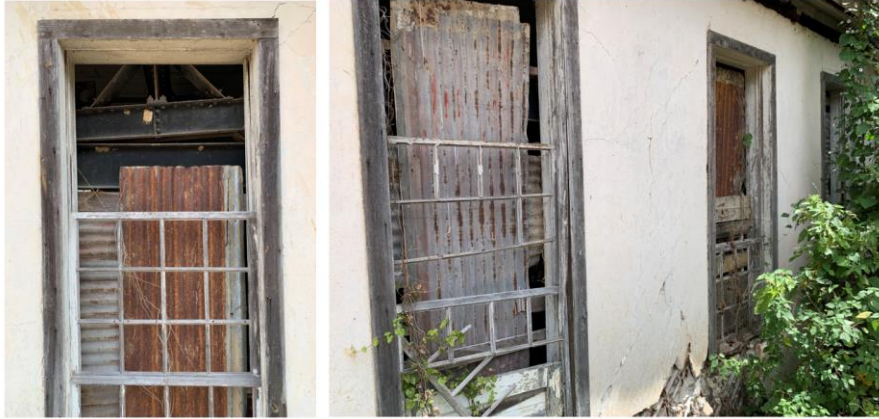
Ilustración 82. Ventanales estilo francés en la fachada principal, con marcos de madera.
