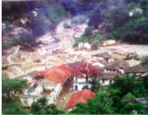
Ilustración 41. Daños ocasionados en San Juancito por el Huracán Mitch, 1998.
