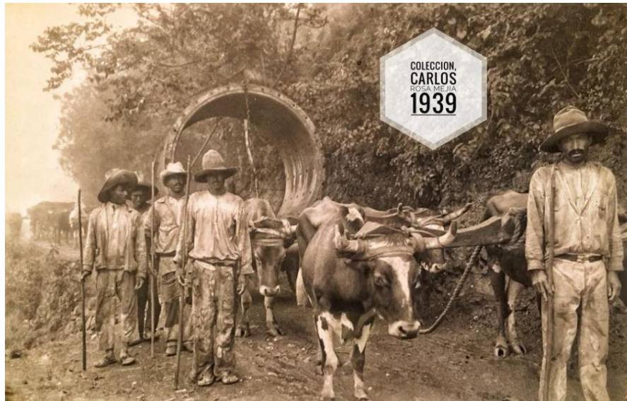
Ilustración 35. Trabajadores transportando las tuberías del sistema hidroeléctrico, con yuntas de 4 bueyes, año 1939. Nótese la labor exhaustiva y sacrificada plasmada en la triste imagen.
