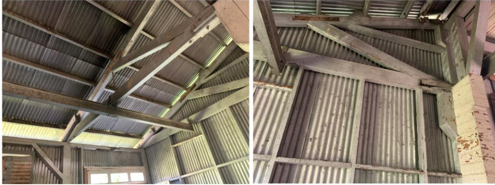
Ilustración 85. Estructura del techo, cerchas de madera.
