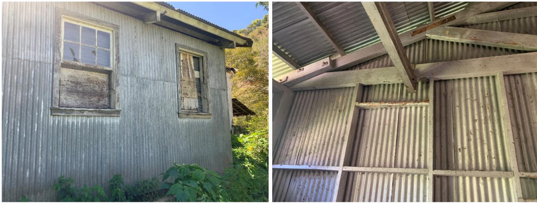
Ilustración 87. Paredes de lámina de zinc y un armado de madera.
