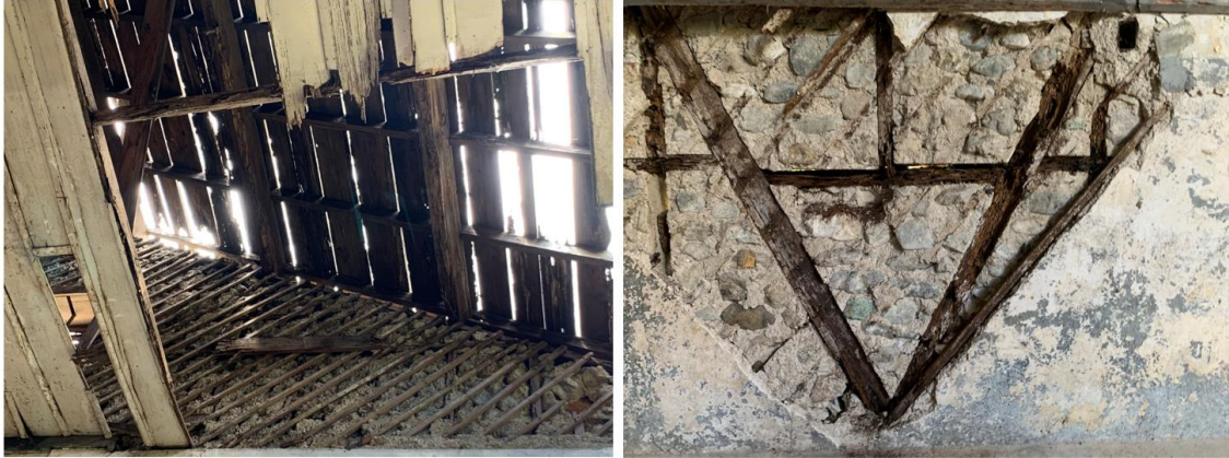
Ilustración 36. Sistema constructivo de La Antigua Planta Hidroeléctrica, San Juancito.
