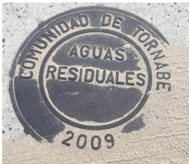
Fotografía 15 Tapadera de alcantarillado público Fuente: (Archivo de los Autores)
