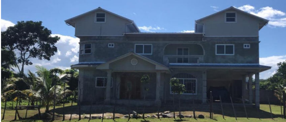
Fotografía 6 Casa a las orillas de Tornabé
