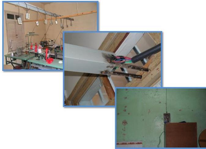
**Ilustración 29 Mal estado de las instalaciones eléctricas**
