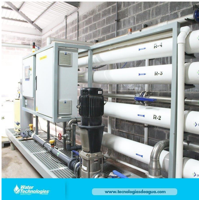
Anexo #3. Proyecto Industrial, Osmosis inversas con 4 membranas
