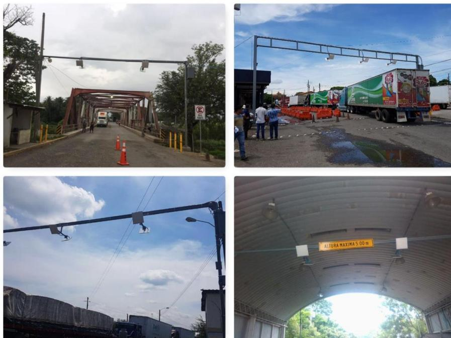
**Ilustración 6: Antenas lectoras de etiquetas de RFID**
