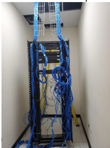
Figura 4: instalación de puertos y etiquetado.
