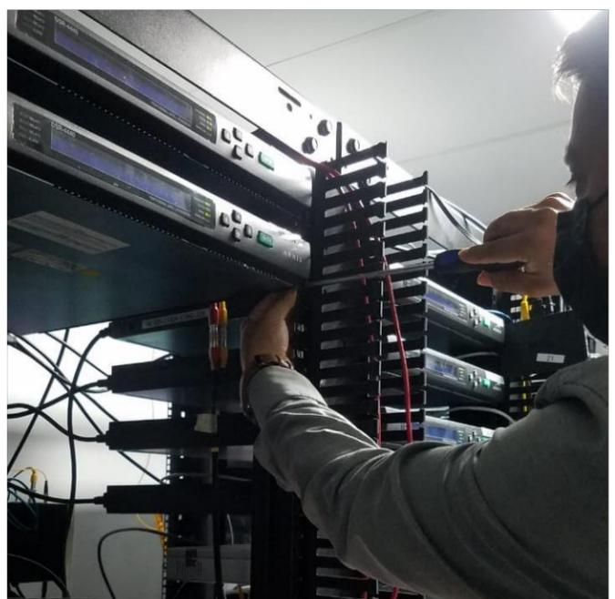
**Ilustración 26 Actividad de Instalación de Equipos Zte**
