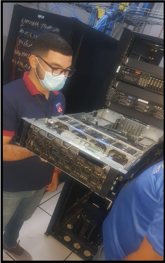
Ilustración 49. Mantenimiento y adición de discos duros a servidor DELL POWER EDGE R940 RACK SERVER
