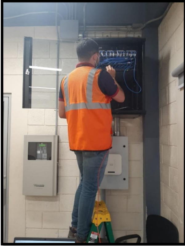
Ilustración 50. Reubicación de cables de red
