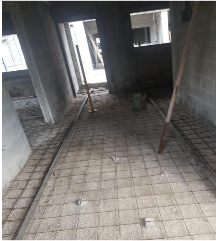
Ilustración 3. Área de Firme preparada para fundir
