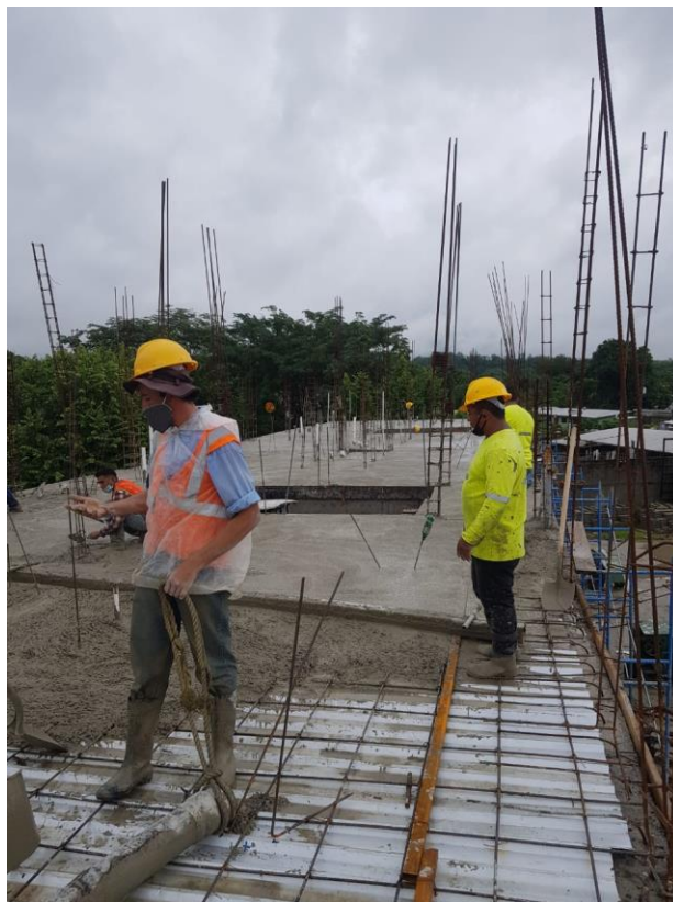
Ilustración 14. Fundición de losa de entrepiso concreto 4,000 psi Revenimiento de 6 1/2 plg
