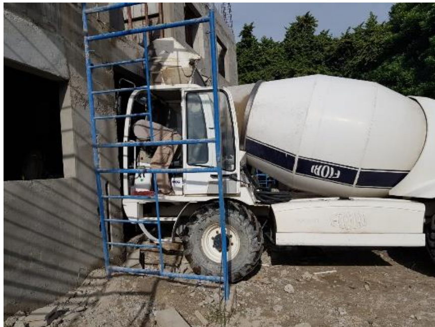
Ilustración 4. Fundición del firme con concreto 4000 psi
