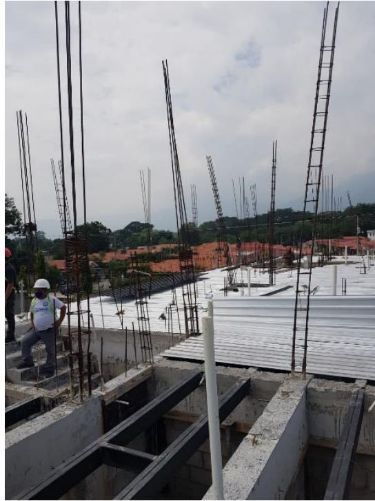
Ilustración 10. Laminado para losa de entepiso
