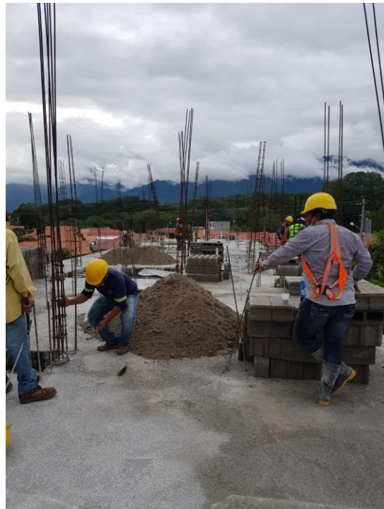
Ilustración 16. Se comenzó a subir material para el pegado de bloque en losa de tercer nivel edificio C
