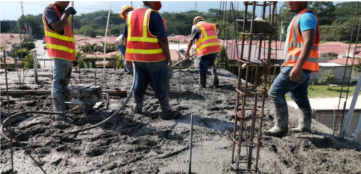
Ilustración 22. Fundición losa entrepiso tercer nivel edificio B
