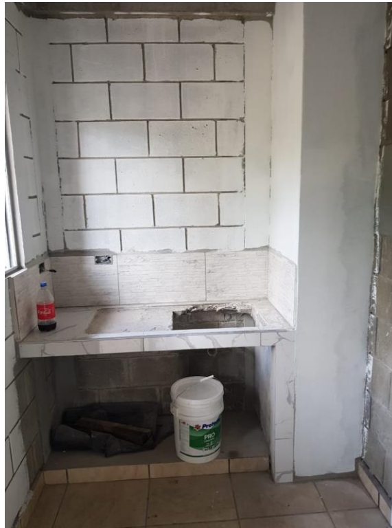
Ilustración 18. Enchape final de mueble de cocina para Apartamento Modelo
