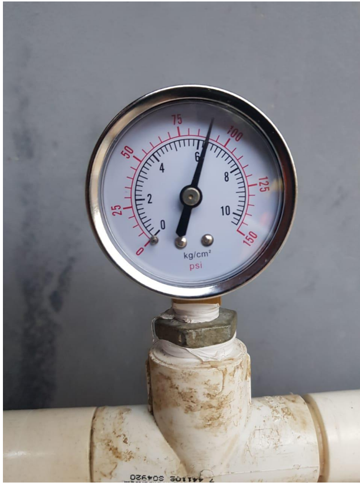
Ilustración 23. Medición de presión para prueba hidrostática en apartamento modelo para concluir con su entrega
