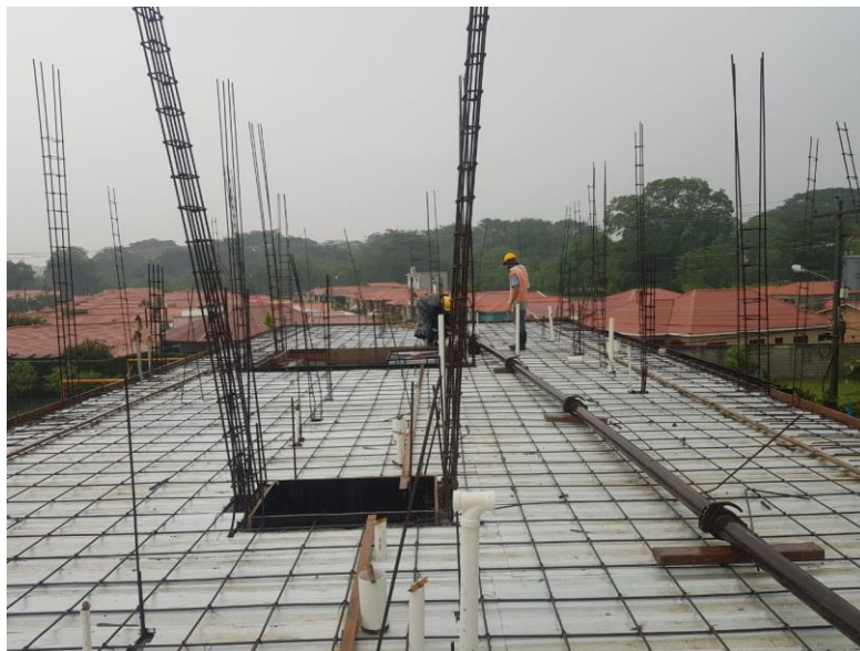
Ilustración 11. Instalación de tubería para fundir losa de entrepiso
