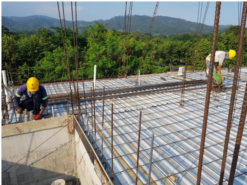
Ilustración 9. Armado de hierro para losa de entepiso
