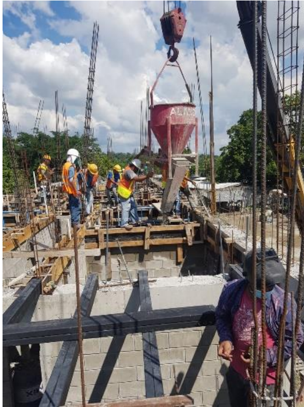
Ilustración 7. Proceso de fundición de vigas con cubilete y grúa
