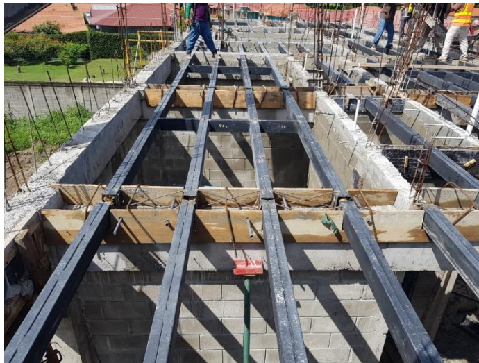
Ilustración 8. Instalación de cajones de canaleta y encofrado para fundición de los remates en viga
