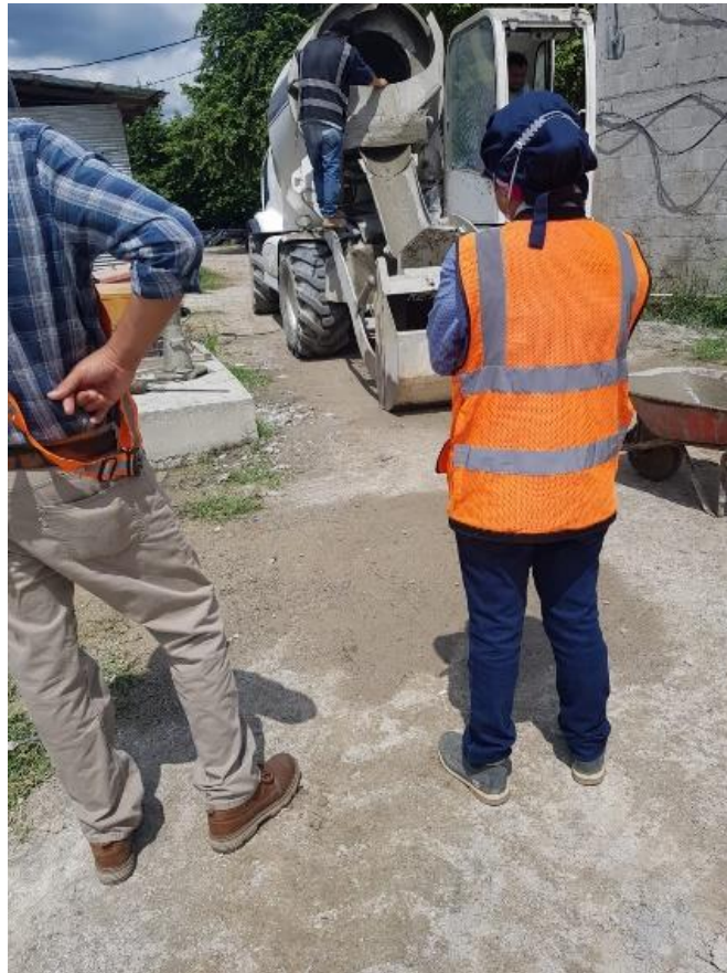
Ilustración 2. Prueba de Revenimiento para fundición de firme
