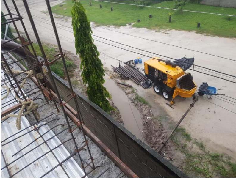
Ilustración 13. Instalación de bomba para colar concreto
