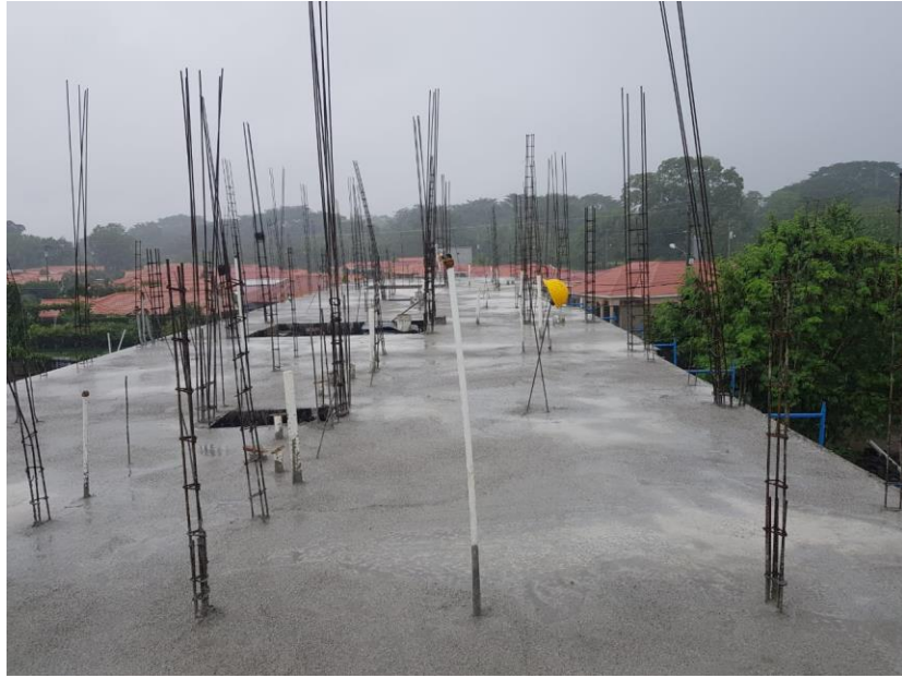
Ilustración 15. Finalización de losa Edificio C
