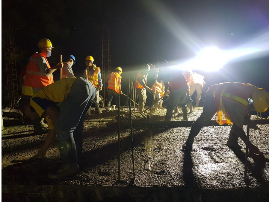
Ilustración 21. Fin de fundición losa tercer nivel edificio A
