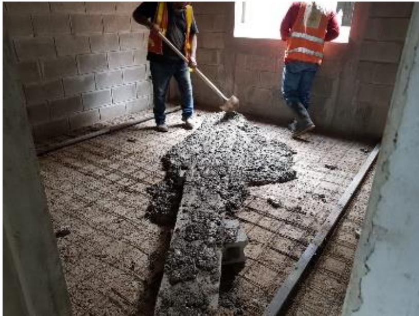
Ilustración 6. Proceso de fundición de un firme
