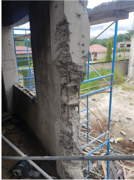
Ilustración 19. Demolición de columna por desfase y exceso de recubrimiento
