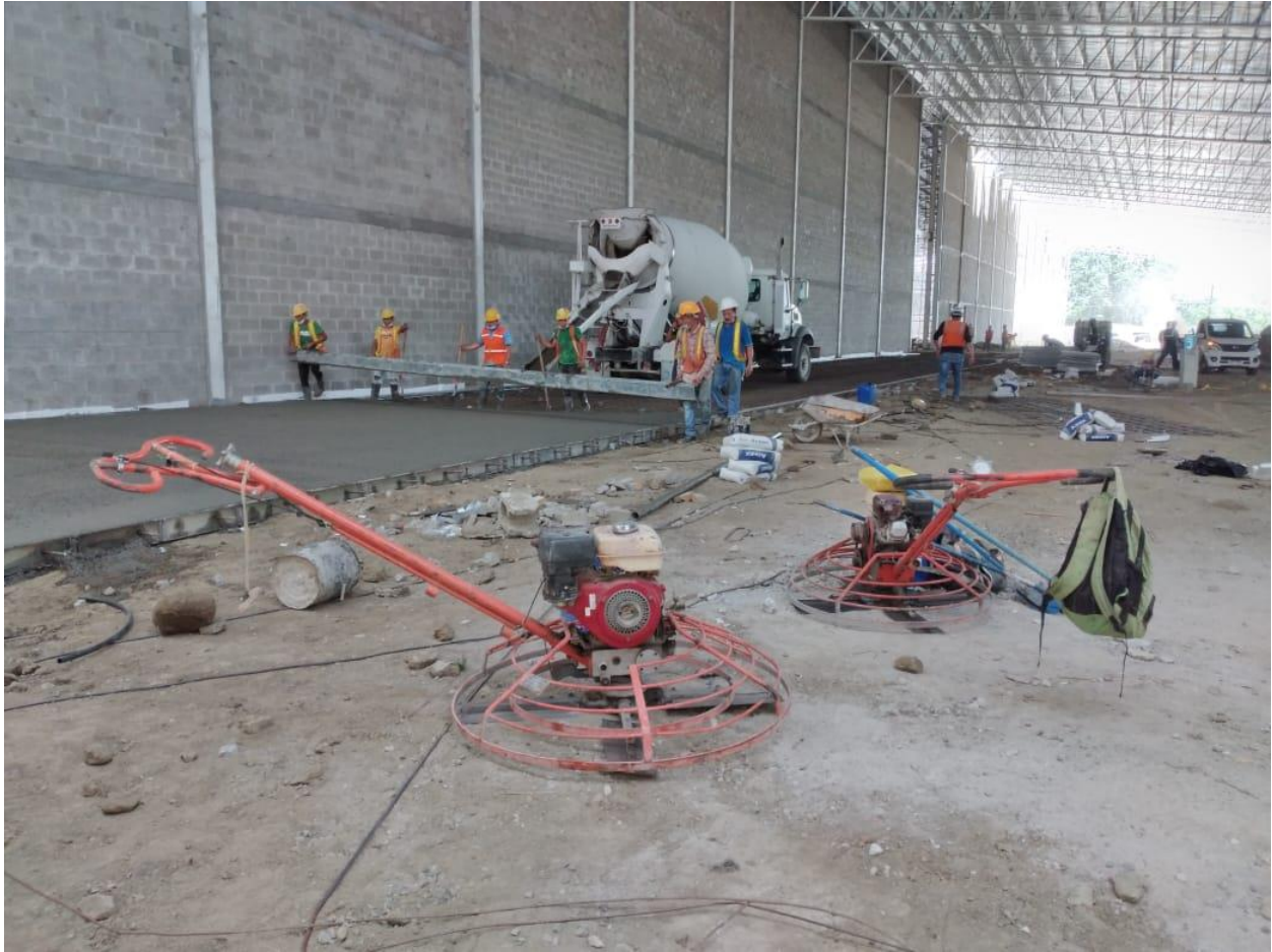
Ilustración 35: Descarga de concreto
