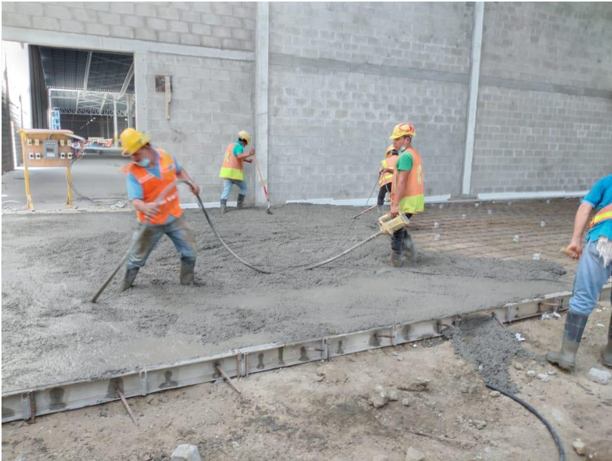
Ilustración 34: Vibrado de concreto
