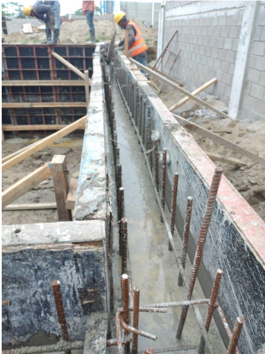
Ilustración 26: Fundición de pared de concreto en cisterna de lodos
