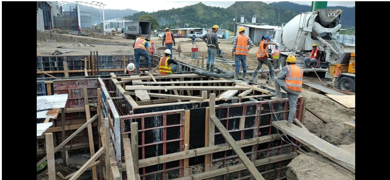
Ilustración 27: Descarga de mixer a cisterna
