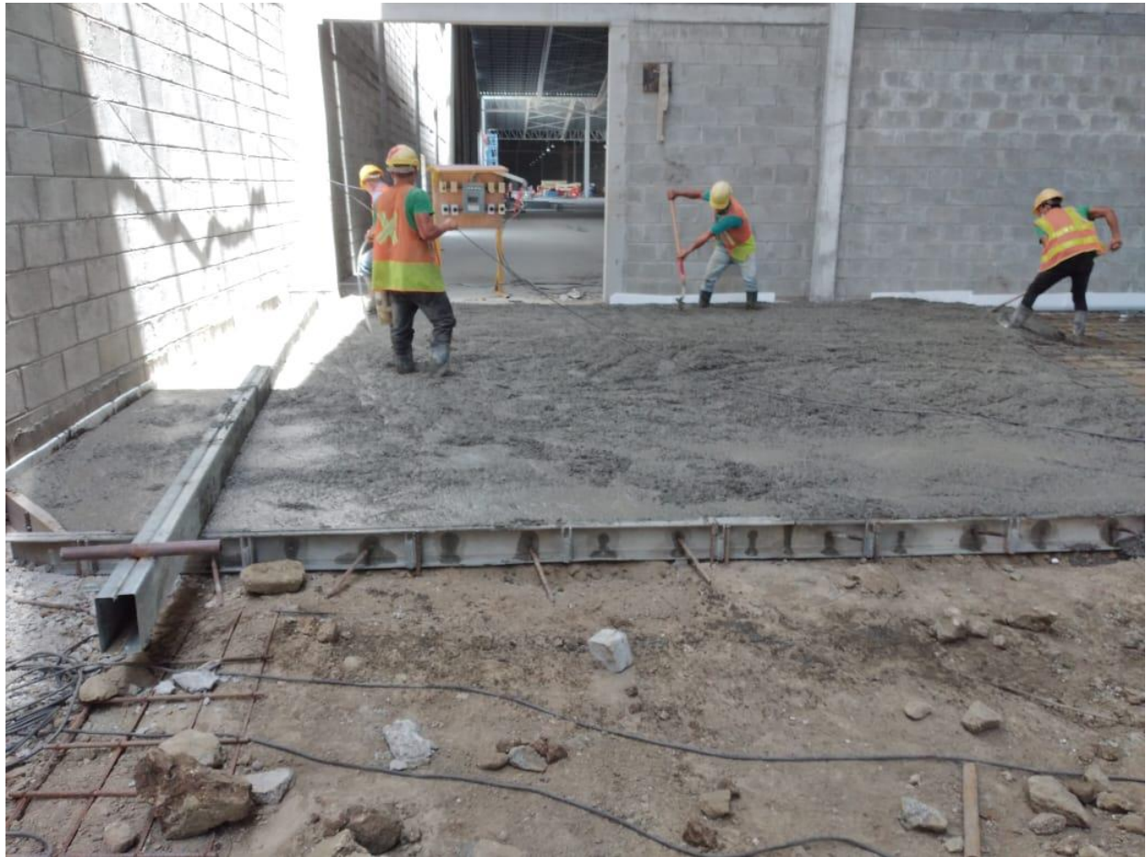
Ilustración 33: Colado de concreto para piso de Nave A
