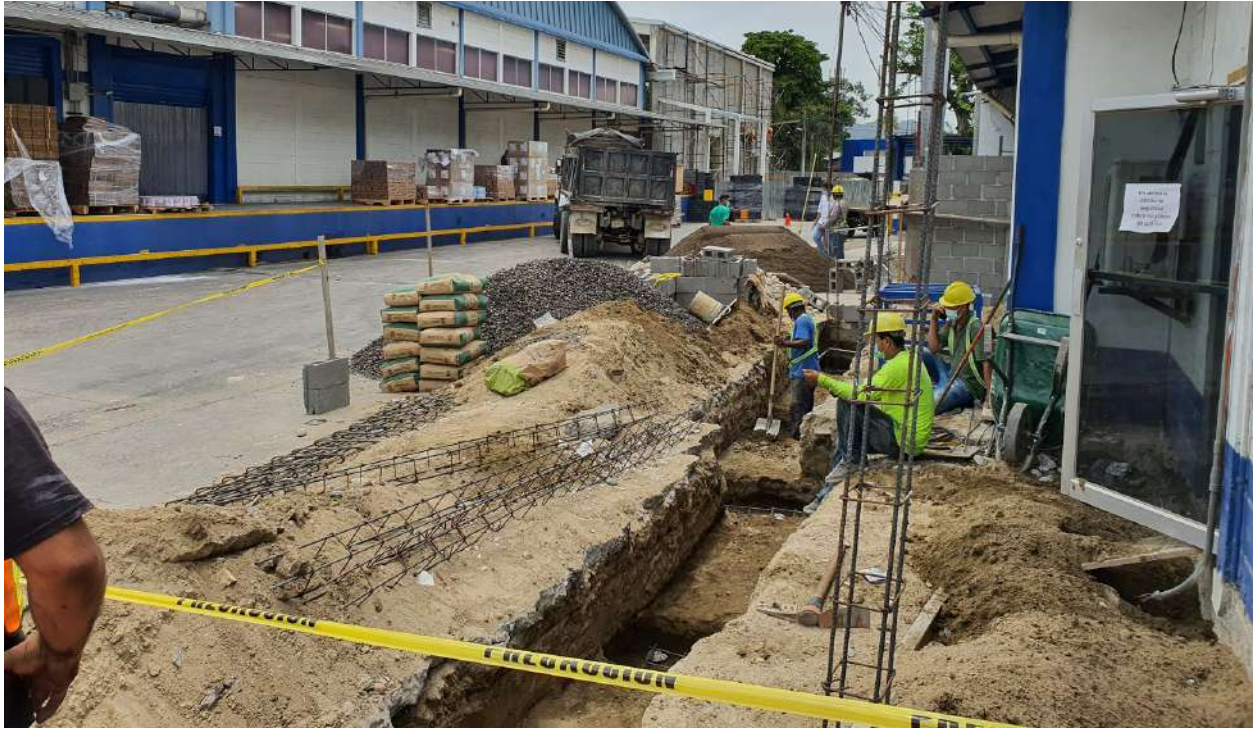
Ilustración 14. Excavación para cimentación en proyecto despacho I+D
