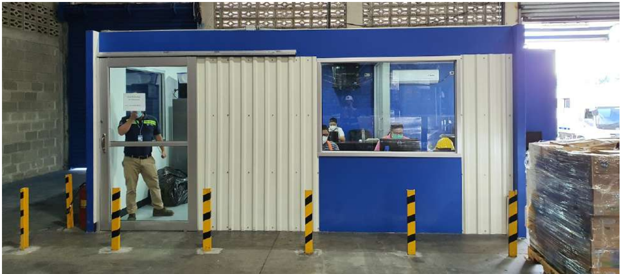
Ilustración 12. Proyecto Oficina en Bodega #6 terminado
