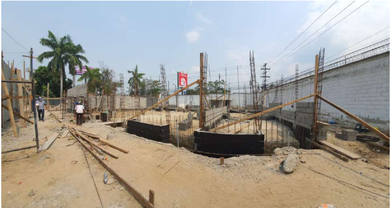
Ilustración 13. Sobre elevación de bloques en proyecto Sula Market (30/04/21)
