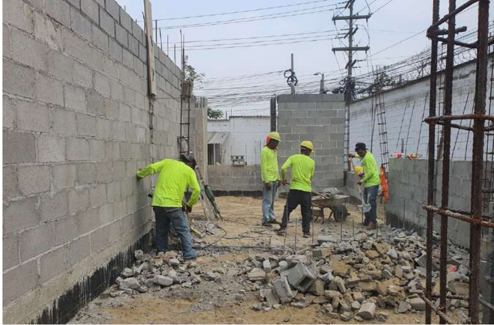
Ilustración 16. Demolición de pared de bloque
