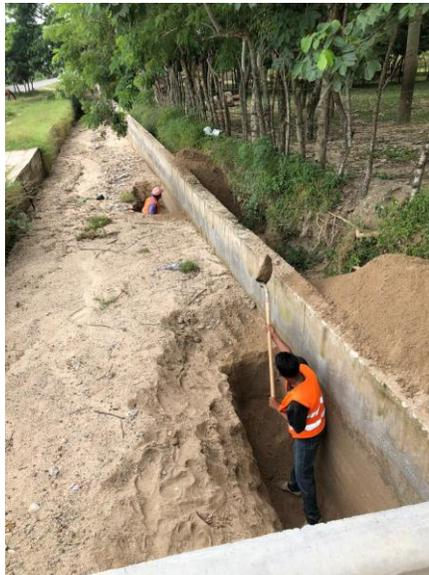
*Ilustración 22. Obreros extrayendo sedimentos dentro de canal en proyecto de El Negrito, Yoro.*
