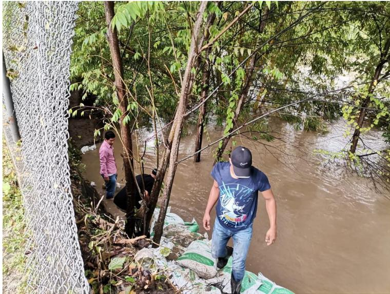
*Ilustración 29. Colocación de sacos rellenos en Lima Centro, La Lima.*
