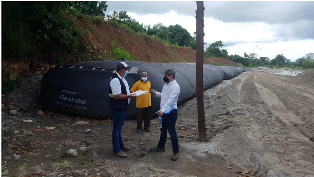
*Ilustración 24. Instalación de Geotubos en Rio Tegucigalpa.*
