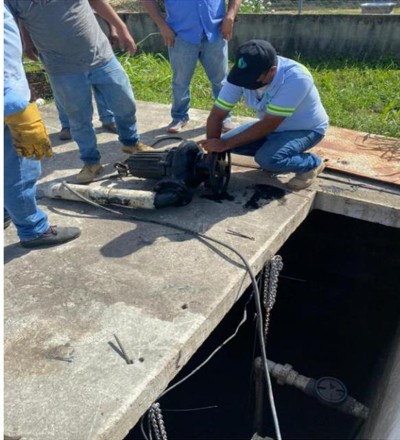
Ilustración 21. Cambio de Bomba en la Estación Elevadora
