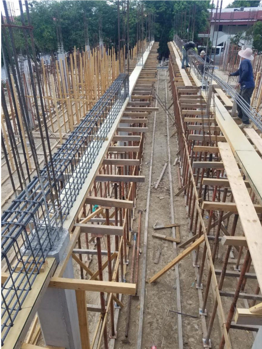
Ilustración 20. -Armado de viga
