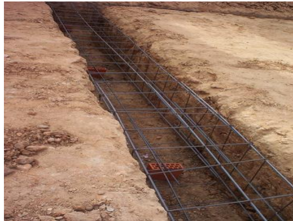
Ilustración 6. -Armado de zapata corrida
