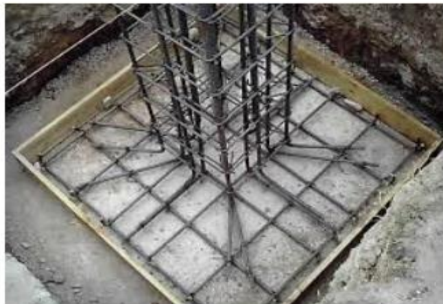
Ilustración 4. -Armado de zapata aislada
