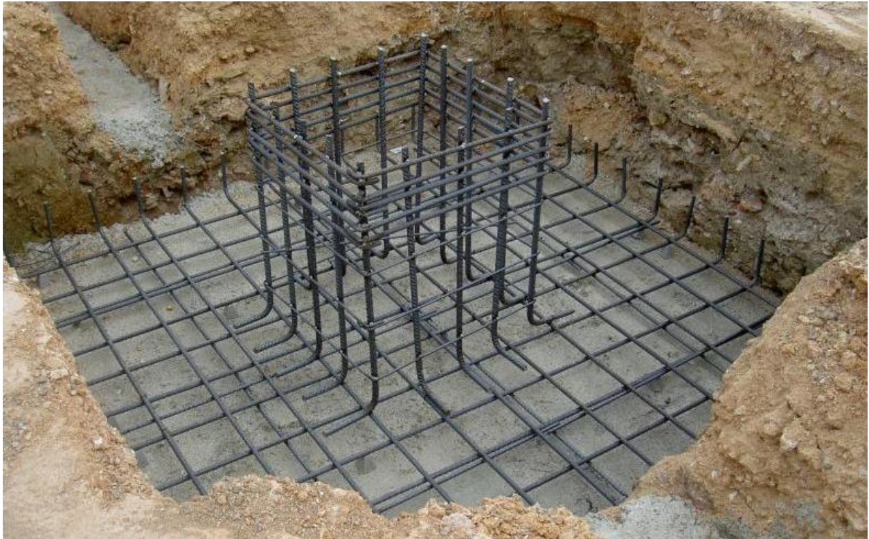
Ilustración 5. -Zapata aislada fundida
