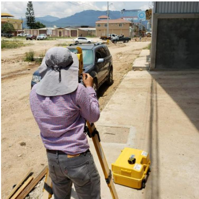
**Ilustración 29-Comprobación de nivel de subbase**
