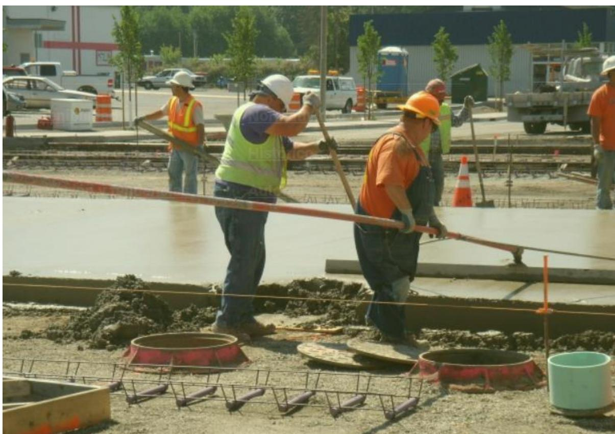
**Ilustración 3-Fundición de Carpeta de concreto**
