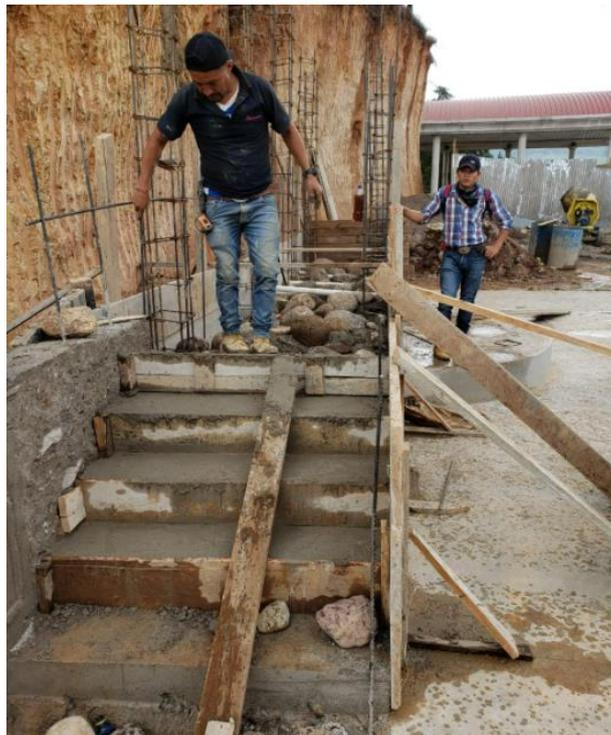
**Ilustración 17-Cimentación de muro de Contención de Parque vida mejor**
