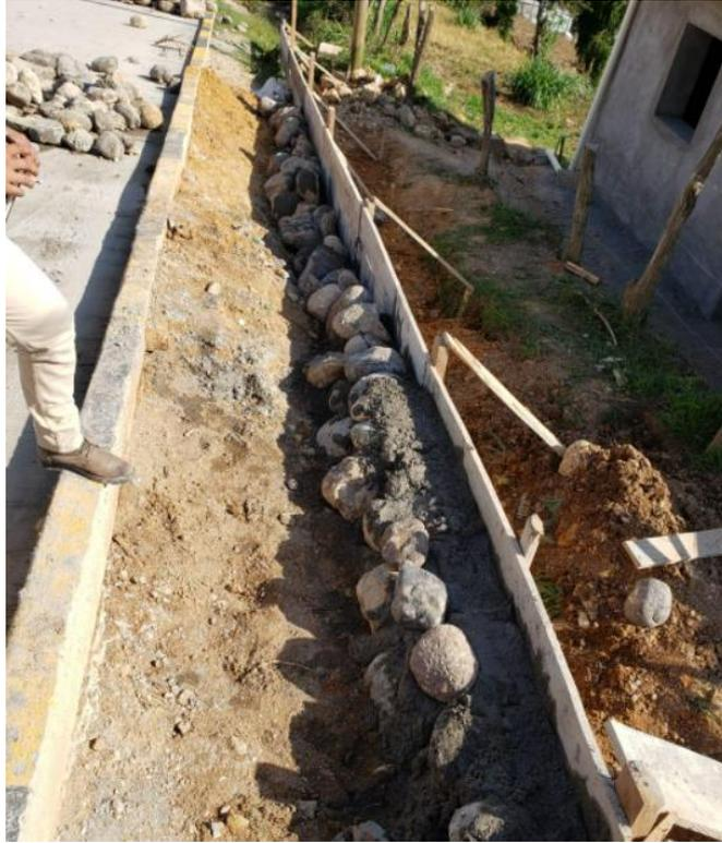
**Ilustración 36- Construcción de acera de Mercedes Ocotepeque**
