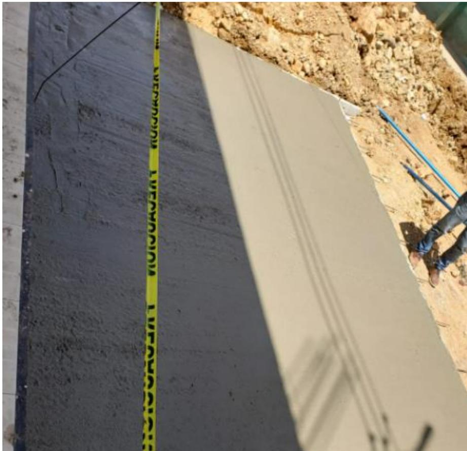
**Ilustración 31- Fundición de concreto hidráulico en barrio Brisas del Campo**
