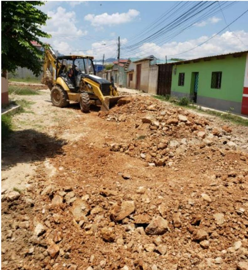
**Ilustración 15-Colocación de subbase para proyecto Hidraulico**
