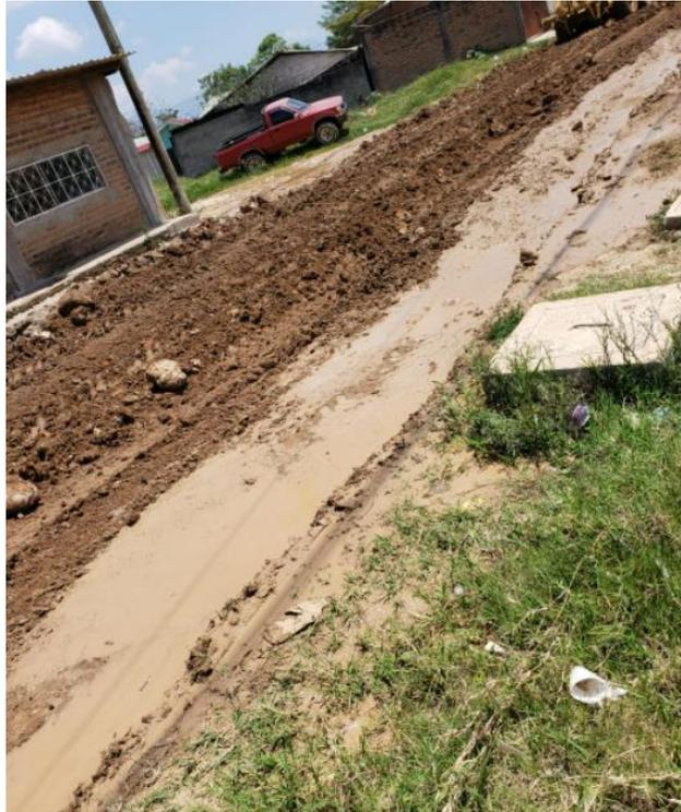
**Ilustración 22-Conformación de subbase pavimento hidráulico**
