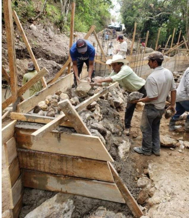
**Ilustración 16-Cimentación de mampostería de caja puente**
