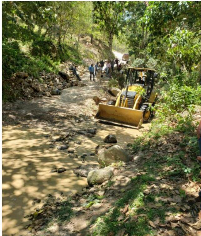
**Ilustración 10-Remoción de piedra para construcción de caja puente**
