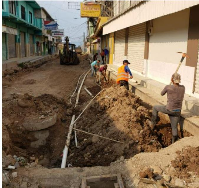
**Ilustración 8-Instalación de tubería de agua potable**
