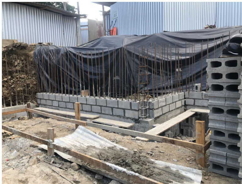
Ilustración 74 – Pegado de bloques
