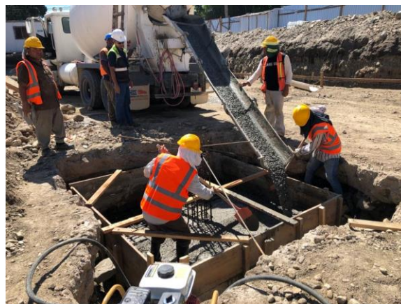
Ilustración 43 – Vaciado de concreto en zapata
