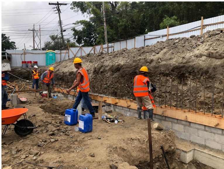
Ilustración 57 – Fundición de solera inferior
