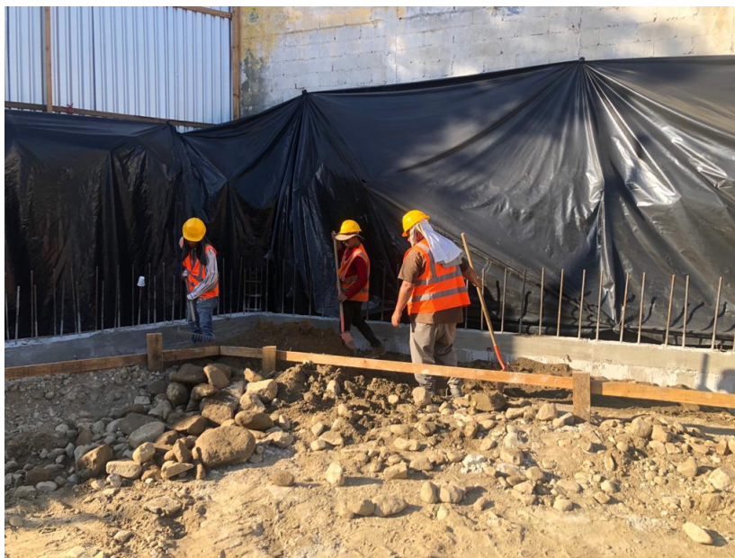
Ilustración 35 – Desencofrado de solera inferior
