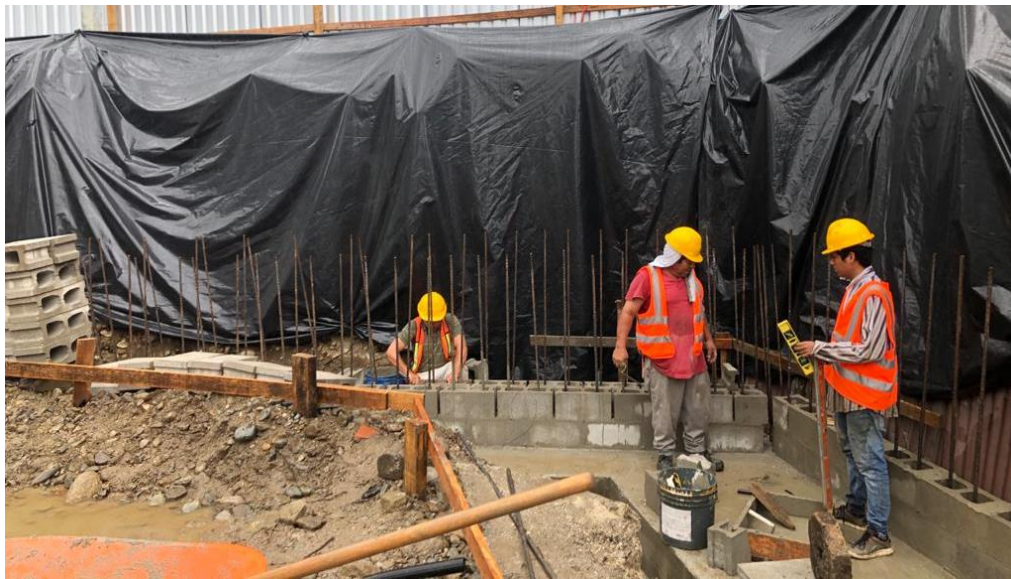
Ilustración 25 – Encofrado de cimiento corrido de muro frontal
