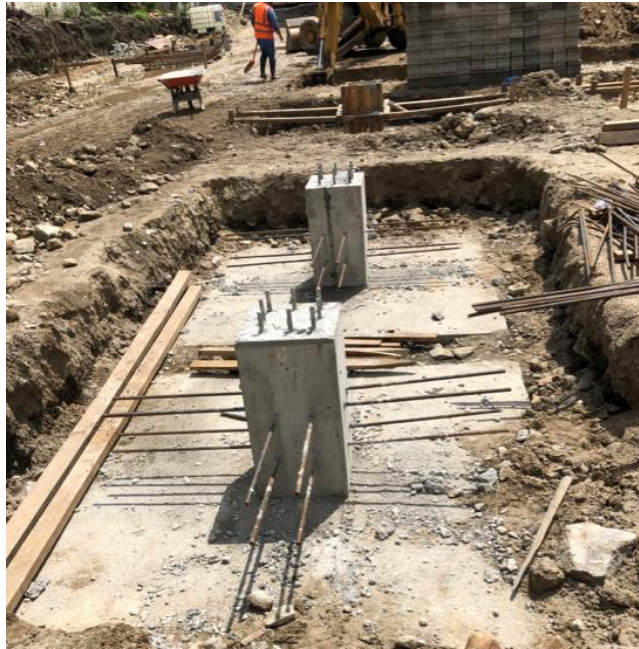
Ilustración 71 – Desencofrado de zapatas
