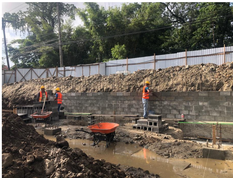
Ilustración 70 – Pegado de bloques
