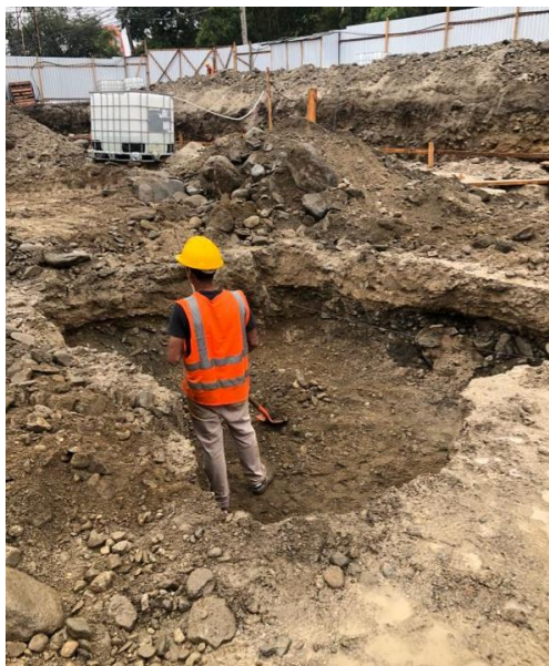
Ilustración 27 – Excavación de zapatas
