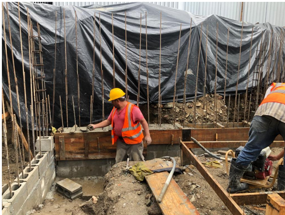
Ilustración 68 – Fundición de solera inferior
