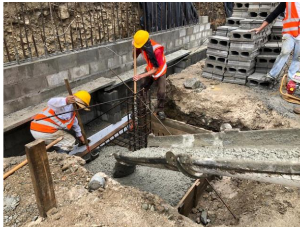
Ilustración 65 – Fundición de zapata
