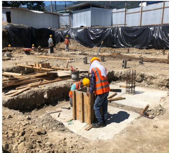
Ilustración 31 – Encofrado de pedestales
