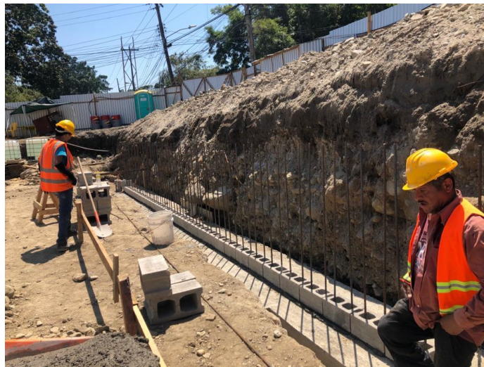
Ilustración 50 – Pegado de bloques muro MC-1 parte frontal
