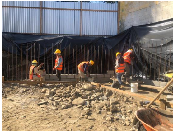
Ilustración 46 – Pegado de bloques
