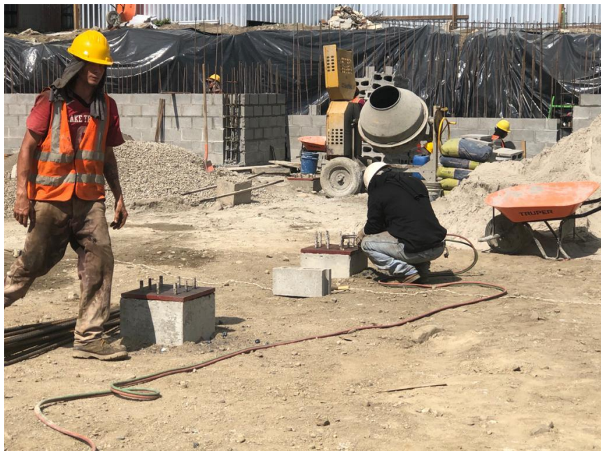
Ilustración 86 – Instalación de placa en pedestal
