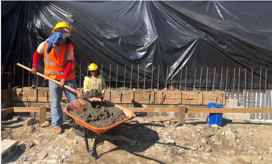
Ilustración 33 – Encofrado y fundición de solera inferior
