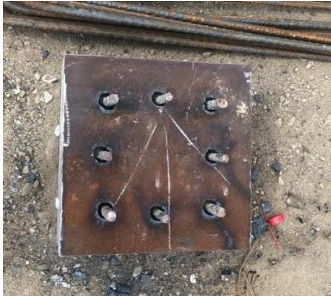
Ilustración 83 – Vista de placa estructural en pedestal
