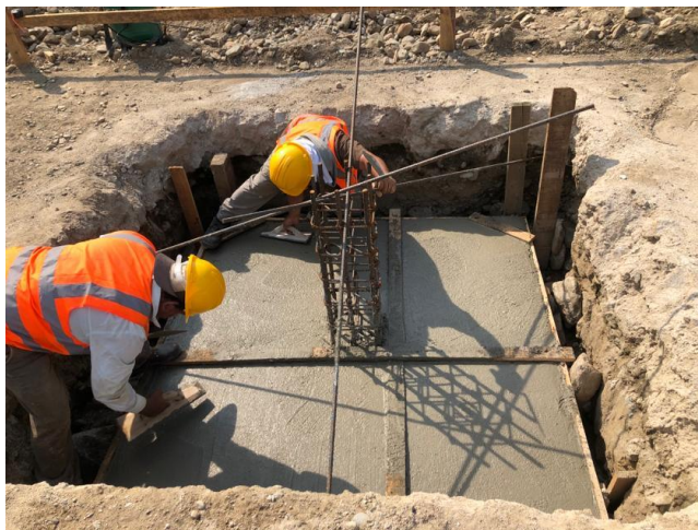
Ilustración 18 - Afinado y alisado superficial a la capa externa del concreto
