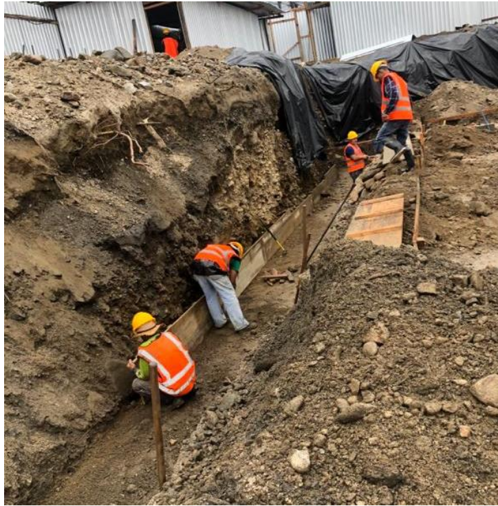
Ilustración 25 – Encofrado de cimiento corrido de muro frontal
