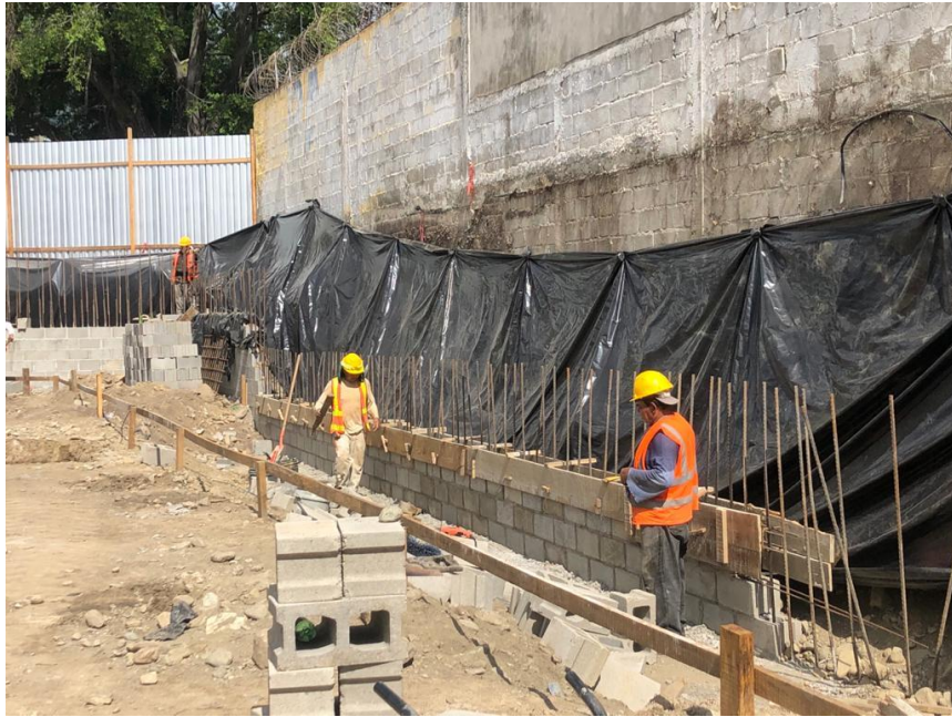
Ilustración 85 – Encofrado de solera
