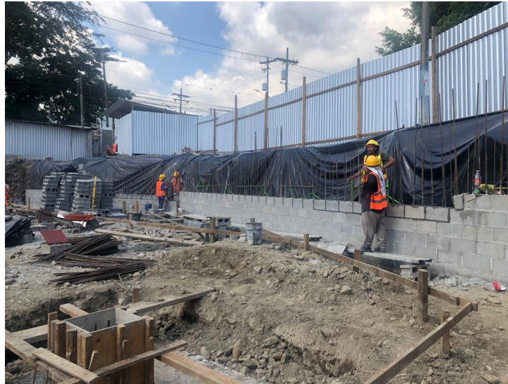
Ilustración 81 – Pegado de bloques
