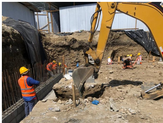
Ilustración 53 – Excavación de zapatas
