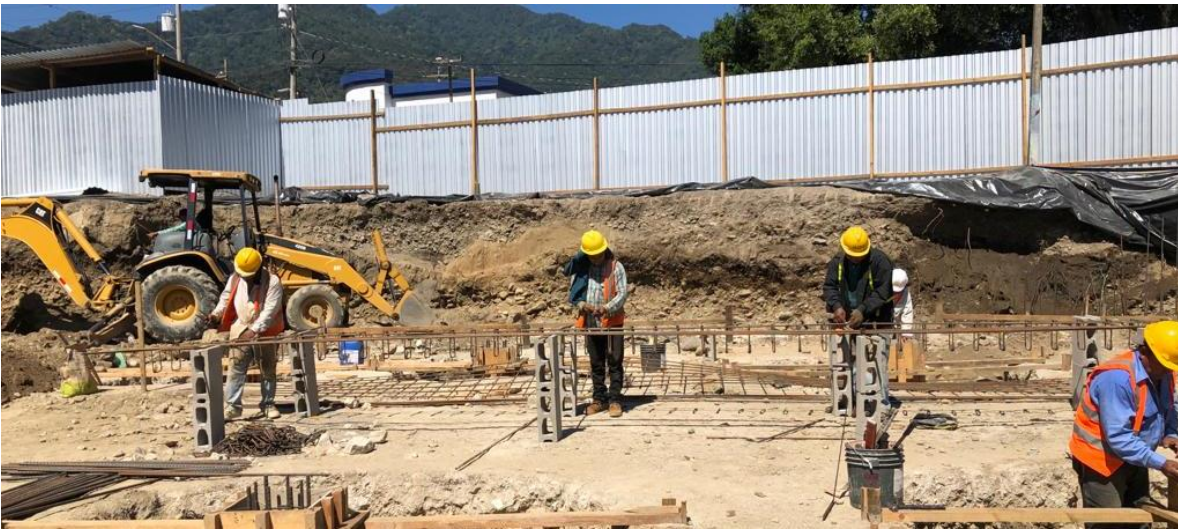
Ilustración 45 – Armado de castillos
