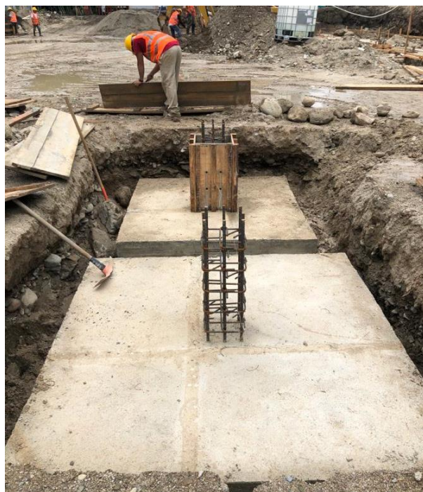
Ilustración 22 – Desencofrado de zapatas
