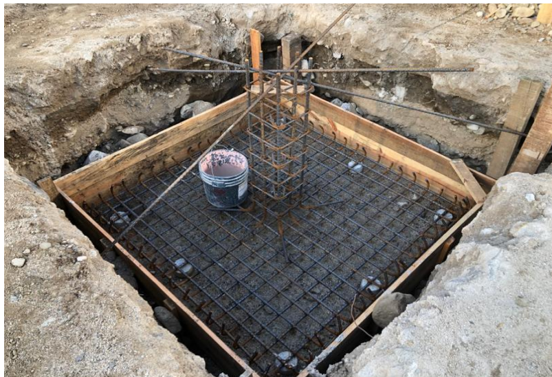
Ilustración 11 – Zapata Z-2 en el eje G-9 lista para fundición
