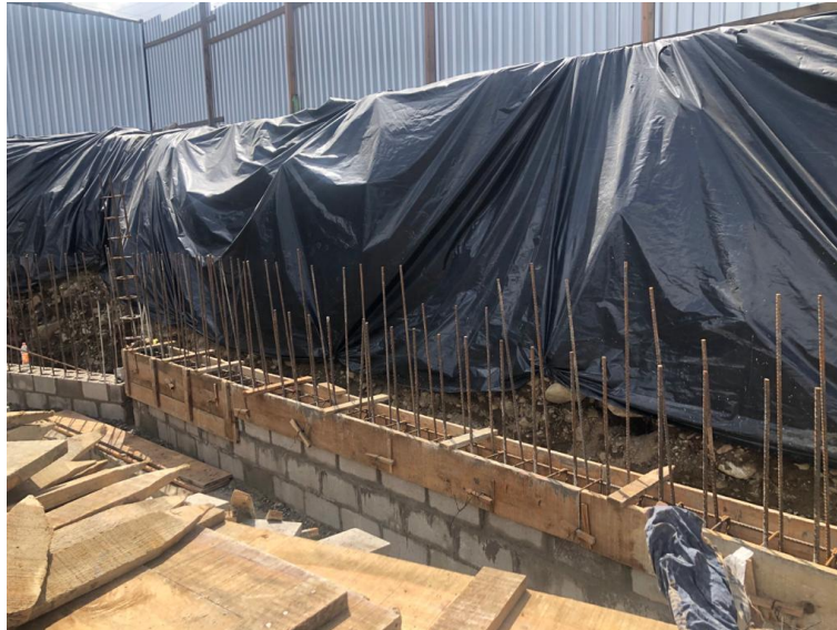
Ilustración 59 – Encofrado y armado de solera inferior
