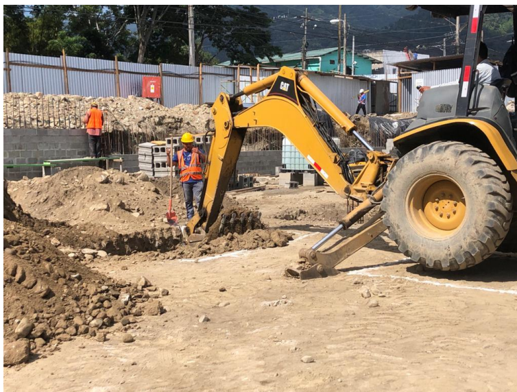
Ilustración 84 – Excavación de zapata aislada
