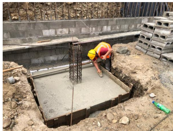
Ilustración 66 – Acabado final de zapata
