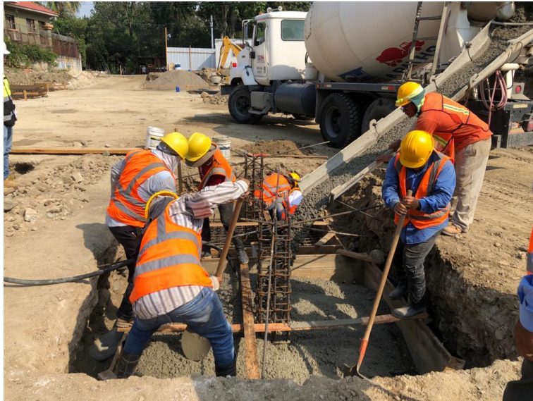
Ilustración 15 – Vaciado de concreto en Zapatas Z-3 y Z-2.
