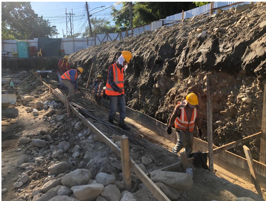
Ilustración 38 – Desencofrado de cimiento corrido
