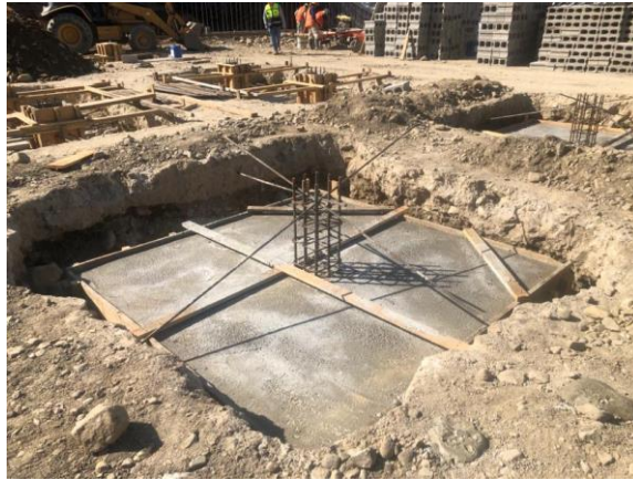
Ilustración 44 – Aplicación de curador en zapata
