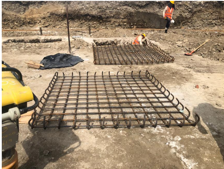
Ilustración 10 – Armado de parilla para Zapatas Z-3
