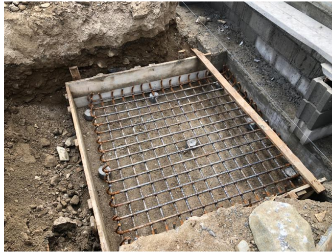
Ilustración 60 – Colocación de armado en zapata
