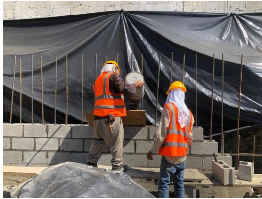
Ilustración 49 – Pegado de bloques muro MC-3 parte posterior
