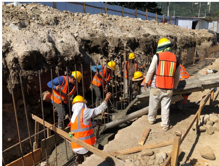
Ilustración 42 – Vaciado de concreto en cimiento corrido
