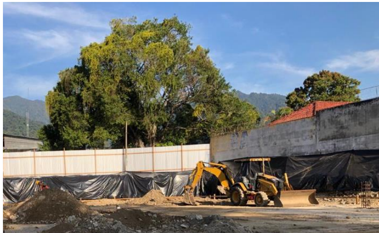
Ilustración 9 – Excavación de Zapatas.
