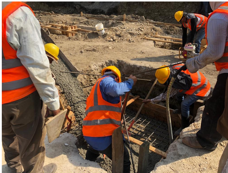
Ilustración 16 – Vaciado y vibrado de concreto en zapata Z-2 ubicada en el eje G-9
