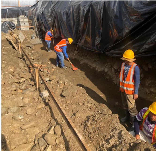
Ilustración 69 – Adecuación y nivelación de terreno para cimiento corrido
