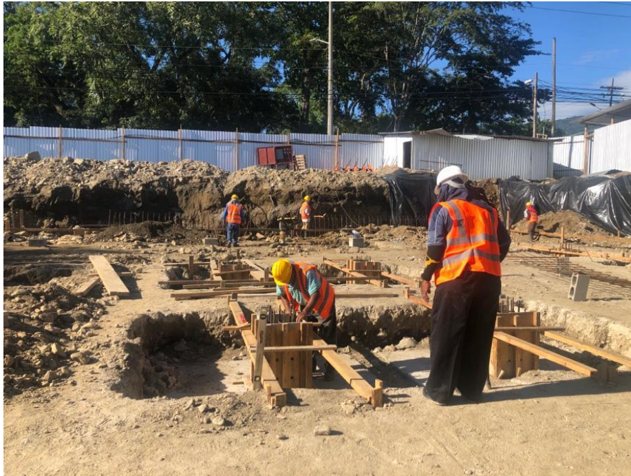
Ilustración 37 – Encofrado de pedestales
