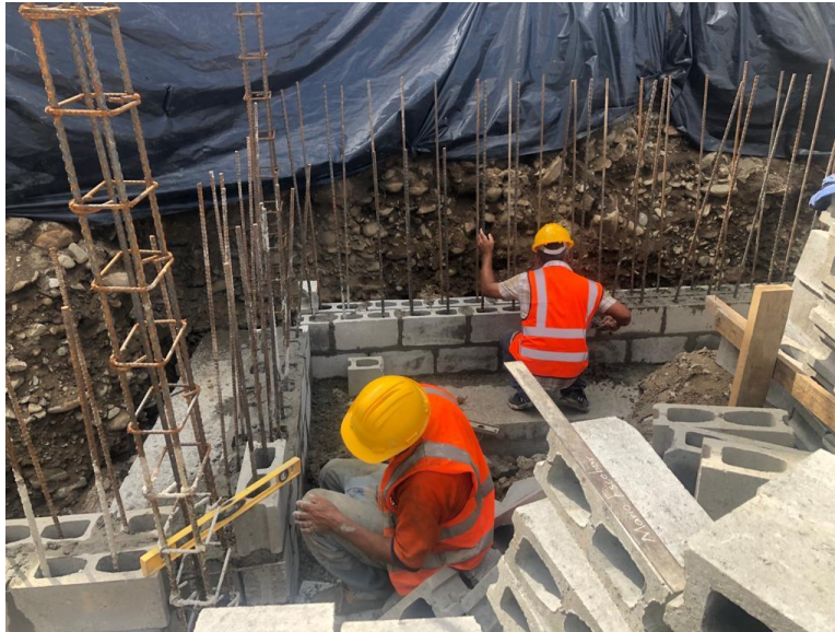
Ilustración 61 – pegado de bloques en sobre elevación de muro MC-1
