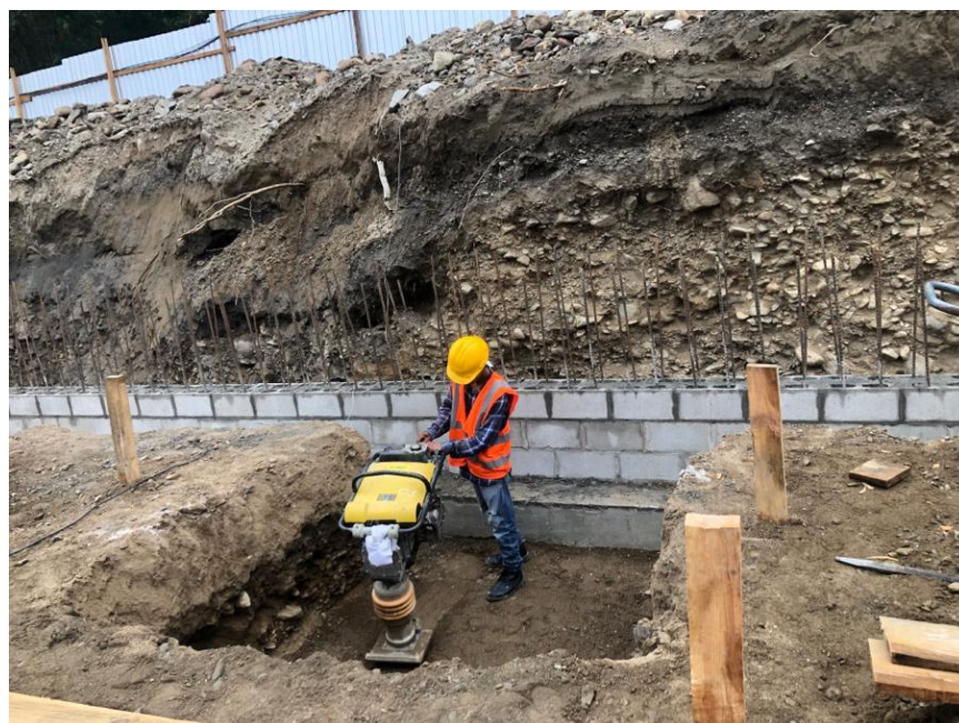
Ilustración 58 – Actividades de Compactación de terreno y pegado de bloques
