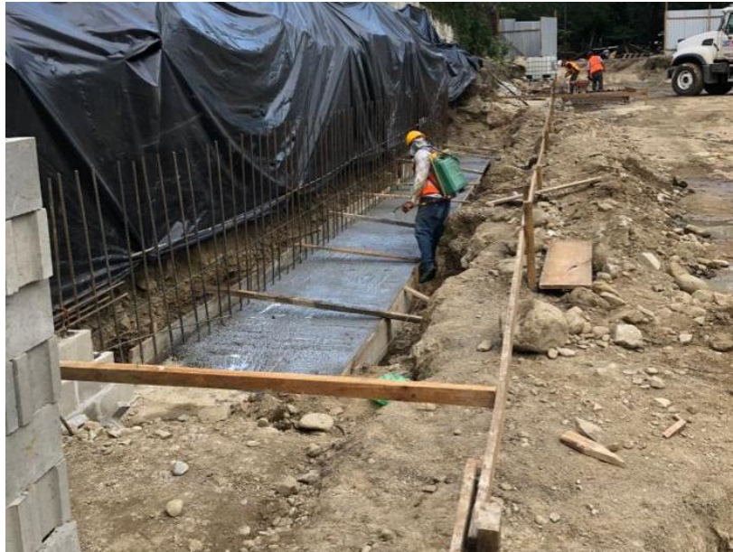
Ilustración 77- Aplicación de curador en cimiento corrido
