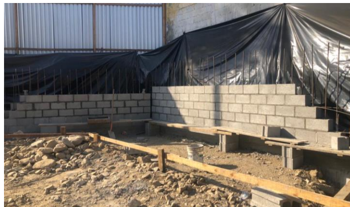
Ilustración 51 – Pegado de bloques muro MC-3
