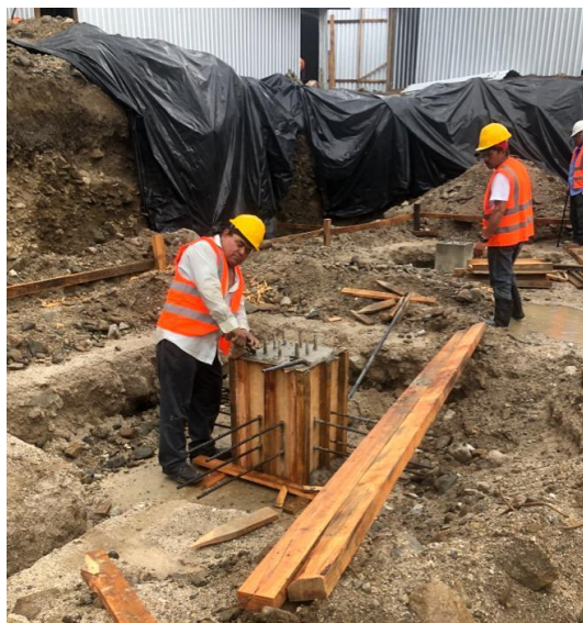
Ilustración 21 – Desencofrado de pedestales
