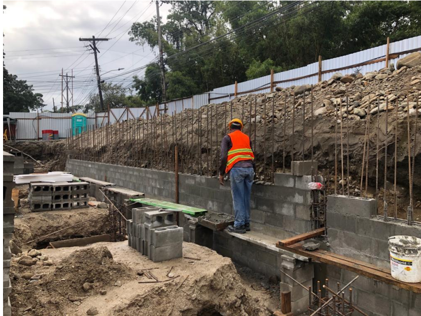
Ilustración 67 – Pegado de bloques
