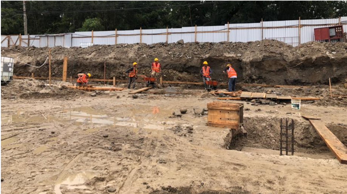
Ilustración 23 – Excavación para cimiento corrido de muro frontal
