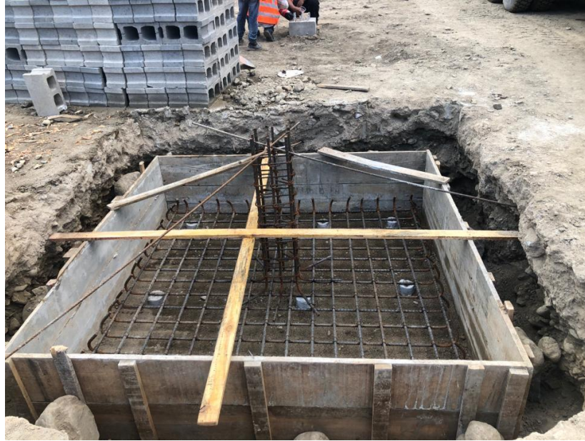
Ilustración 73 – Encofrado y colocación de armado de refuerzo en zapata aislada
