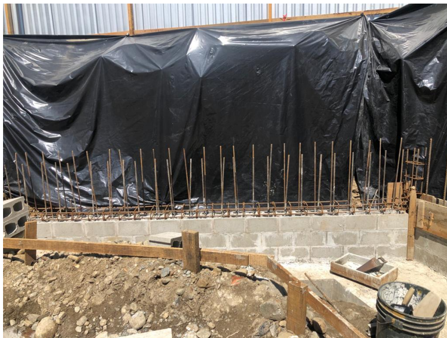
Ilustración 32 – Colocación de armado solera inferior
