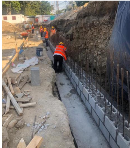
Ilustración 52 – pegado de bloques muro MC-1
