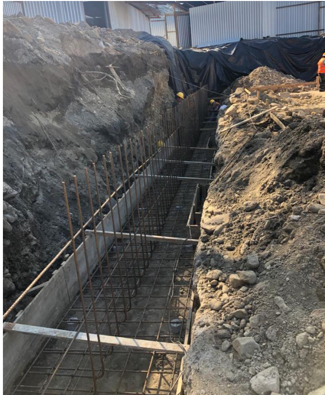
Ilustración 30 – Colocación de armado cimiento corrido de muro MC-1
