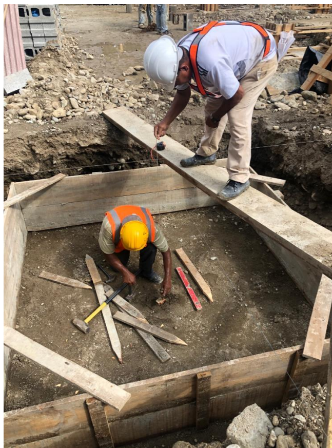
Ilustración 62 – Encofrado de zapata
