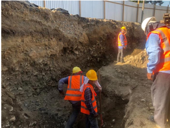
Ilustración 47 – Excavación para cimiento corrido de muro MC-1
