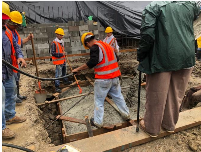
Ilustración 64 – Fundición y vibrado de zapata
