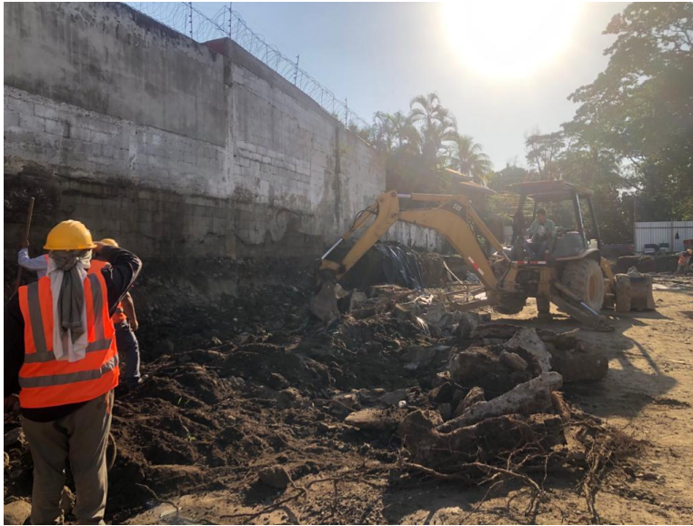
Ilustración 79 – Remoción del material desprendido
