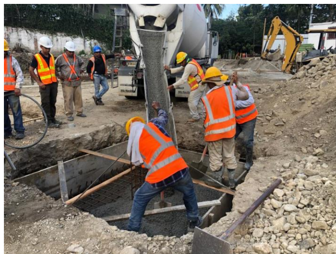
Ilustración 76 – Vaciado de concreto en zapata
