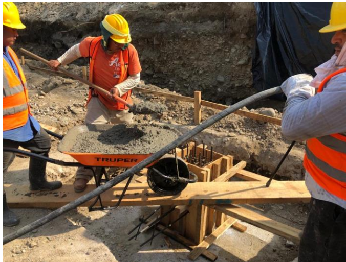
Ilustración 17 – Vaciado y vibrado de concreto en pedestal de zapata.
