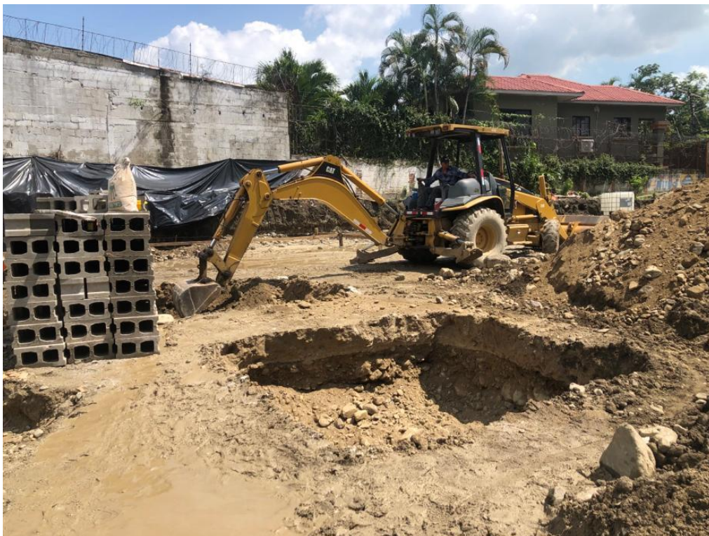
Ilustración 72 – Excavación de zapata
