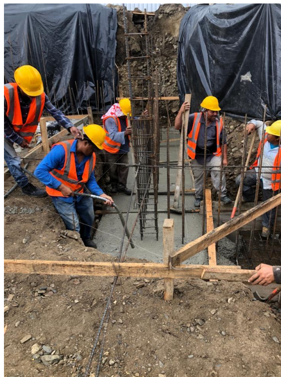
Ilustración 56 – Fundición de cimiento corrido
