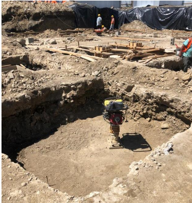
Ilustración 29 – Compactación de terreno donde irán situadas las zapatas
