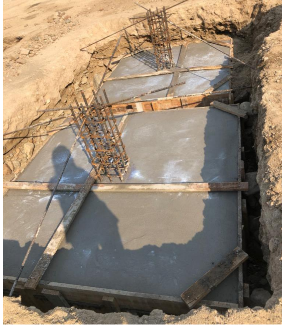
Ilustración 19 – Curado del concreto.
