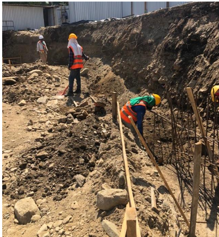
Ilustración 48 – Trabajos de excavación para cimiento corrido
