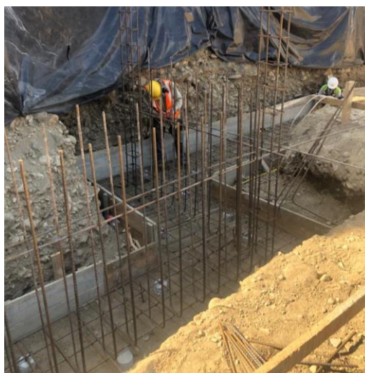
Ilustración 54 – Colocación de armado de cimiento corrido MC-1
