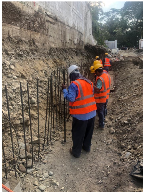
Ilustración 80 – Arreglo del refuerzo dañado
