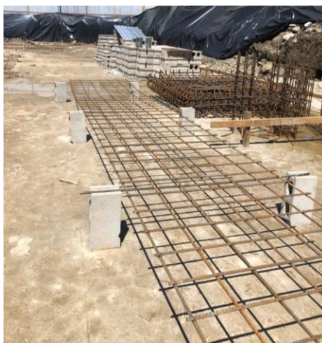
Ilustración 28 – Armado de cimiento corrido
