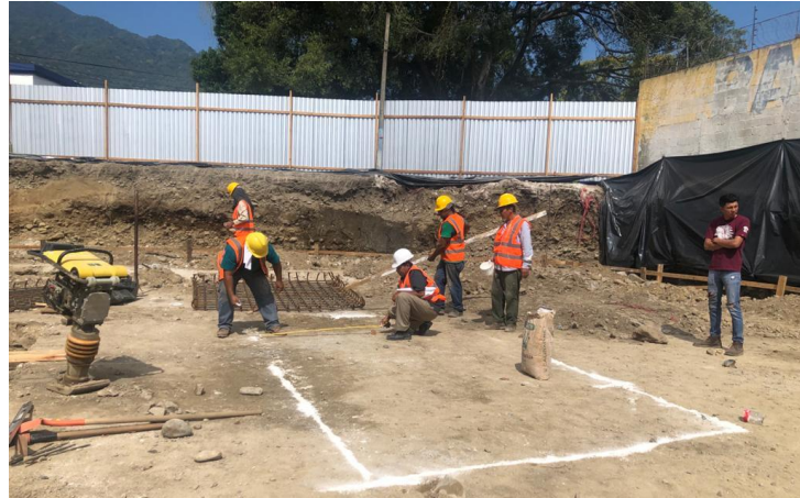
Ilustración 8 – Marcaje de zona a excavar para Zapatas Z-3 y Z-2
