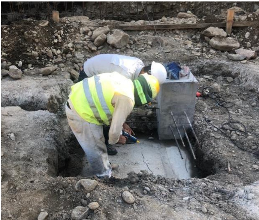
Ilustración 34 – Sellado de fisuras por temperatura en zapata
