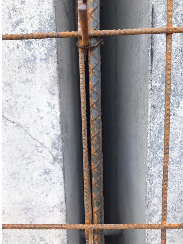
Figura 14: Revisión acero de refuerzo previo a fundición de casa.
