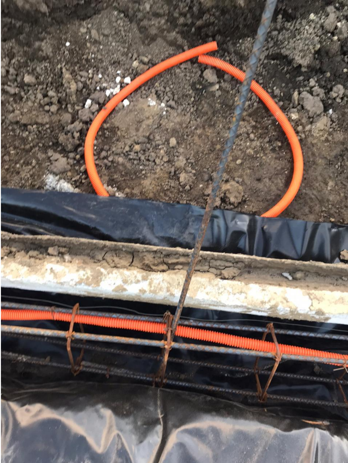
Figura 9: Cimbra para fundición de losa.
