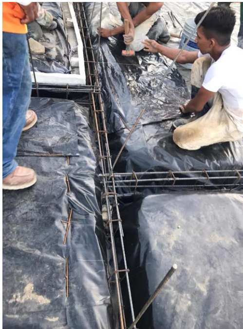
Figura 4: Revisión de Acero previo a fundición de losa.
