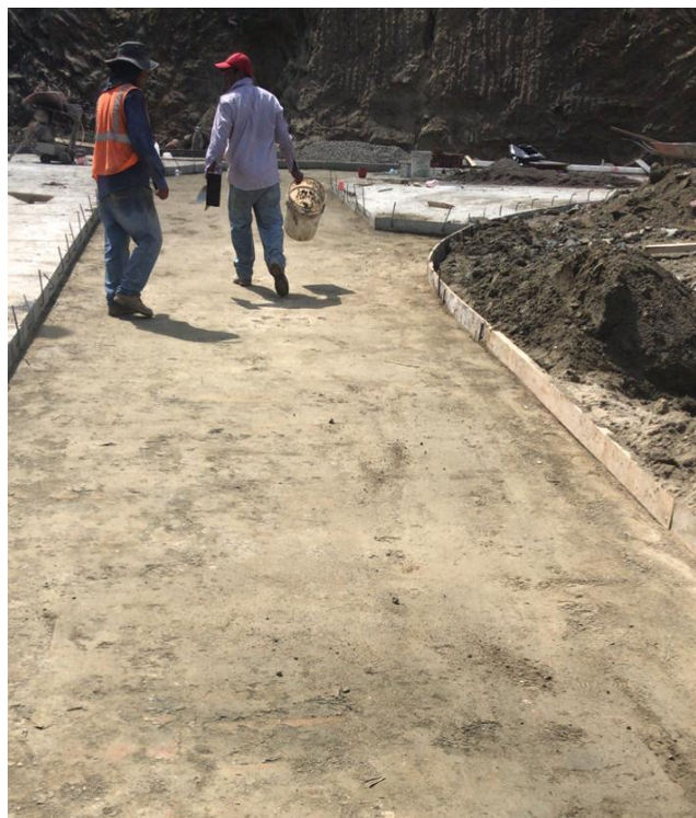
Figura 13: Liberación de pavimento 6 avenida conectando con 10 calle.
