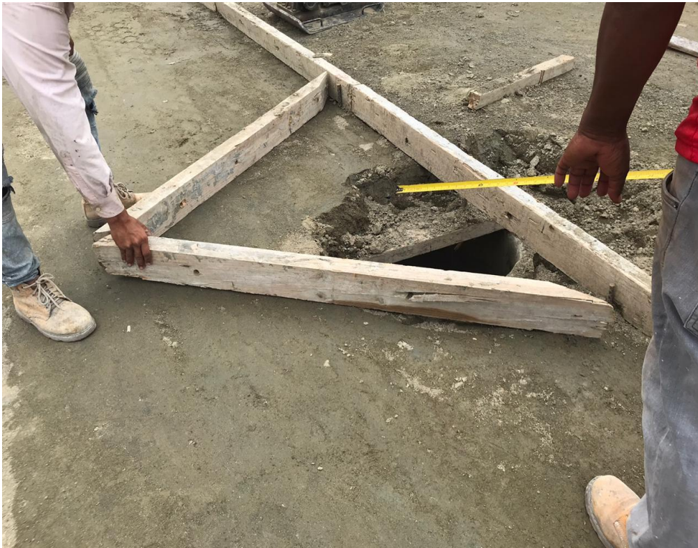
Figura 5: Delimitación de junta de diamante para fundición de pavimento.
