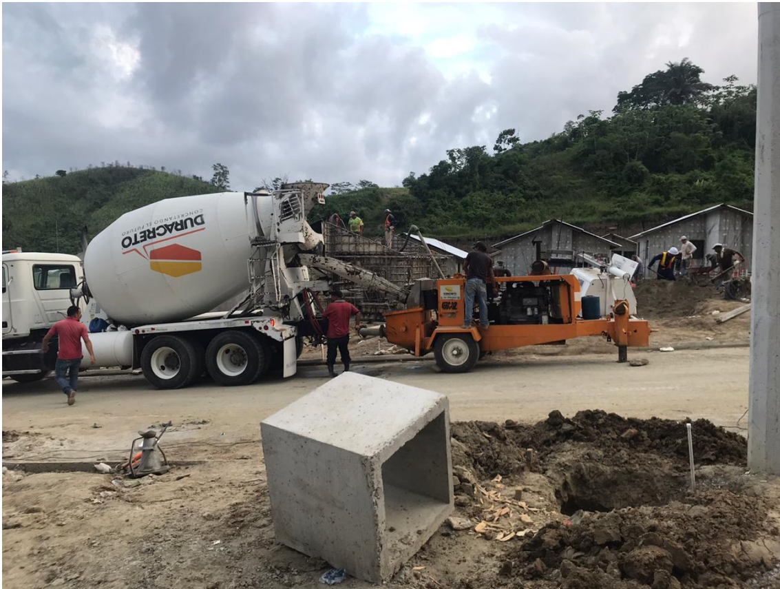
Figura 10: Mixer y bomba para fundición de paredes en bloque 25.
