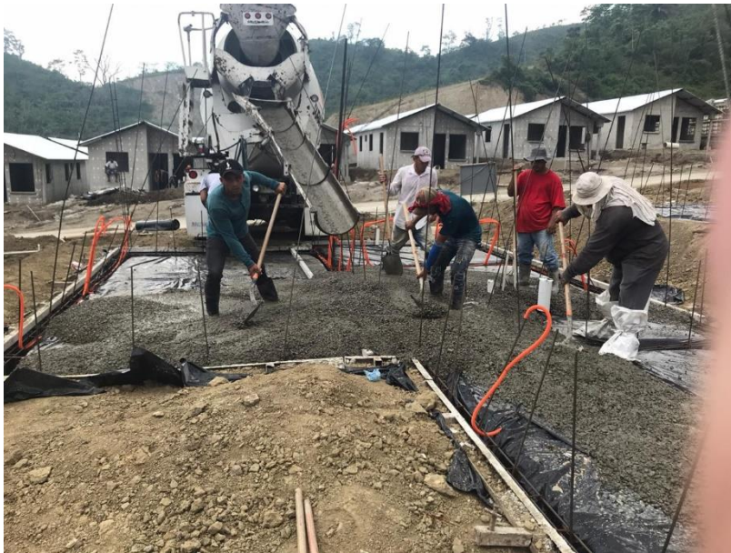
Figura 1: Fundición de Losa de Concreto.
