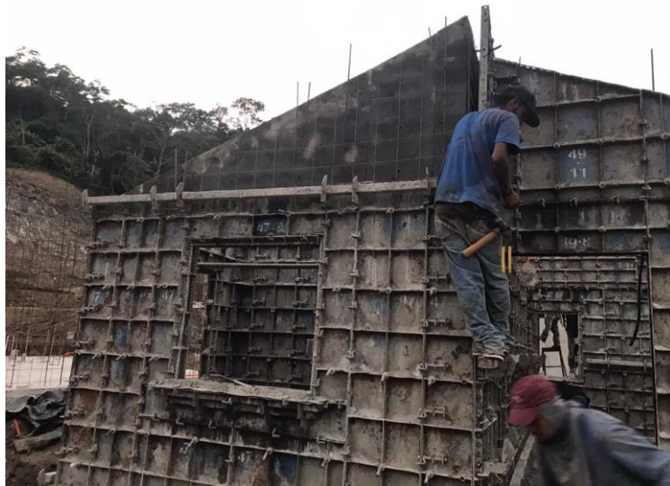
Figura 15: Armado y encofrado para fundición de casa en bloque 26.
