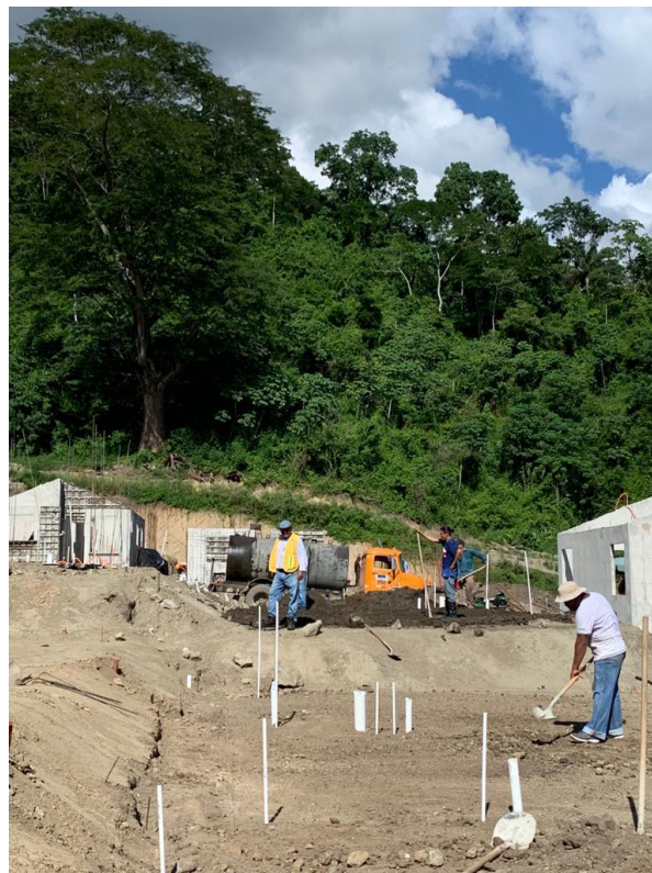
Ilustración 18 – Colocación de fontanería
