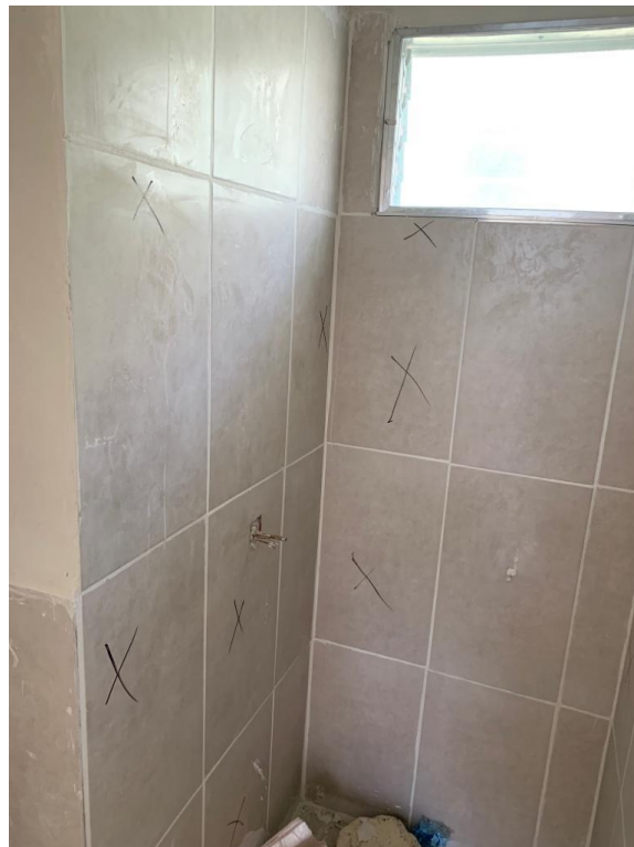
Ilustración 16 – Revisión de cerámica hueca
