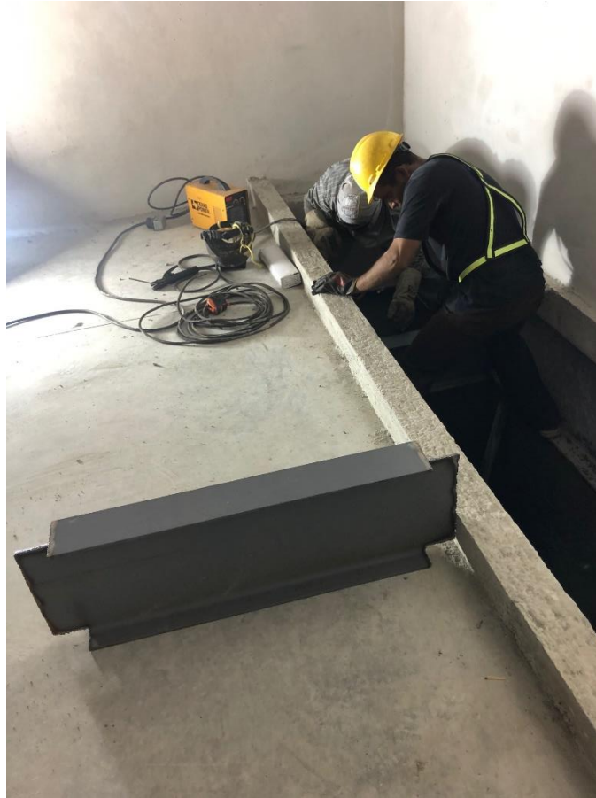
Figura 12. Colocación de vigas en cuarto eléctrico del sótano-1.
