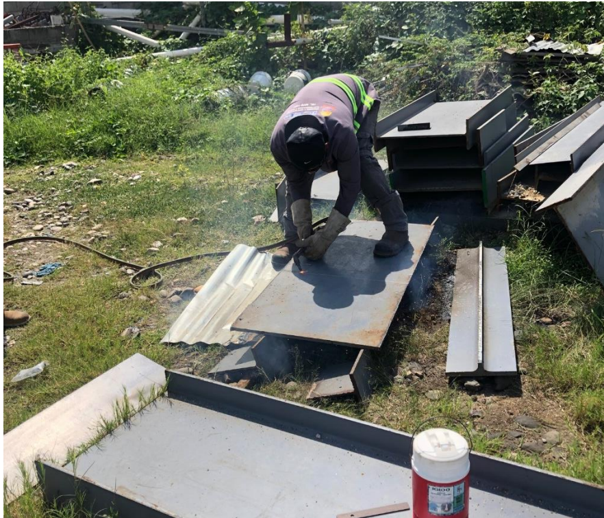
Figura 2. Corte de placas a mano.
