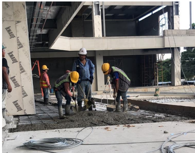
Figura 10. Fundición de losa.
