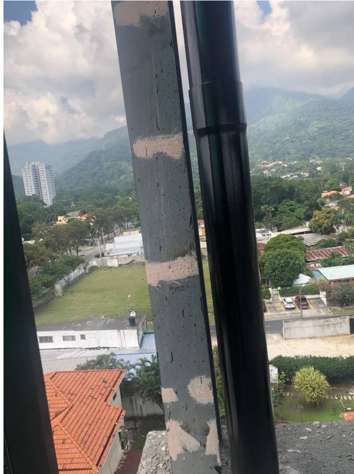
Figura 7. Preparación de columnas para pintado.
