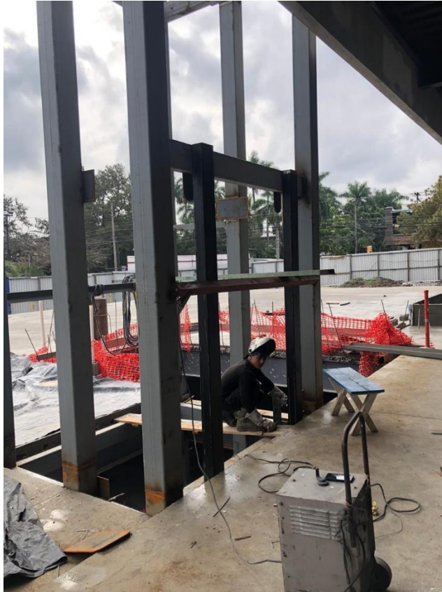
Figura 11. Colocación de placas en estructura de elevador exterior.
