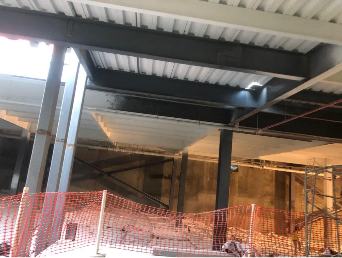
Figura 9. Entrepiso del sótano con áreas pendientes a pintar de blanco.
