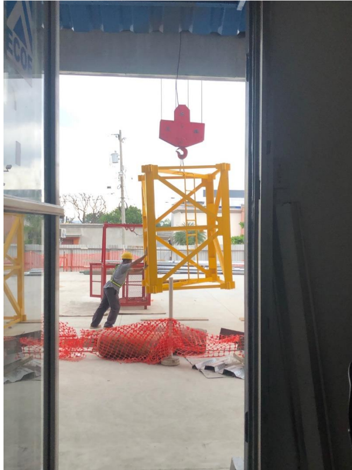
Figura 5. Desmante de grúa torre
