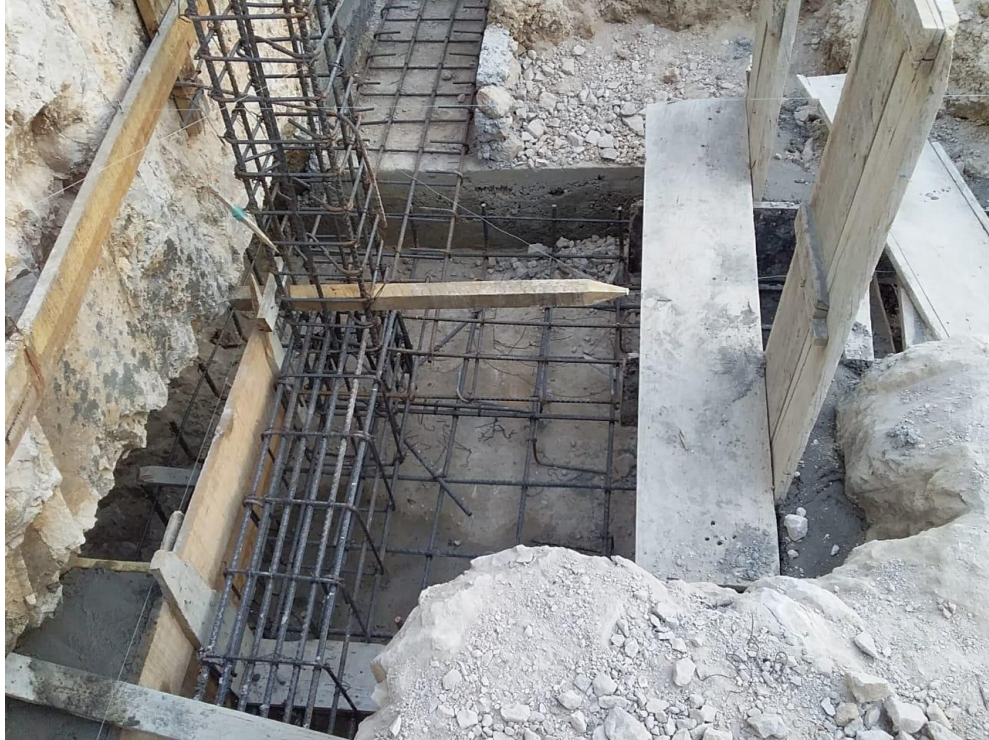
Imagen 16. Acero de refuerzo y encofrado para zapatas aisladas
