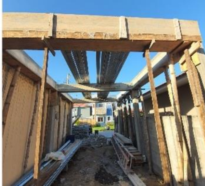
Imagen 6. Encofrado de vigas de concreto
