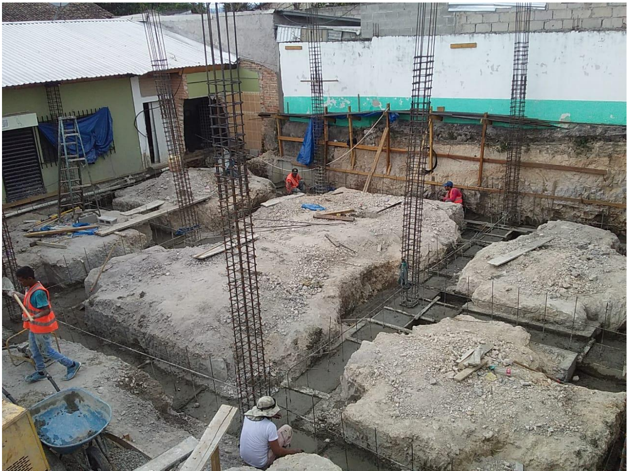
Imagen 17. Fundición de cimentaciones
