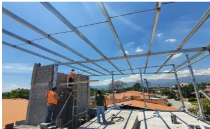
Imagen 12. Steel framing en Villa Valencia
