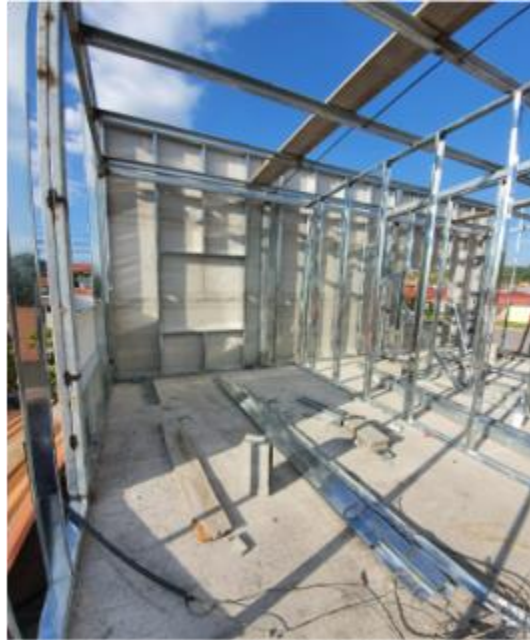
Imagen 14. Forrado de estructura metálica
