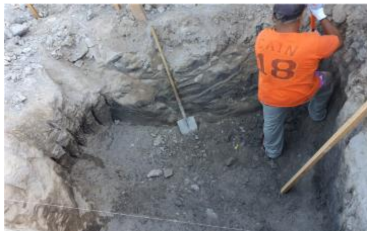
Imagen 13. Excavación de zapata aislada en Plaza Bellota's
