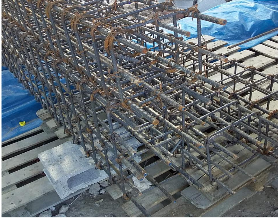
Imagen 20. Refuerzo de acero en columnas de Plaza Bellota's
