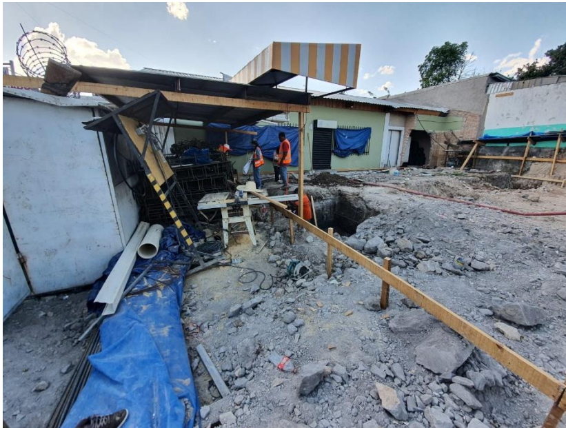
Imagen 21. Bodega temporal de materiales
