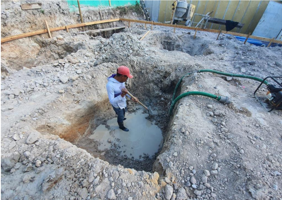
Imagen 18. Succión de filtración de agua en excavación con bomba
