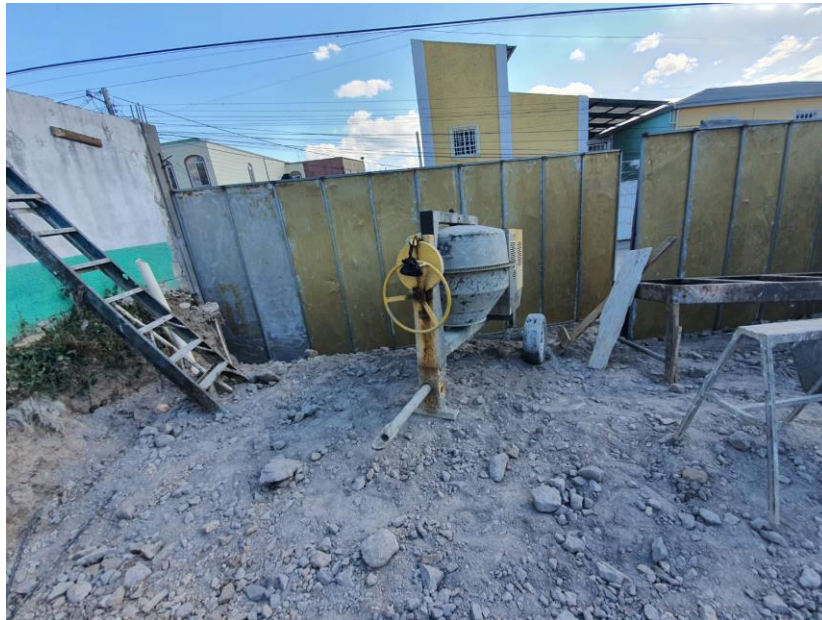
Imagen 19. Muro perimetral del proyecto Plaza Bellota's
