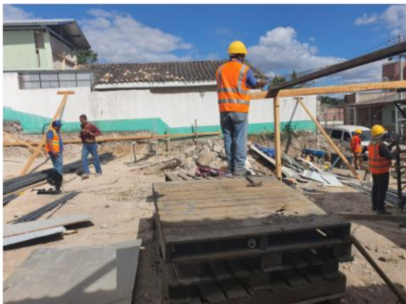
Imagen 11. Apoyos en muro perimetral y construcción de bodega
