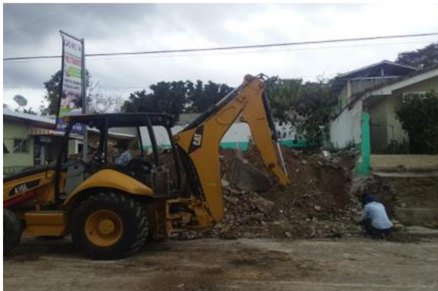
Imagen 10. Movimiento de material mediante retroexcavadora
