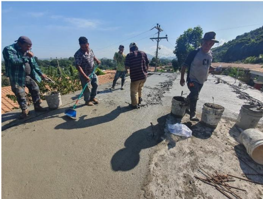
Imagen 7. Fundición de losa de entrepiso
