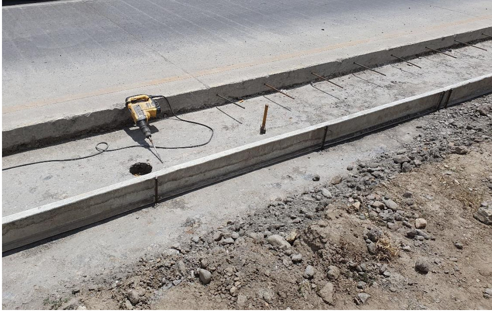
Figura 100. Colocación de dovelas.
