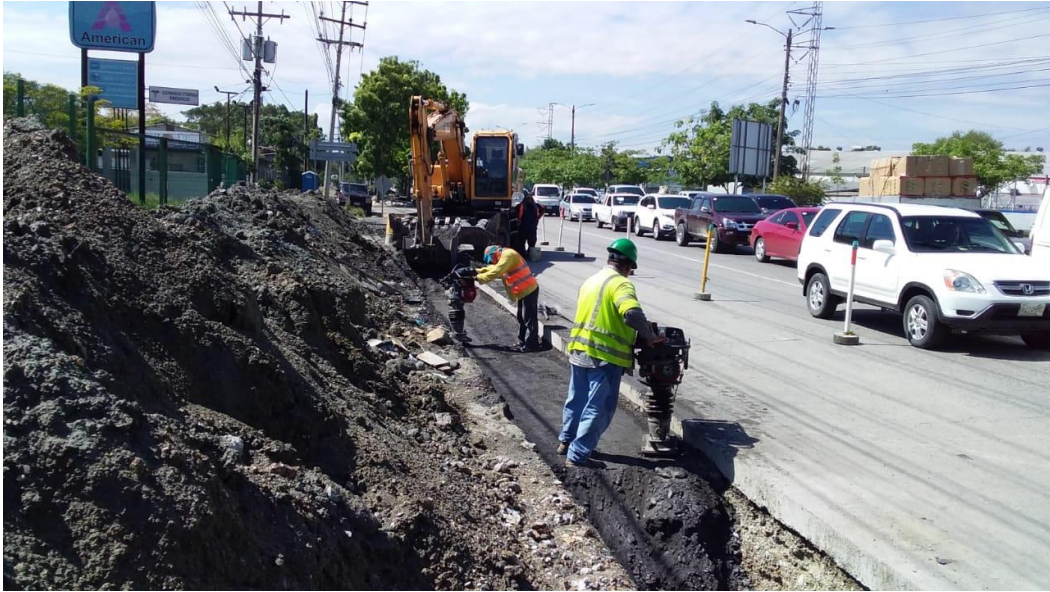
Figura 110. Relleno y compactación con material selecto de pozo 24, colector B.
