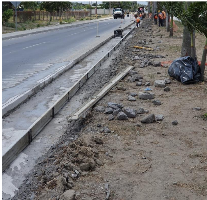
Figura 103. Tramo preparado para fundición.
