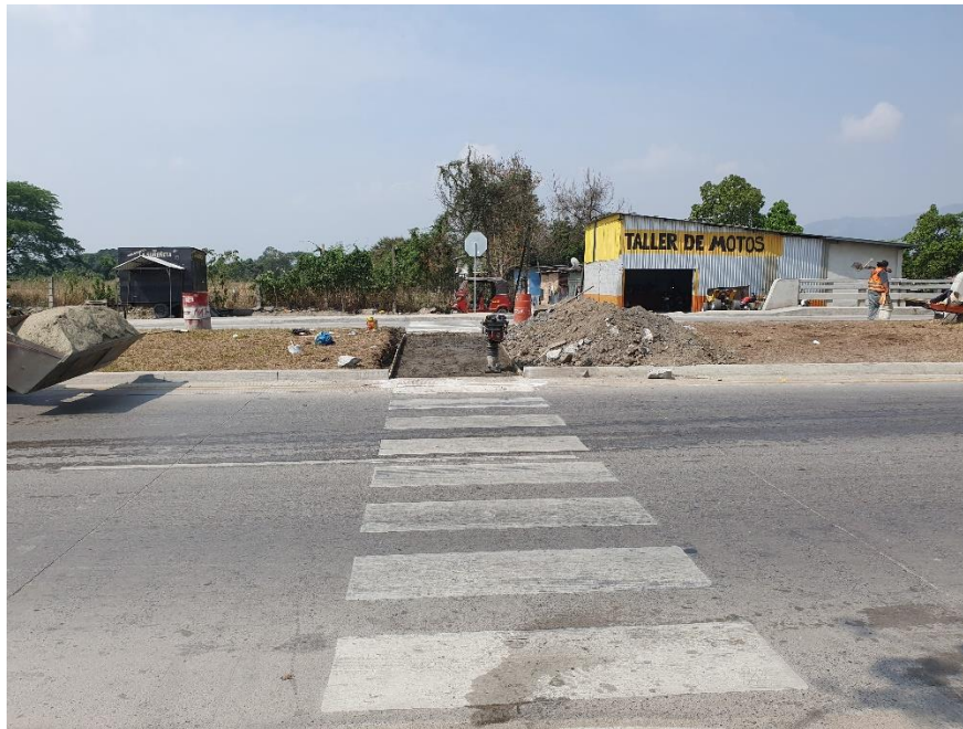
Figura 93. Elaboración de paso peatonal en mediana.
