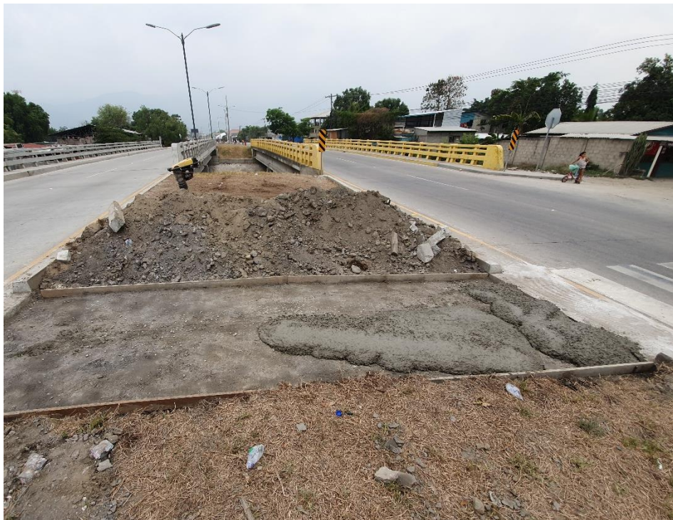
Figura 95. Fundición de paso peatonal en mediana.
