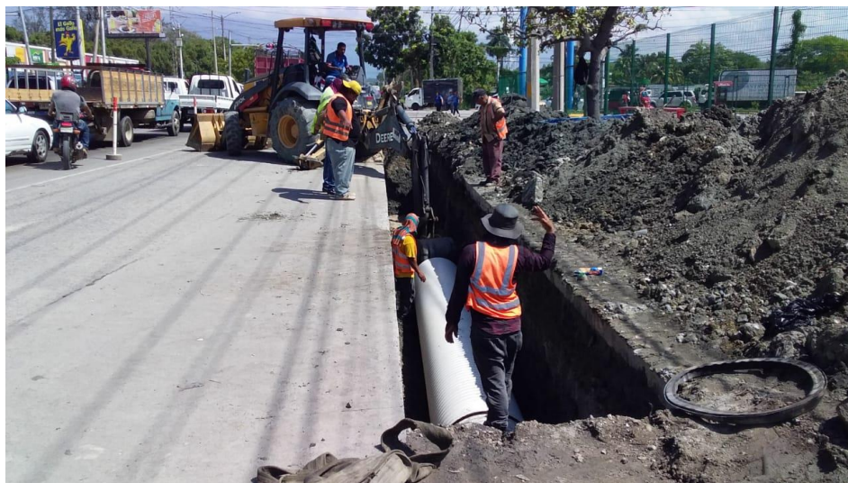
Figura 109. Colocación de tubería de 30" , 27 Calle.
