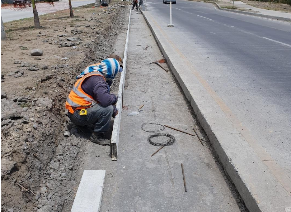
Figura 102. Instalación de encofrado.
