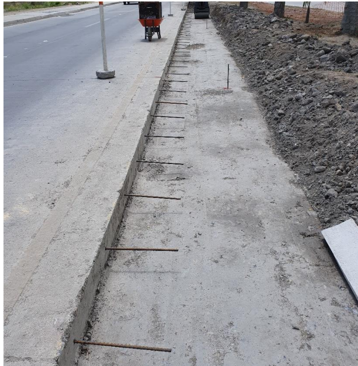
Figura 101. Dovelas y conformación de base suelo-cemento.
