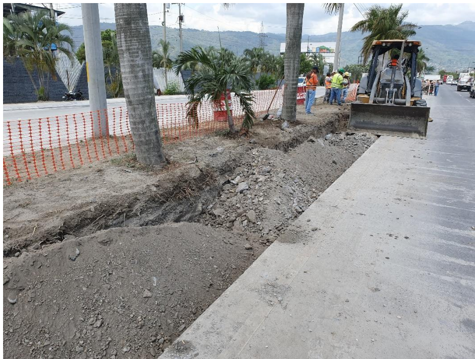
Figura 99. Relleno de material selecto del Polvorín.
