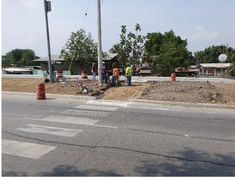
Figura 94. Compactación de base de paso peatonal.
