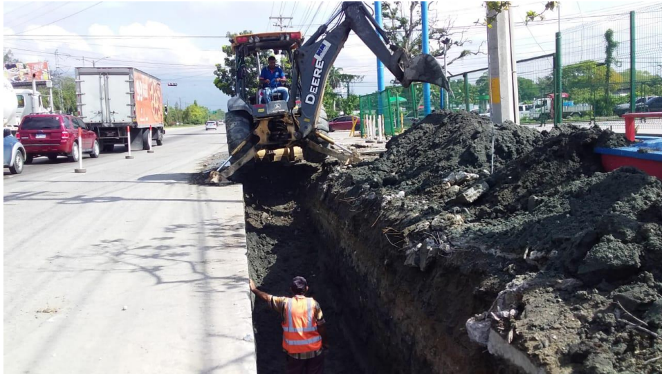
Figura 108. Excavación para tubería de 30" de diámetro, 27 Calle.
