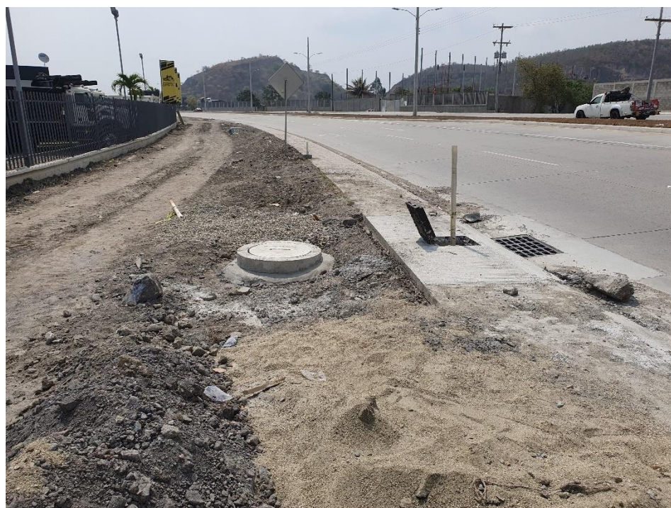
Figura 97. Inspección de pozos de recolector ALL.
