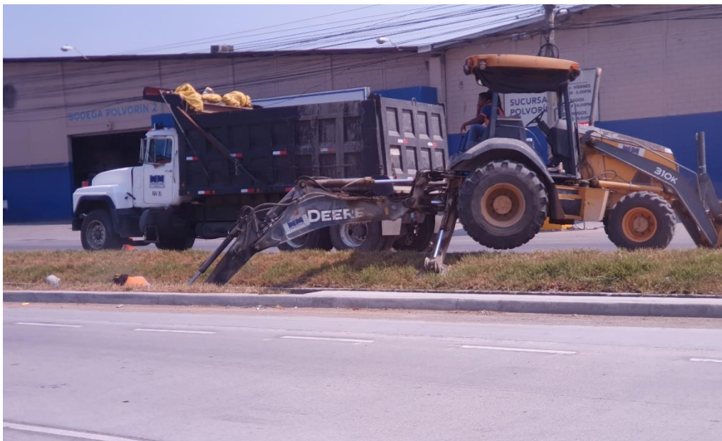
Figura 96. Limpieza de canal abierto.
