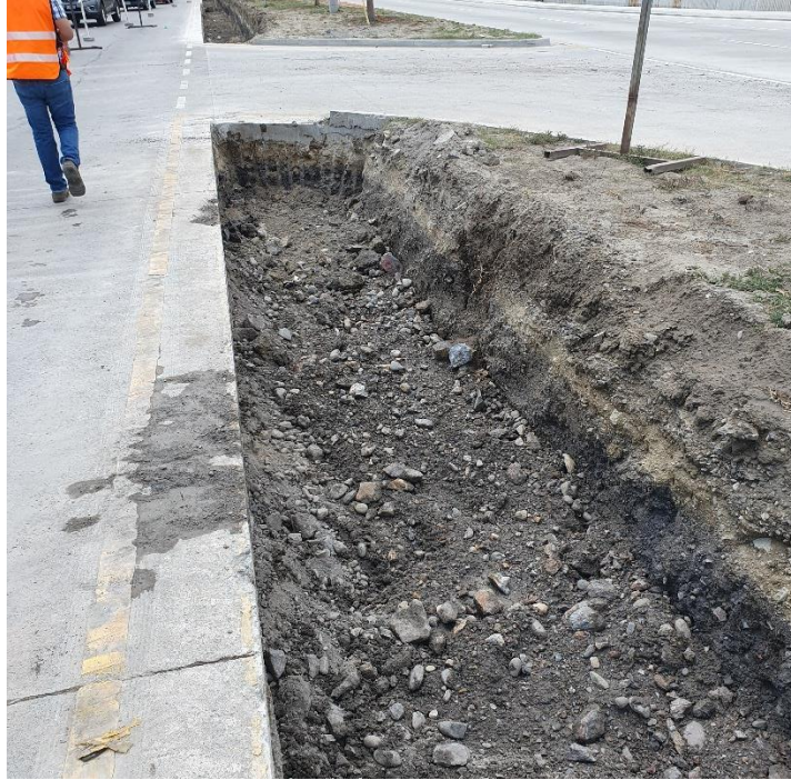
Figura 98. Relleno de material para ampliación de calzada.
