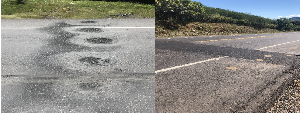
Anexo 21 – Antes y Después Bache por quema de llantas EST. 31+740.2 DER
