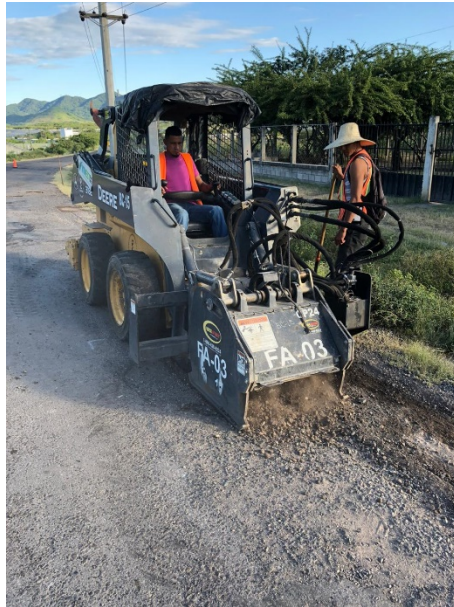
Anexo 9 – Bocat BC-15 con aditamento de Fresado
