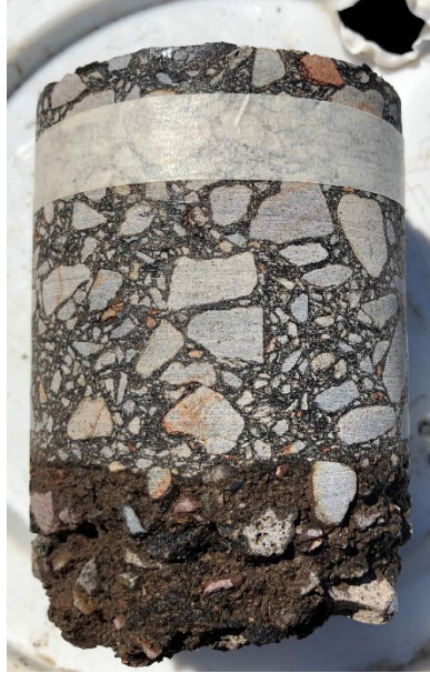
Anexo 17 – Núcleo de carpeta asfáltica
