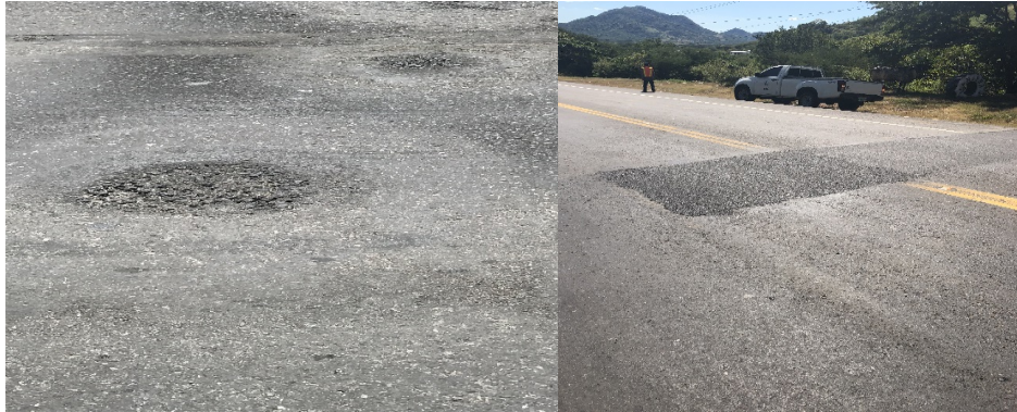
Anexo 22 – Antes y Después Bache por quema de llantas EST. 31+740.2 IZQ
