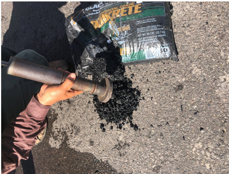
Anexo 16 – Llenado y compactado de los huecos de briquetas con asfalto en frío
