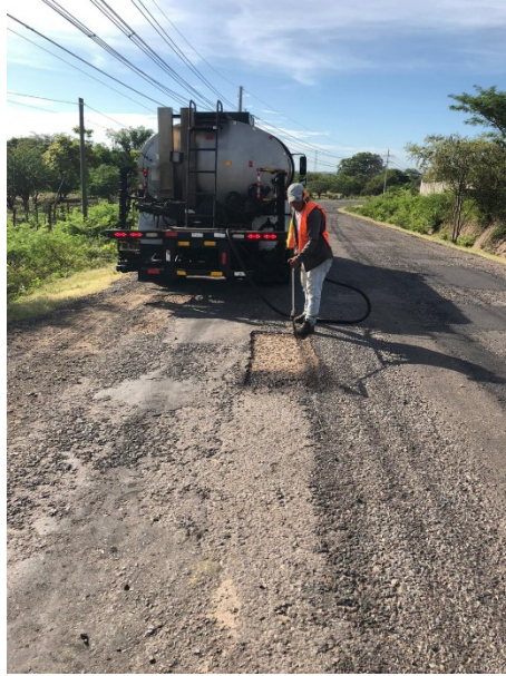
Anexo 11 – Distribuidora de Asfalto DA-06
