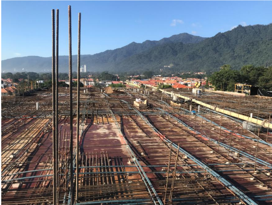
Ilustración 21. Armado de Losa de Entrepiso
