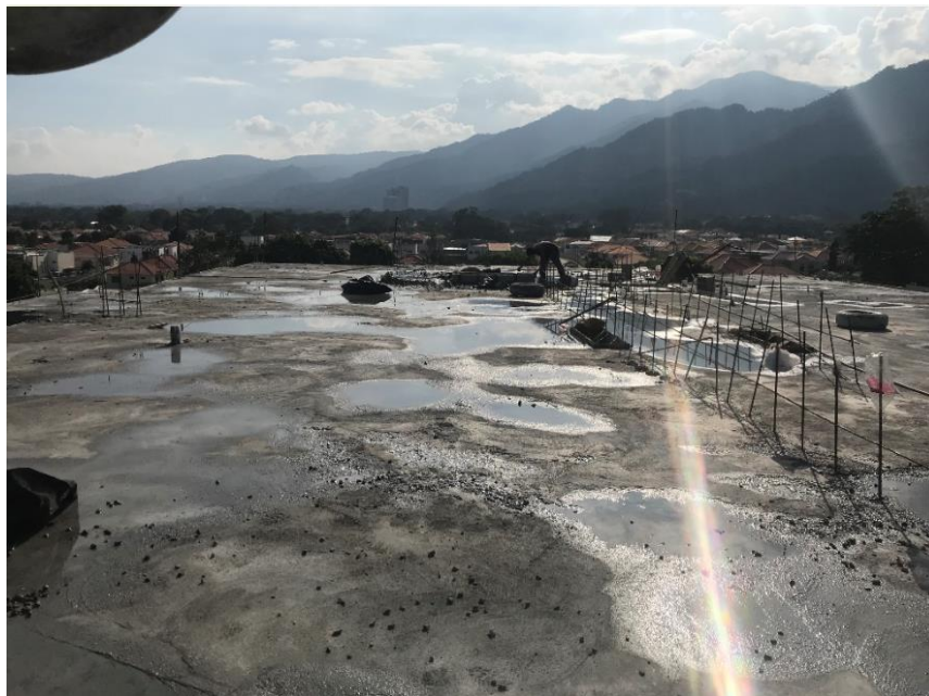
Ilustración 22. Curado de Losa de Entrepiso
